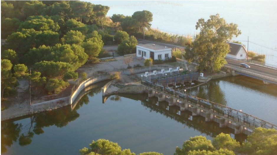
Figura 73: Edificio del grupo electrógeno de la Gola del Pujol
