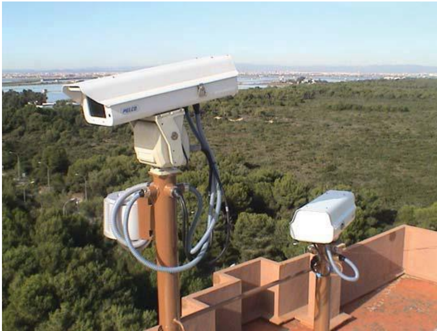
Figura 30: Cámaras térmicas fija y móvil ubicadas en el edificio Gola nº 4, junto a panorámica de la zona vigilada
