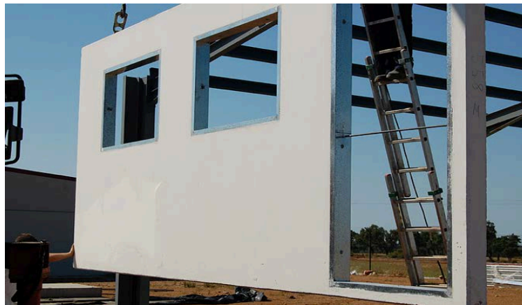
Figura 4 Panel prefabricado hormigón con espesor de 16 cm
