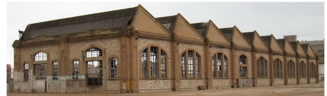
4.8 / 4.9 / 4.10 Volumetría inicial del conjunto industrial. Vista actual de la fachada principal, en la c/San Vicente Mártir. Estado de conservación de una de las naves con cubierta en diente de sierra.
