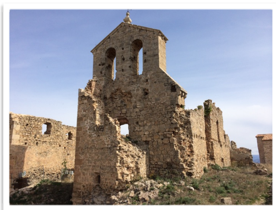
Imagen 15: Fachada Oeste donde se observa la Espadaña del siglo XVI caracterizada por sus dos ojos para los bronces. Actualmente es lo que mejor estado de conservación tiene.
