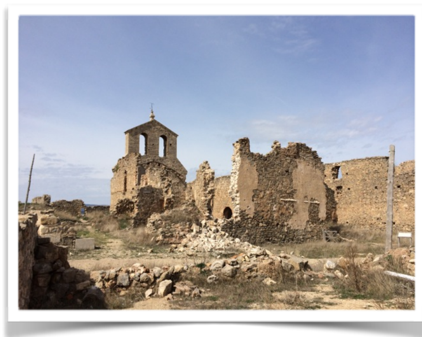
Imagen 7: Vista general de 'La Iglesia de la Trinidad' , actualmente en avanzado estado de deterioro casi en su totalidad.
