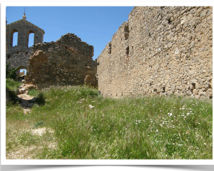
Imagen 10: Fachada Este donde aún se conservan los restos de viejos revestimiento en el paramento de piedra de mampostería.
