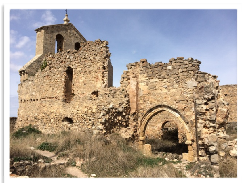
Imagen 8 : Fachada Sur , Paño de piedra de mampostería con macizos. Derruido casi en su totalidad en uno de sus extremos.
