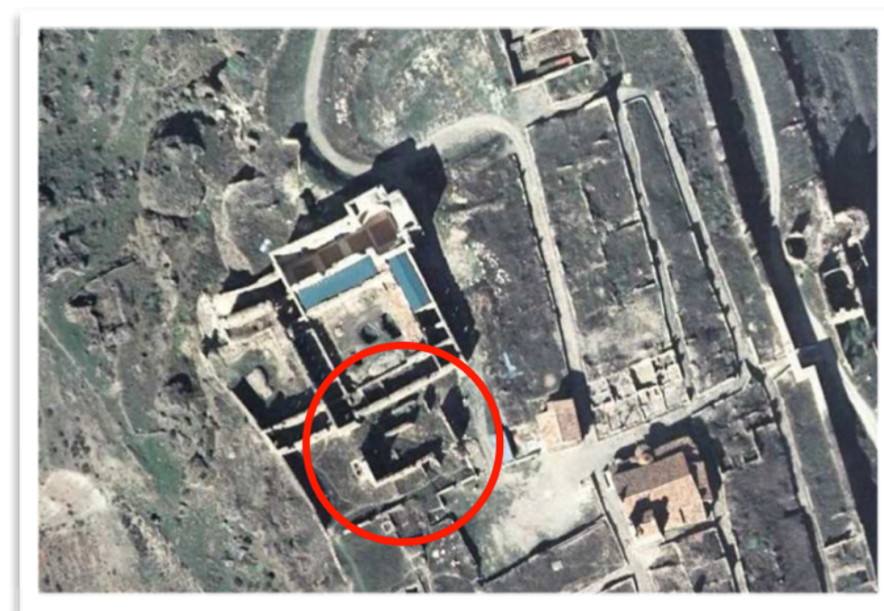
Imagen 5: Vista aérea (fuente: Iberpix, Instituto Geográfico Nacional) donde se indica con un círculo rojo la ubicación de la "Iglesia de la Trinidad" que vuelca en sus fachadas Sur y Este a la Plaza Mayor y en su fachada norte a un pequeño corredor anexo al Convento de los Concepcionistas.
