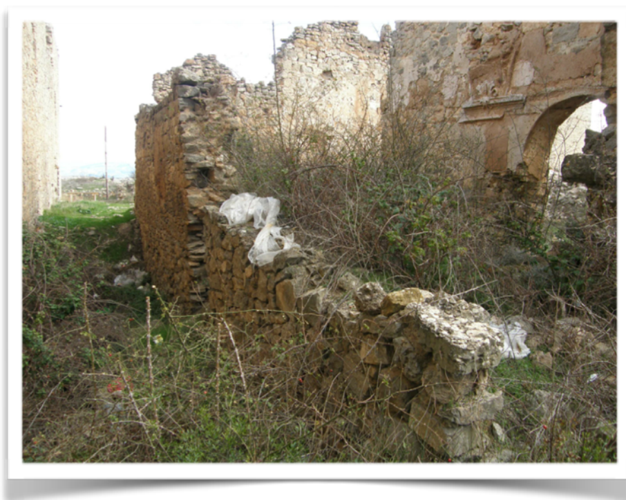
Imagen 13 : Vista lateral de la Fachada Norte donde se vislumbra la portada lateral, un arco de medio punto ornamentado, que comunica la nave principal de la Iglesia con los espacios residuales volcados al Convento.
