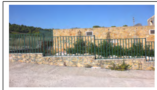
Vista exterior del depósito.
