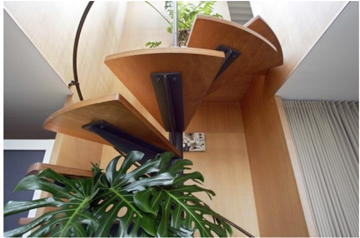
36. Detalle de la construcción de la escalera
