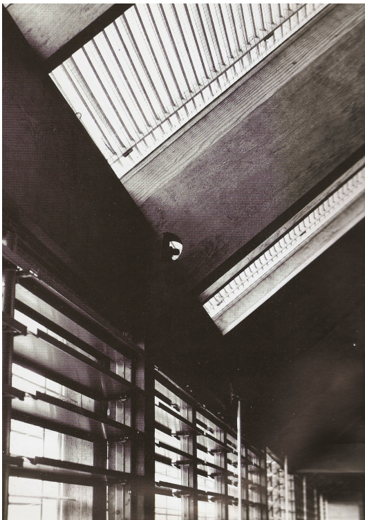
21. Lucernarios de la cubierta
