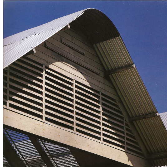
20. Cubierta corrugada con el frontón abierto para permitir la ventilación
