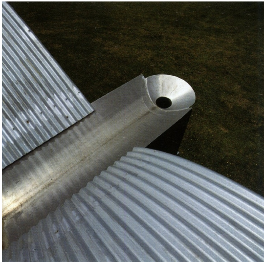
19. Gran canalón que recoge todas las aguas de las cubiertas
