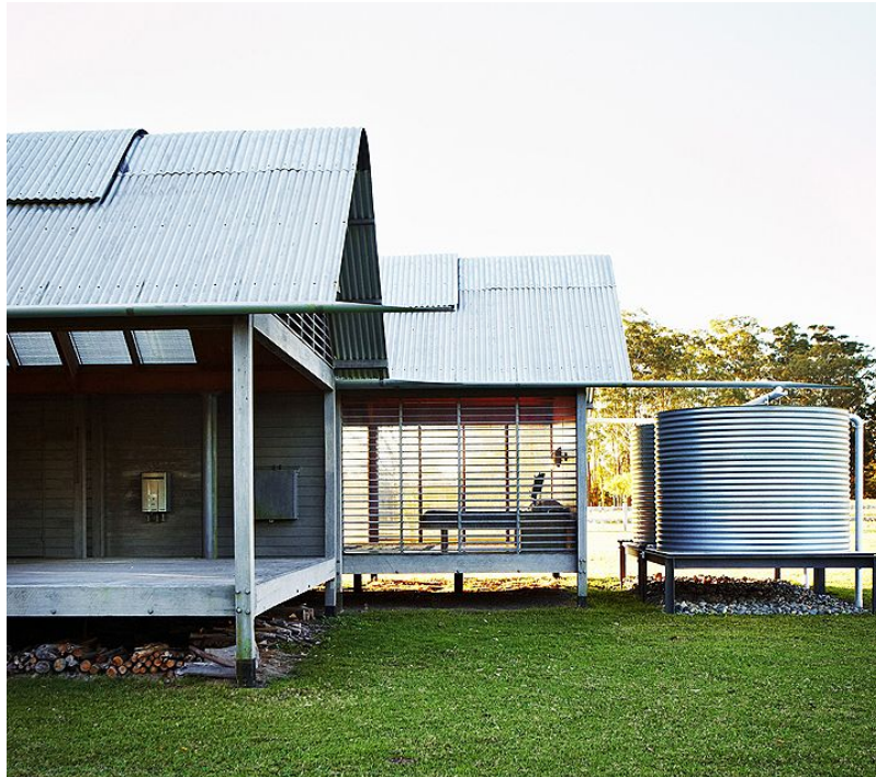
23. Depósito de agua también de acero corrugado
