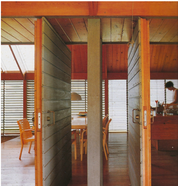
27. Puertas pivotantes que permiten la ventilación
