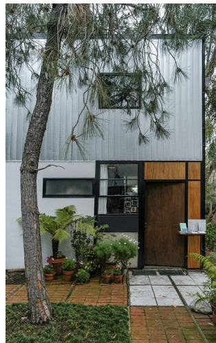
23 y 24. Fachadas laterales que dan al patio
