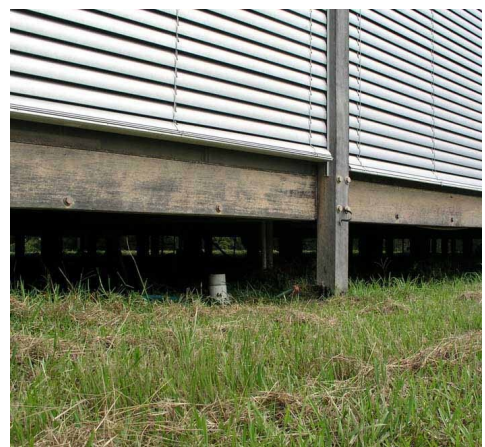
13. Edificio levantado del suelo 80 cm
