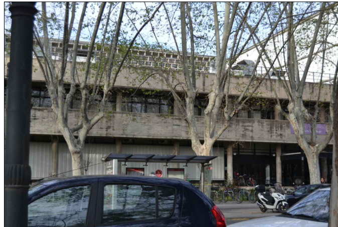
Fotografía Fachada Bar Derecho
