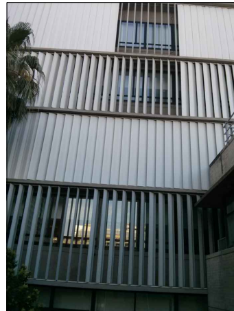
Fotografía Fachada Interior Agrónomos
