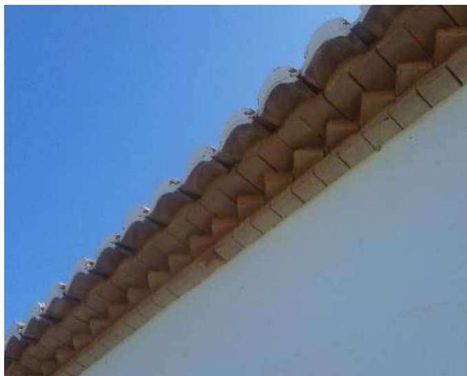
Figura 60 Vista del alero
