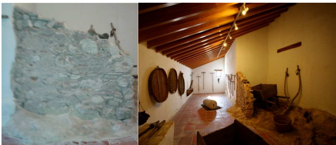
Figura 57 Foto detalle del murete "de restos" y su situación en el establo
