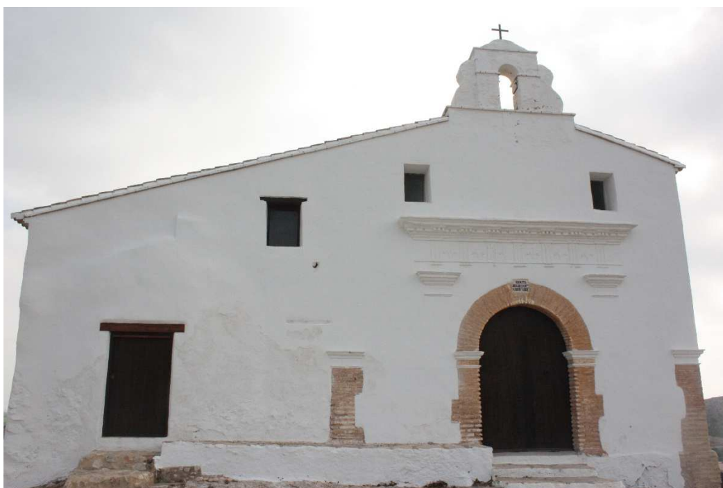
Figura 64 Portada en fachada norte
