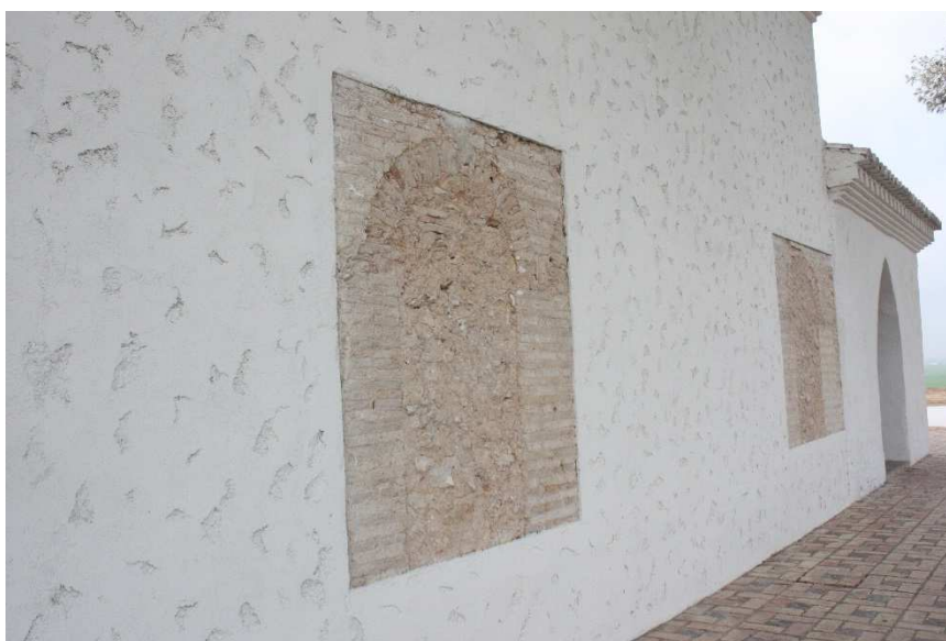
Figura 29 Ventanas arqueológicas en muro norte
