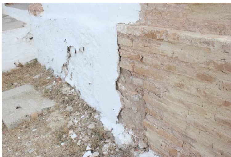
Figura 16 Zona de encuentro de la fábrica de ladrillo en remate de esquina con muro de mampostería y revestimiento de enfoscado de mortero de cal en la Ermita dels Sants de la Pedra de Cullera
