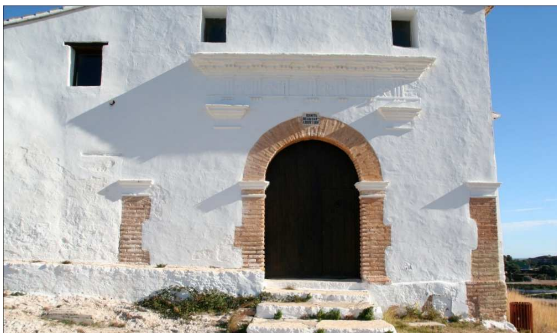
Figura 51 Arco de ladrillo cerámico y banco corrido.
