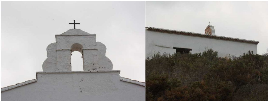
Figura 52 Detalle espadaña y vista de la ermita desde el camino de subida a la misma, se observa la materialidad de la espadaña de ladrillo cerámico ya que no se encuentra enfoscada por ese lado.
