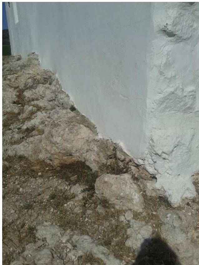
Figura 53 Encuentro del muro con el terreno
