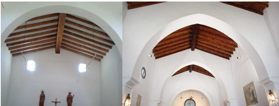
Figura 87 Arcos diafragma de la Ermita dels Sants de Cullera y tres de los cuatro arcos diafragma de la ermita dels Sants de Sueca
