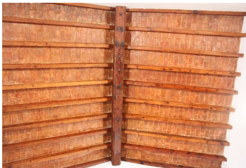
Figura 37 Vista de la cubierta desde el interior de la capilla
