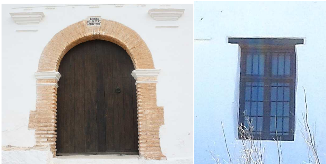
Figura 63 Puerta de entrada a la capilla y ventana en fachada este, se observa dintel de madera, reja de forja y carpintería de madera
