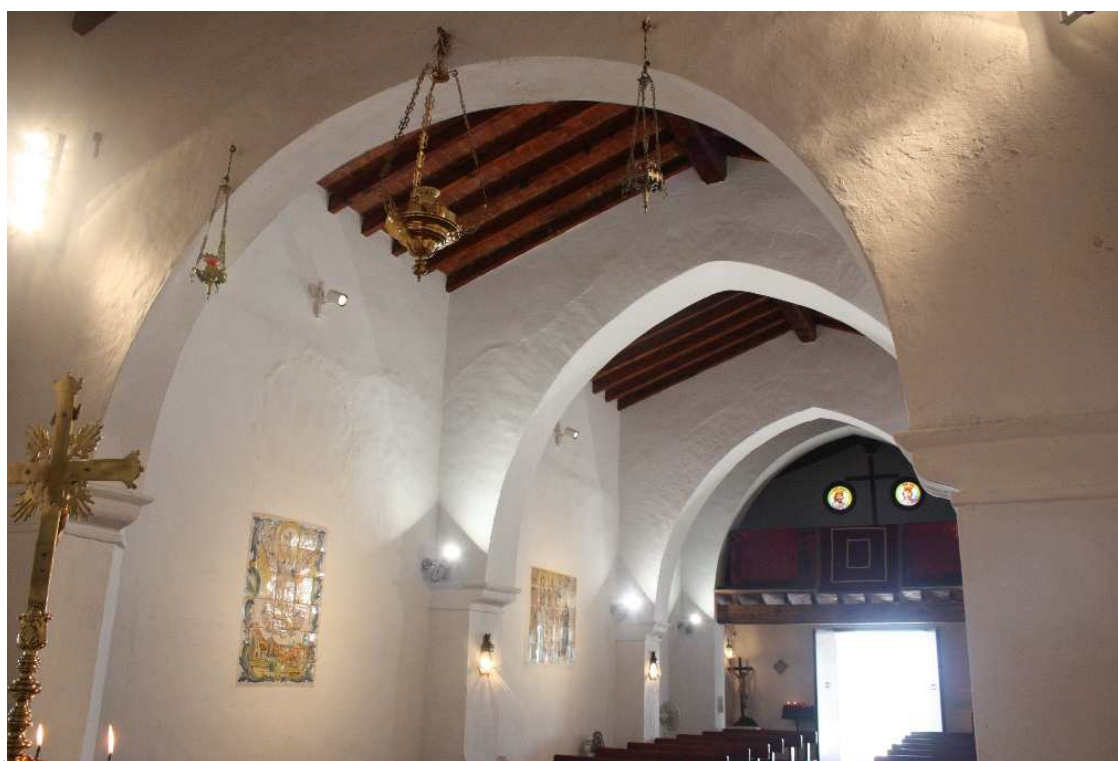
Figura 33 Arcos diafragma de la capilla. En primer plano se observa el arco de medio punto a modo de arco triunfal, y por detrás los tres arcos ojivales
