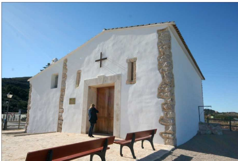
Figura 72 Fachada este donde se observan la puerta de entrada y los estrechos huecos y la fachada norte, donde se encuentra el pozo
