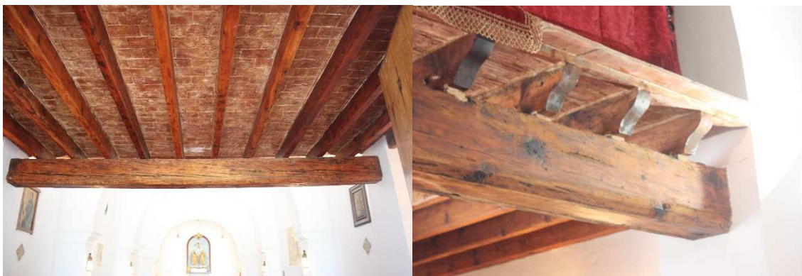
Figura 36 Vista cenital del forjado del coro y detalle forjado de madera del coro
