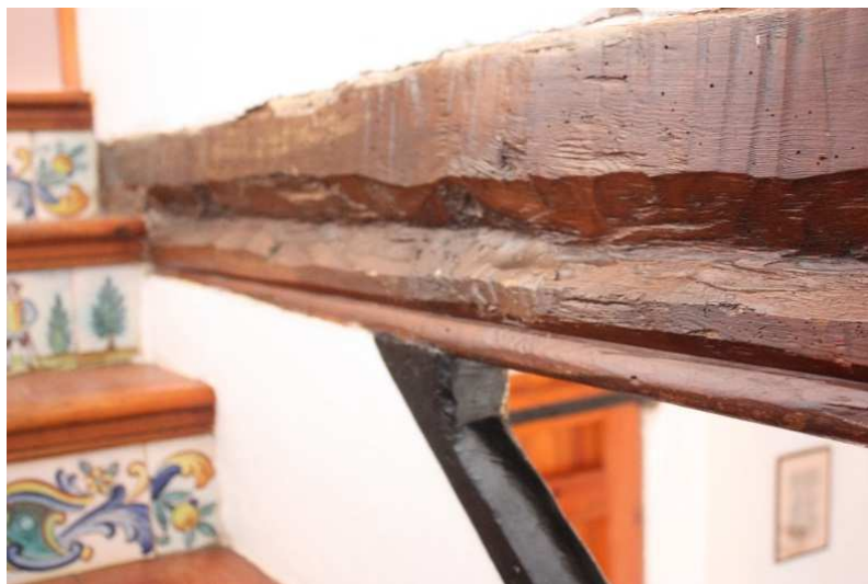
Figura 15 Vigueta del forjado de madera en la Ermita dels Sants de la Pedra de Sueca
