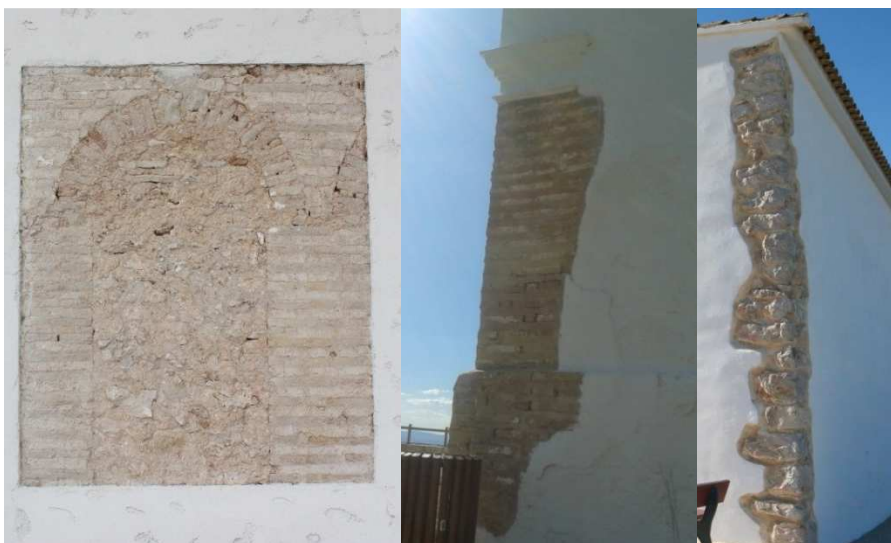
Figura 86 Ventanas arqueológicas dejadas en los muros de las distintas ermitas en las cuales podemos ver su materialidad.
