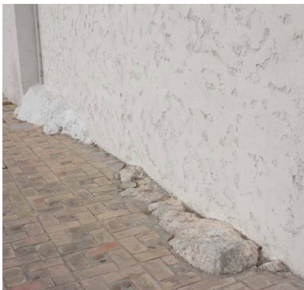
Figura 27 Fotografía encuentro del muro con la roca
