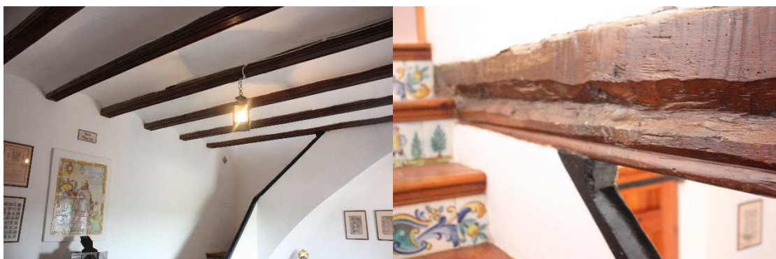
Figura 35 Vista del forjado en la zona de distribución de planta baja de la vivienda del ermitaño y escuadría de una vigueta del forjado
