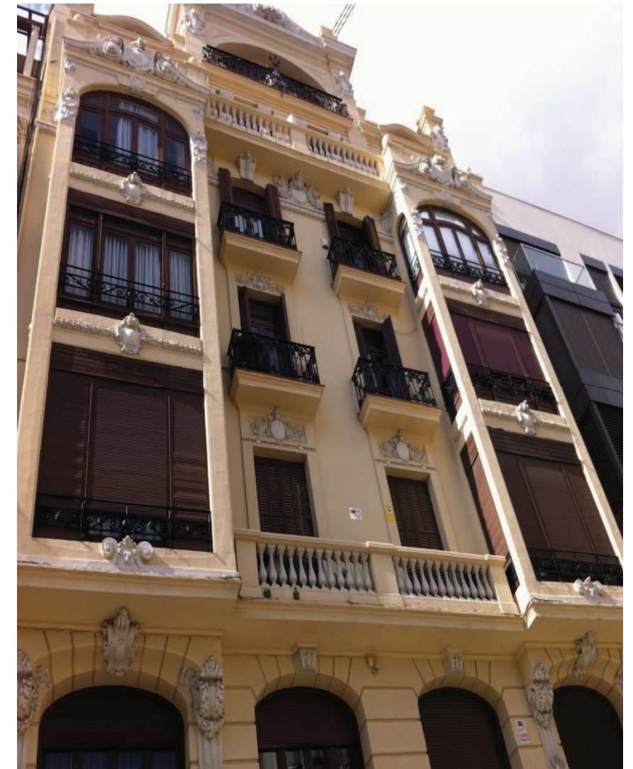
Figura A1.1. Fachada principal 3
