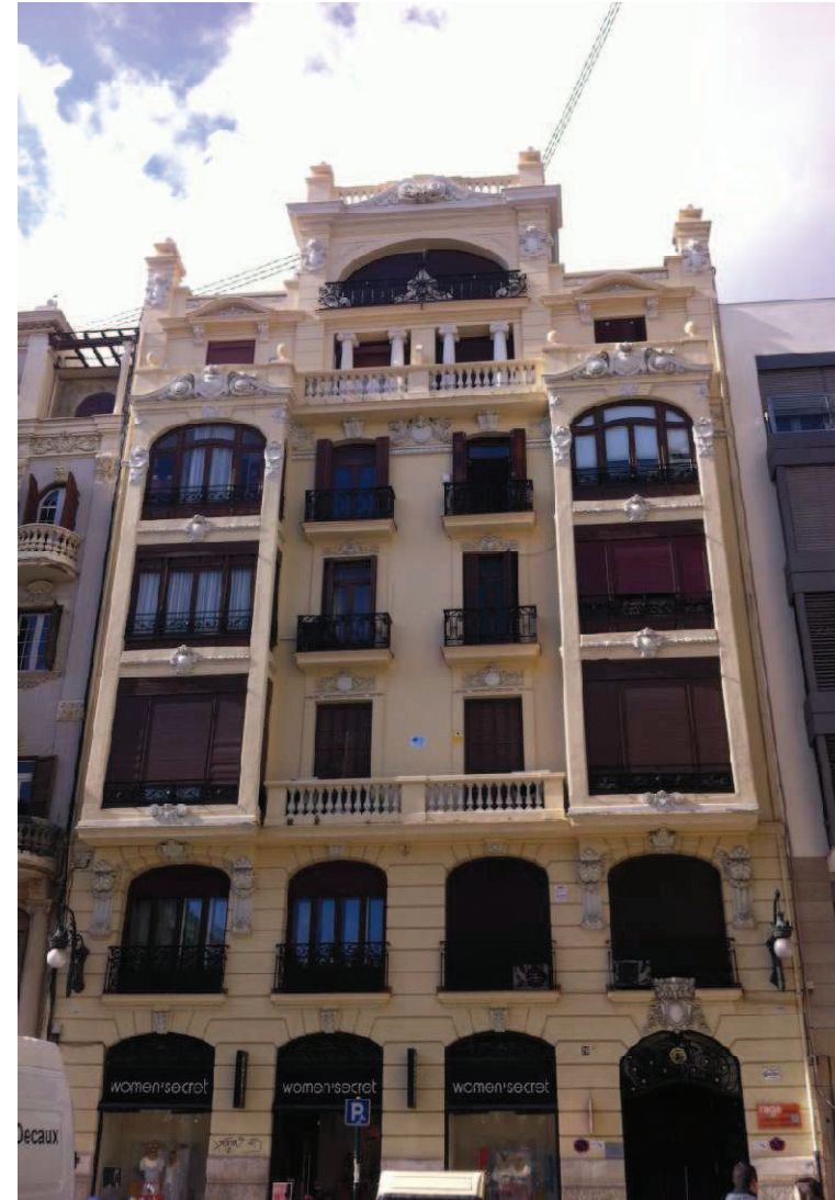
Figura A1.2. Fachada principal 2
