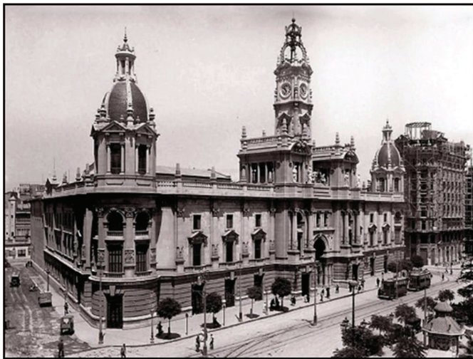
Figura 5. Fachada principal del Ayuntamiento de Valencia 1929 www.skyscrapercity.com
