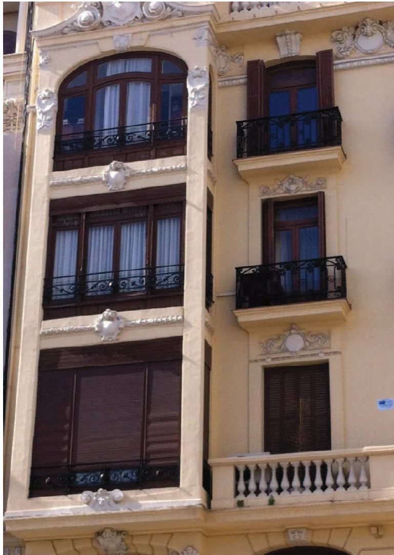
Figura A1.1. Fachada principal 1
