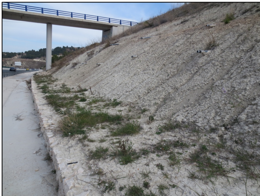
Figura 5.2.10. Aspecto del talud seleccionado para la extracción de material. DIT14-201.
