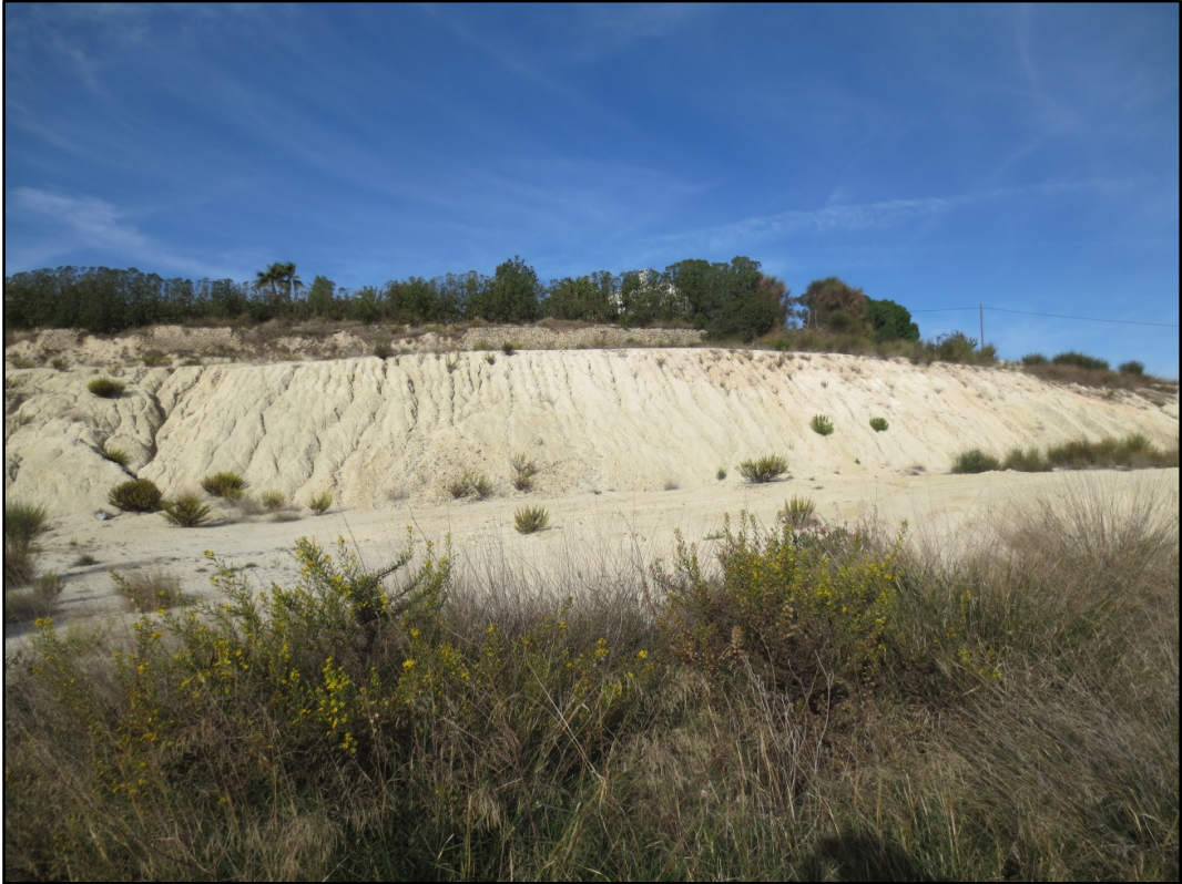
Figura 5.2.43. Talud existente del que se extrajo muestra. DIT14-1001.
