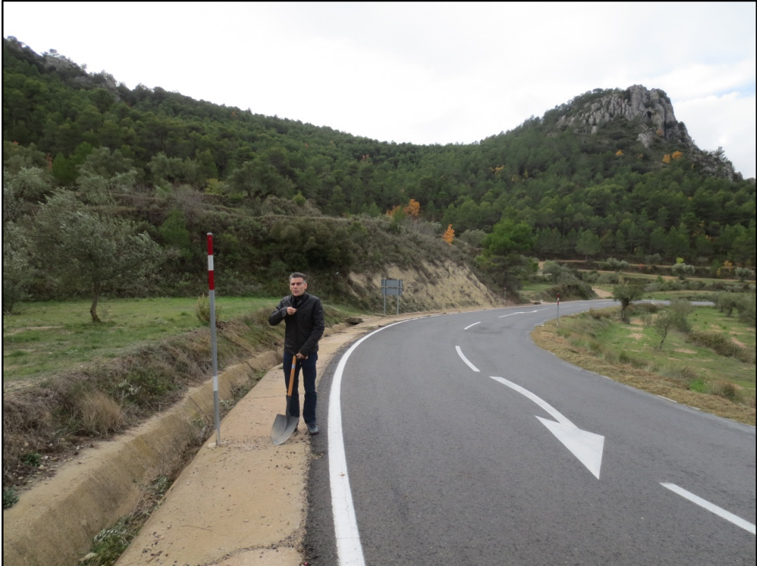
Figura 5.2.31. Carretera secundaria próxima al talud seleccionado. DIT14-201.
