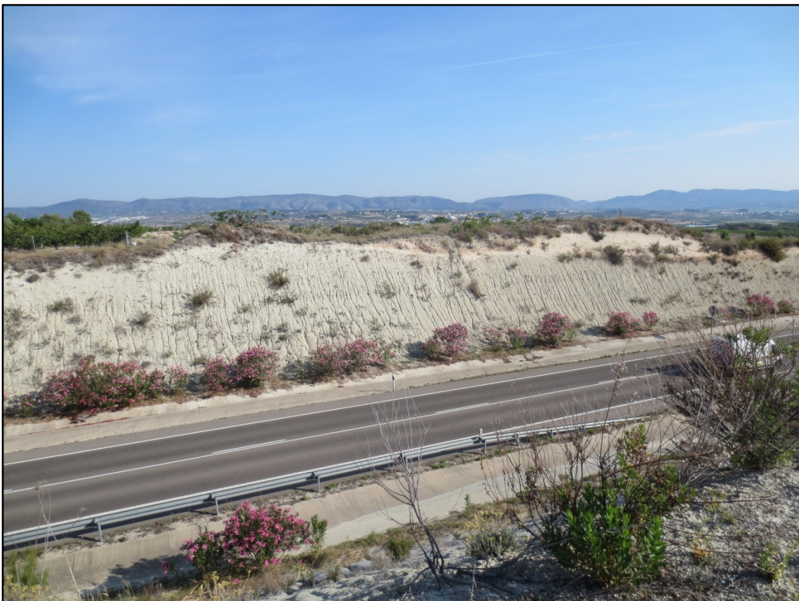
Figura 4.3.9. Aspecto del talud seleccionado.
