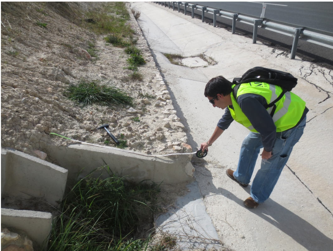
Figura 5.2.20. Medición del pie del talud. DIT14-201.
