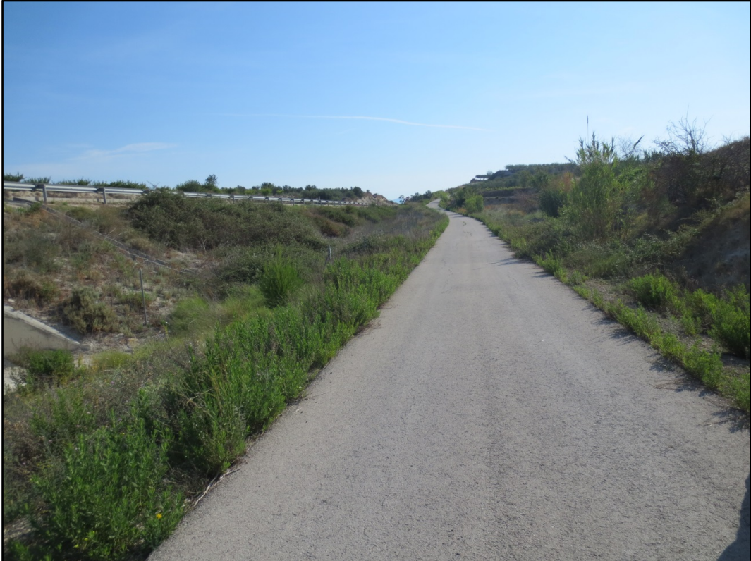
Figura 5.2.1.36. Carretera secundaria próxima al talud seleccionado.
