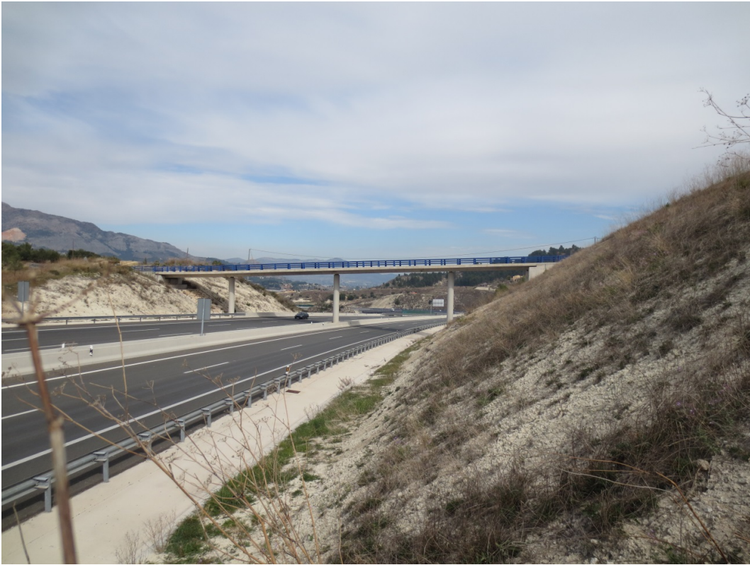
Figura 5.2.21. Paso superior adyacente al talud. DIT14-201.
