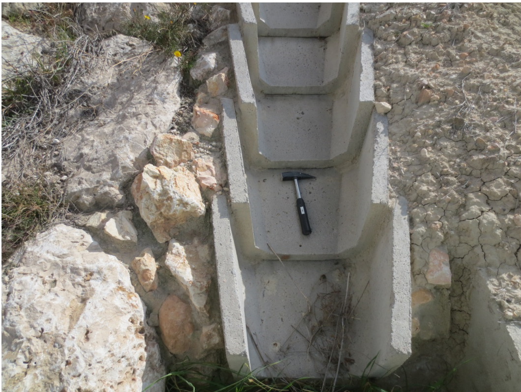
Figura 5.2.27. Parte inferior de la canaleta de desagüe. DIT14-201.
