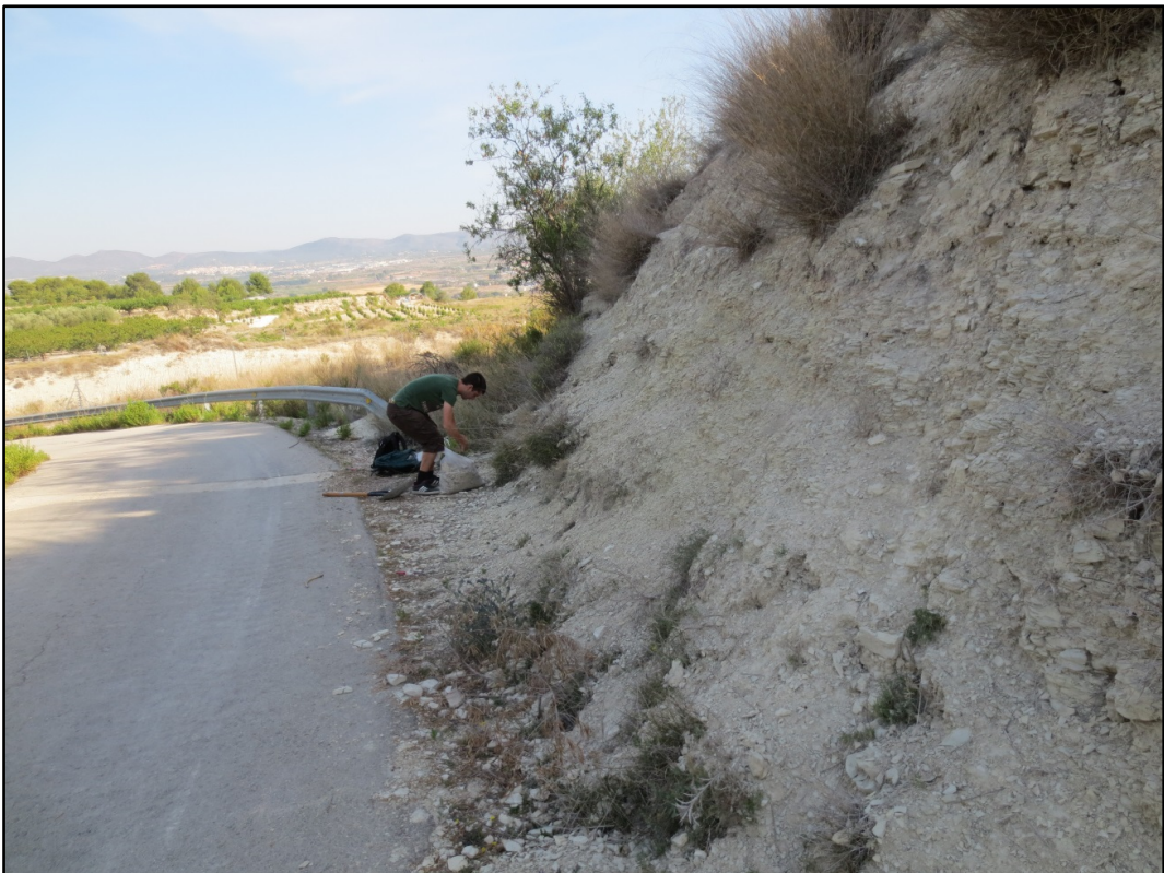
Figura 5.2.37. Talud existente bastante meteorizado del que se extrajo material. DIT14-601.
