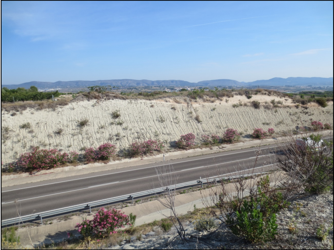
Figura 5.2.14. Talud seleccionado de la Variante de Montaberner.
