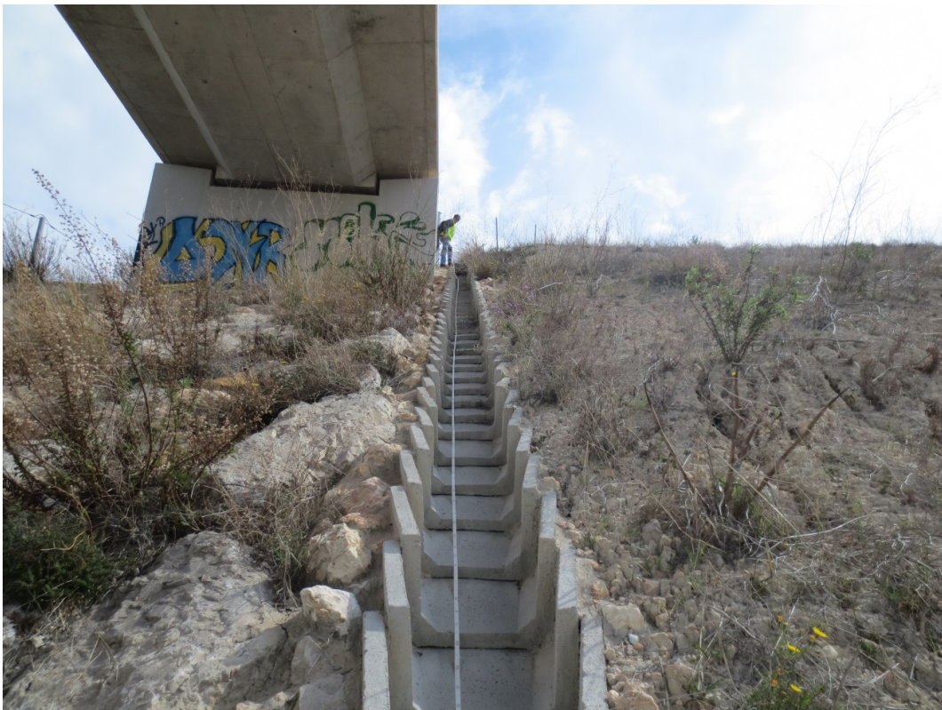
Figura 5.2.29. Medición de la longitud de la canaleta de desagüe. DIT14-201.
