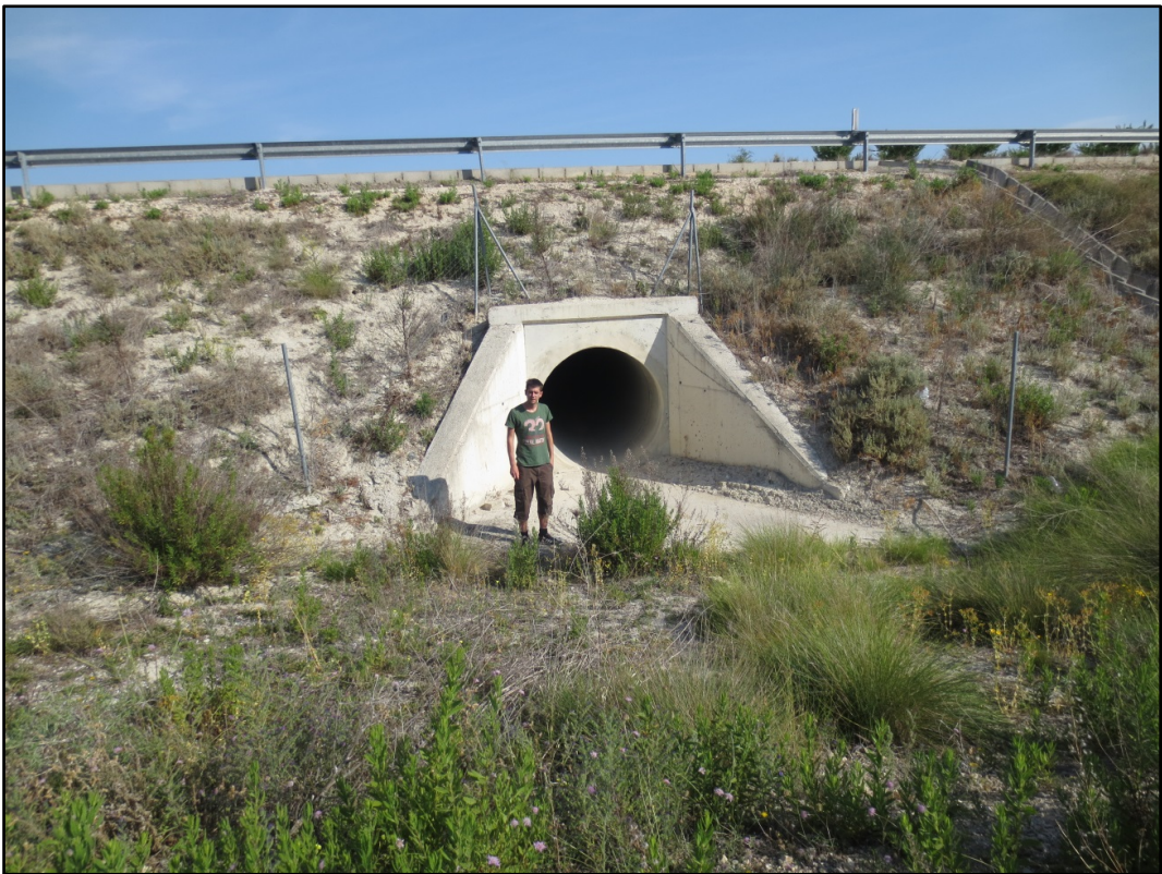
Figura 5.2.39. Obras de drenaje y desagüe en el talud. DIT14-601.
