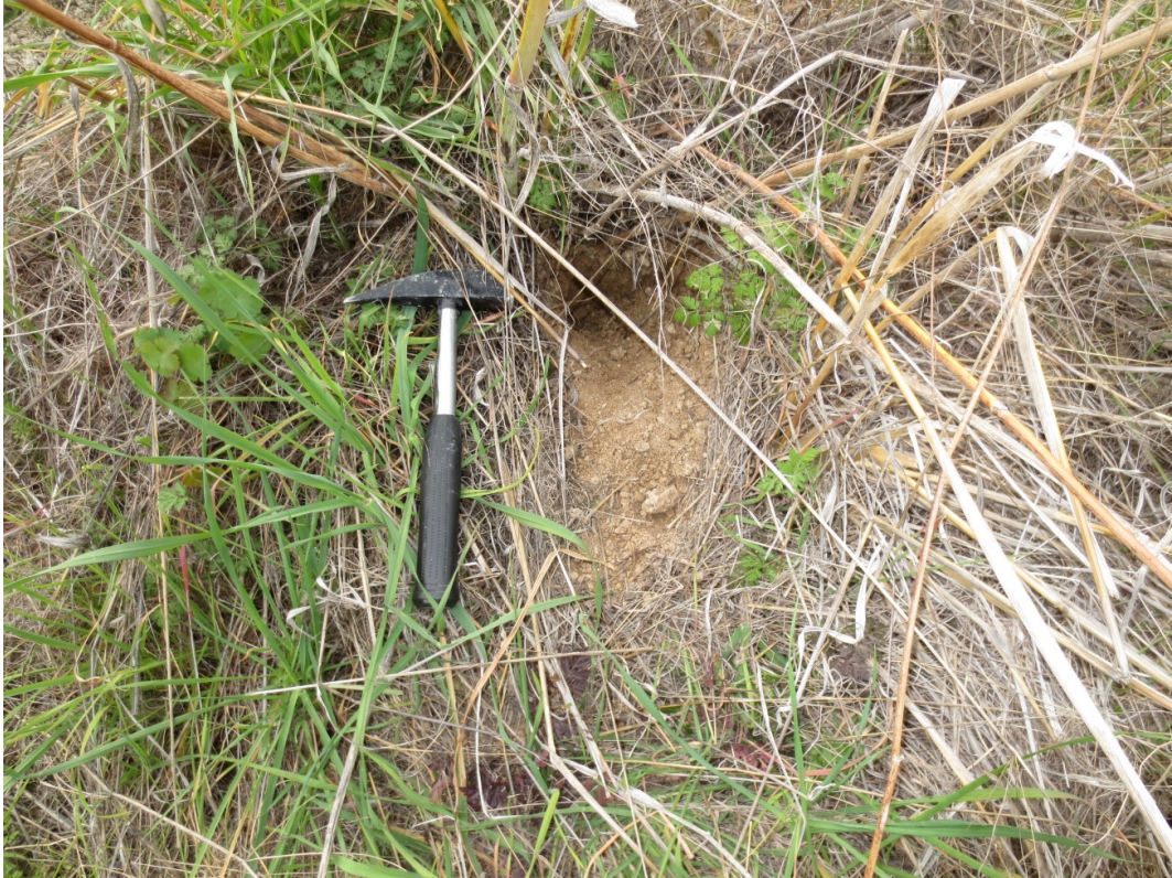
Figura 5.2.22. Cubierta vegetal sobre el talud. DIT14-201.
