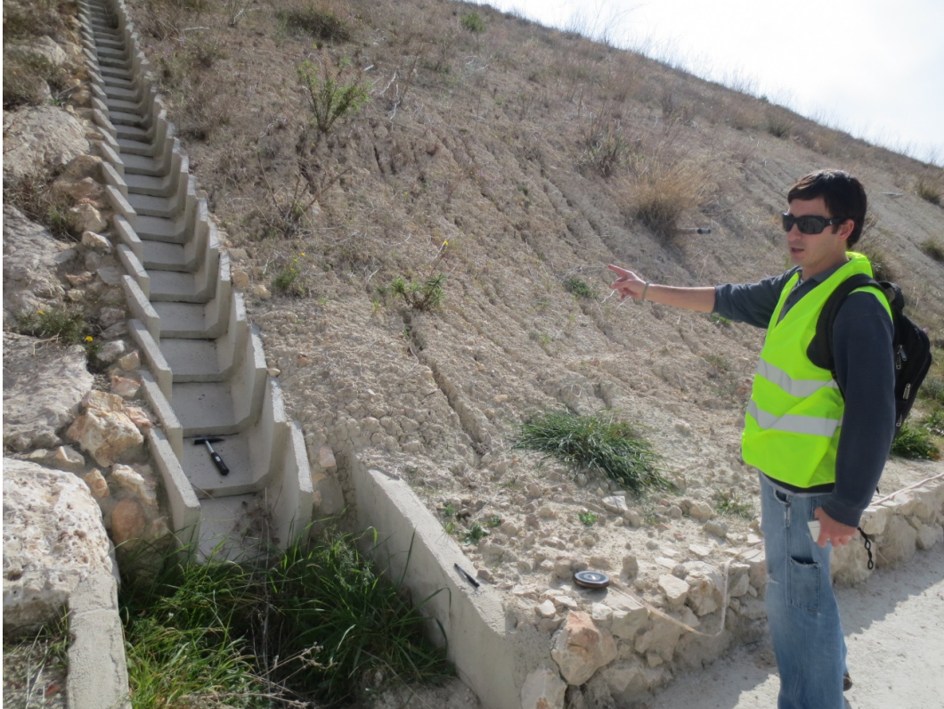
Figura 5.2.28. Canaleta de desagüe. DIT14-201.
