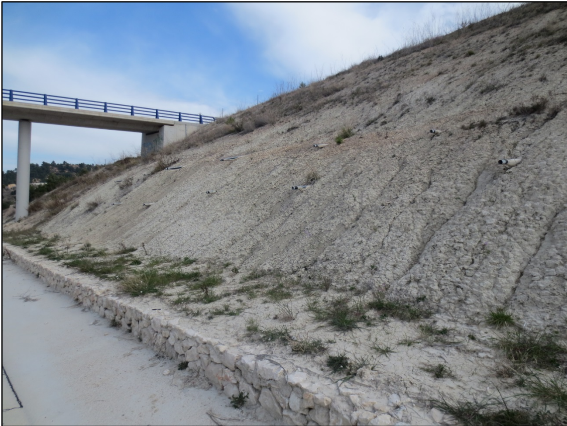
Figura 4.3.7. Talud seleccionado de la variante de Alcoy.
