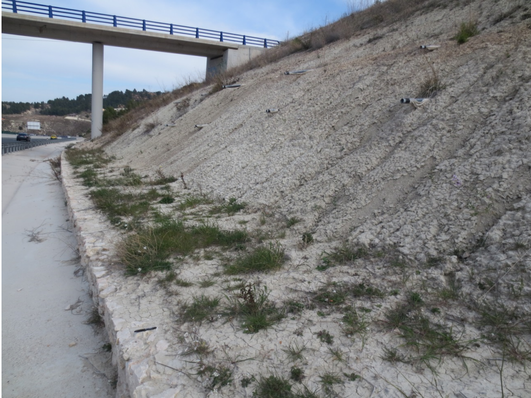
Figura 5.2.24. Obras accesorias de drenaje sobre el talud. DIT14-201.
