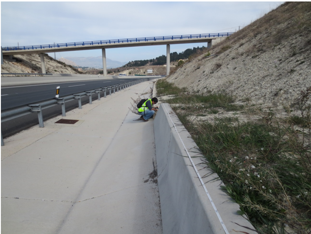
Figura 5.2.18. Medición de la longitud inferior del talud DIT14-201.
