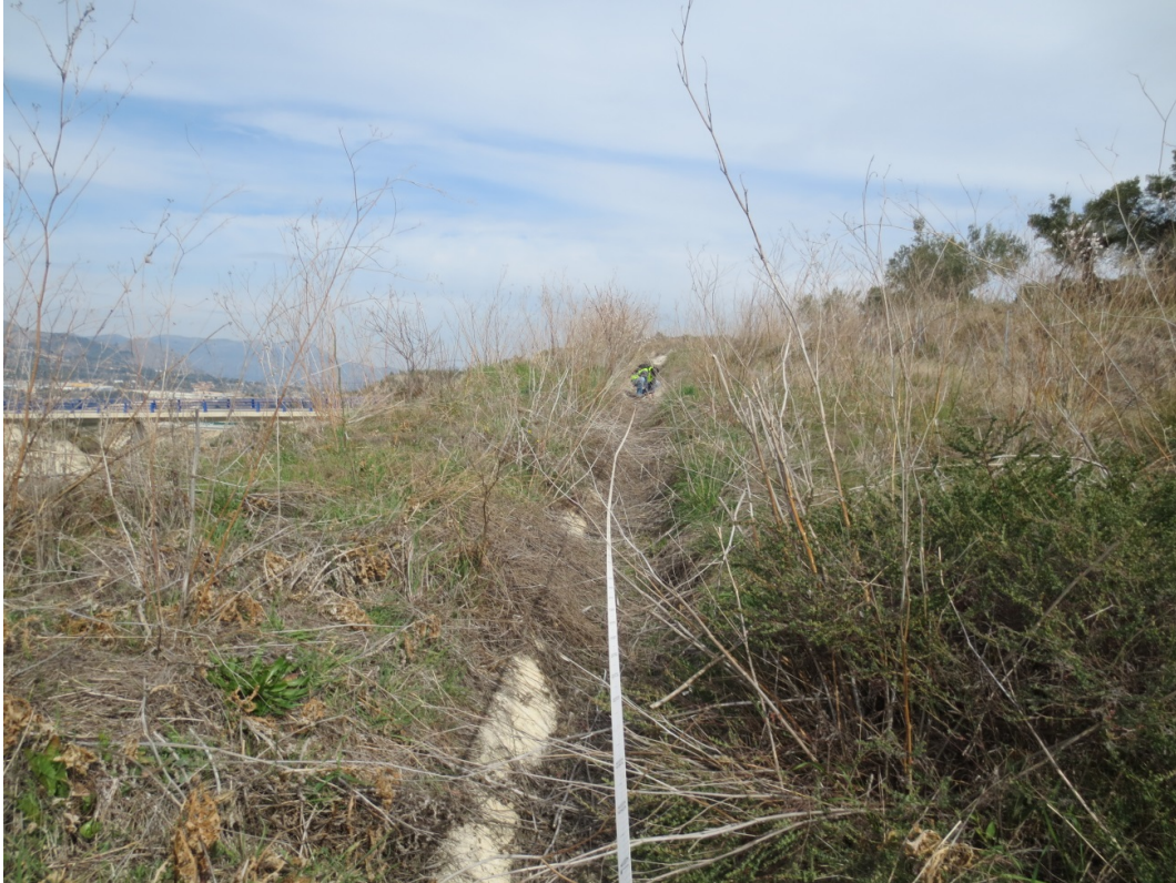
Figura5.2.19. Medición de la longitud superior del talud. DIT14-201.
