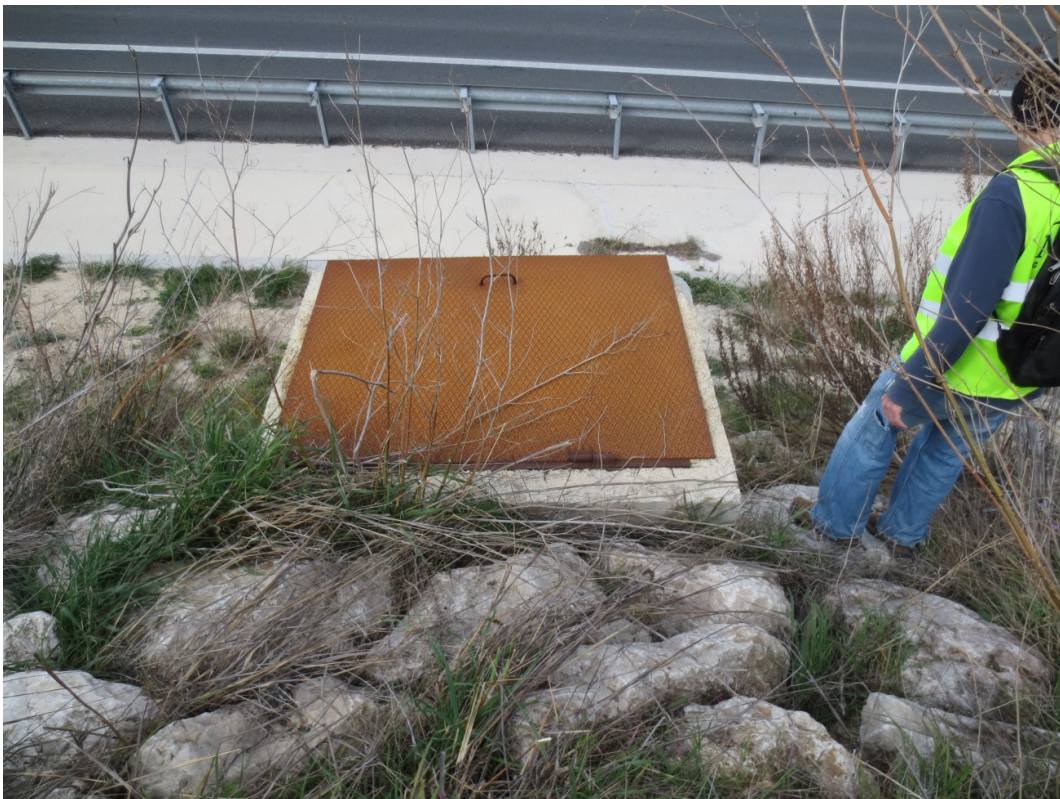
Figura 5.2.25. Arqueta al pie del talud. DIT14-201.
