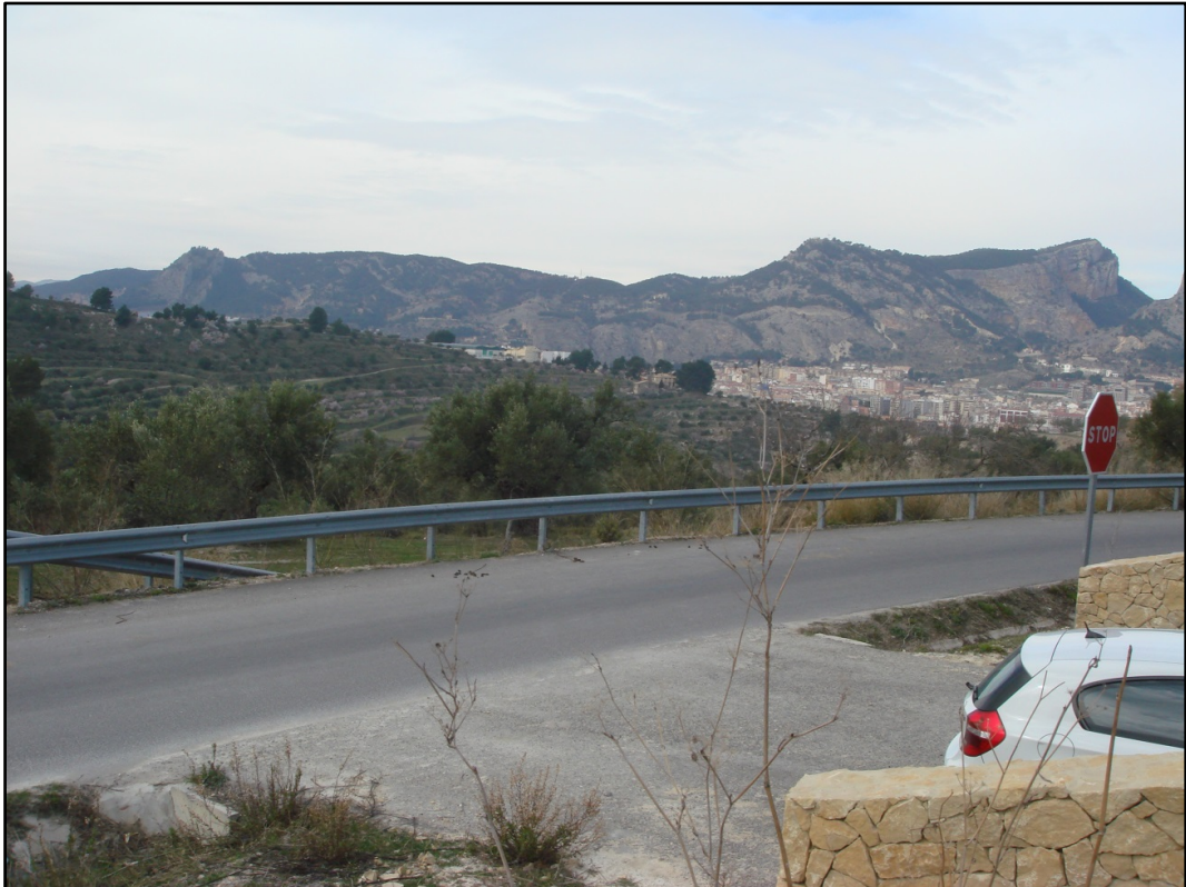
Figura 5.2.9. Punto de estacionamiento del vehículo cercano al talud seleccionado.
