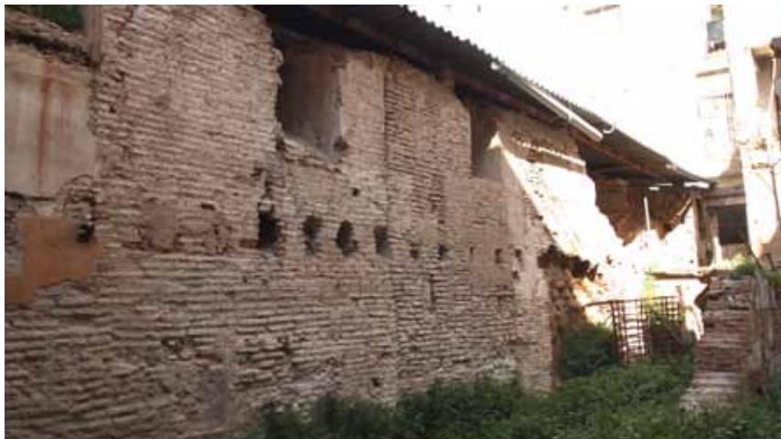
Fig. 3. Muro trasero de los arcosolios del cementerio medieval de San Juan del Hospital que conformaba la calle de Cristòfol Soler, actualmente incorporada a la parcela del palacio de Valeriola.
