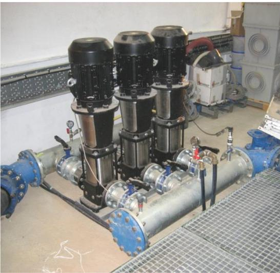
Ilustración 3.2.3 Grupo de bombeo junto al Depósito Aiguassera
