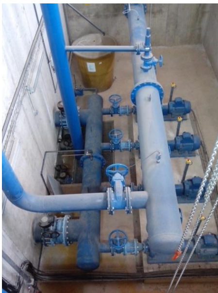
Figura 3-27. Equipo de bombeo instalado
