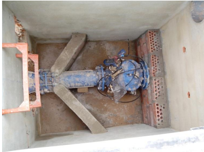
Figura 3-25. Válvula Reductora de Presión a la entrada de Parc Sagunt tarada a 35mca durante el día
