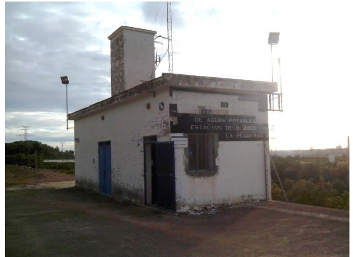
Figura 3-29. Caseta de bombeo del Pozo de la Pedrera
