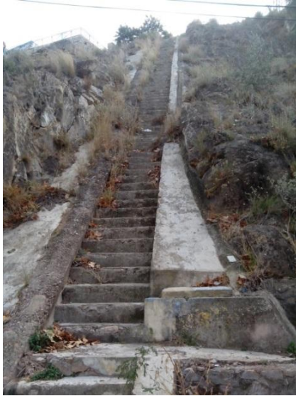
Figura 3-11. La tubería Ø300 de entrada y salida va por debajo de estas escaleras
