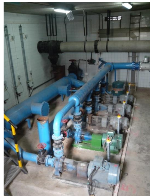
Figura 3-21. Equipo de bombeo instalado
