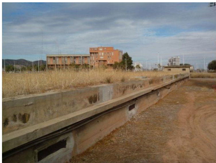
Figura 3-19. Aspecto exterior del Depósito Sepes
