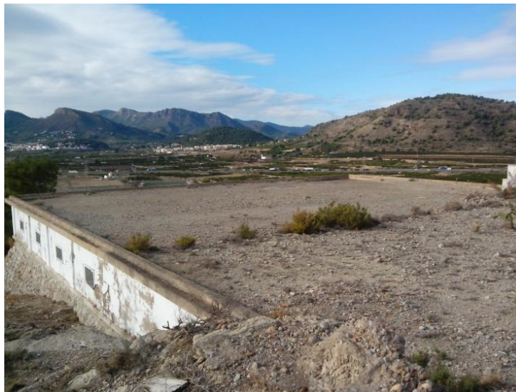
Figura 3-9. Depósito Cota 110 en funcionamiento
