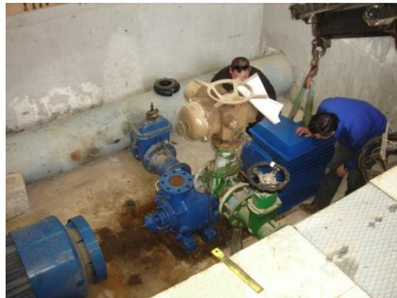
Figura 17. Foto instalación de grupo de bombeo en la estación de bombeo de Crevillente
