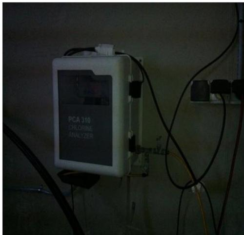
Dicho depósito para garantizar una mayor calidad en el agua suministrada, dispone de un sistema de cloración continuado, realizando constantemente pruebas de pH y añadiendo o no cloro para su corrección. El dosificador de hipoclorito sódico suministra un caudal de 5l/h y es de la marca Astral.
