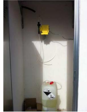
Figura 17 Sistema de cloración en el depósito de la Canalosa
