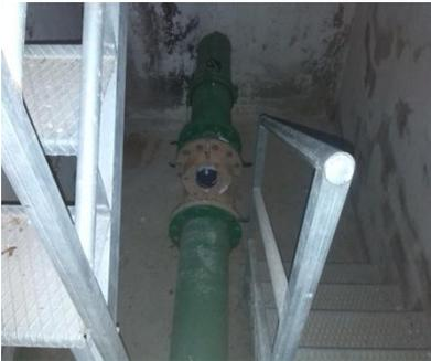
Figura 20. Arqueta de rotura de carga
