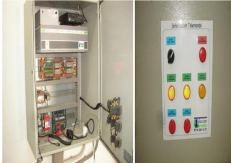
Figura 23. Foto del sistema de telemando instalado en el depósito de Almoladera.
