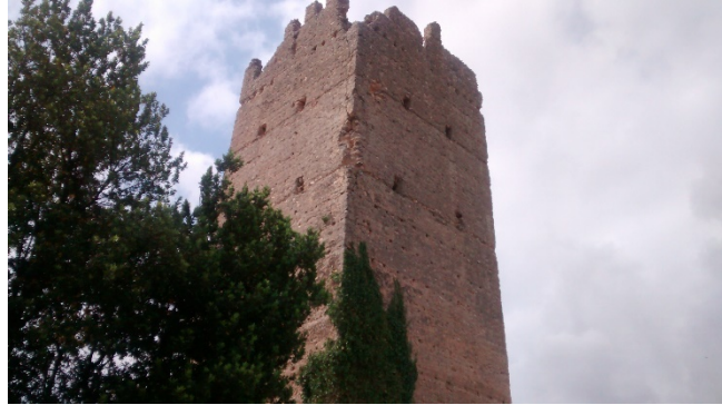
Figura 27. Imagen de la Torre Mussa.
