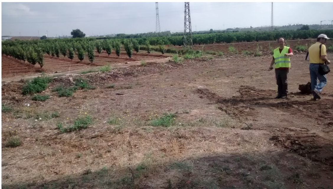
Figura 35. Colocación de las cintas métricas.
