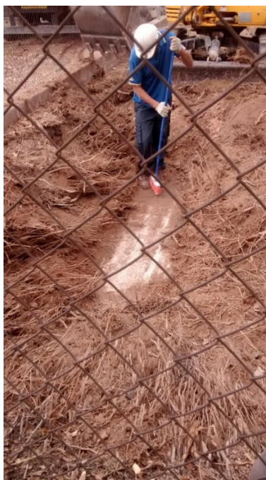
Figura 72. Proceso de limpieza de la zona.
