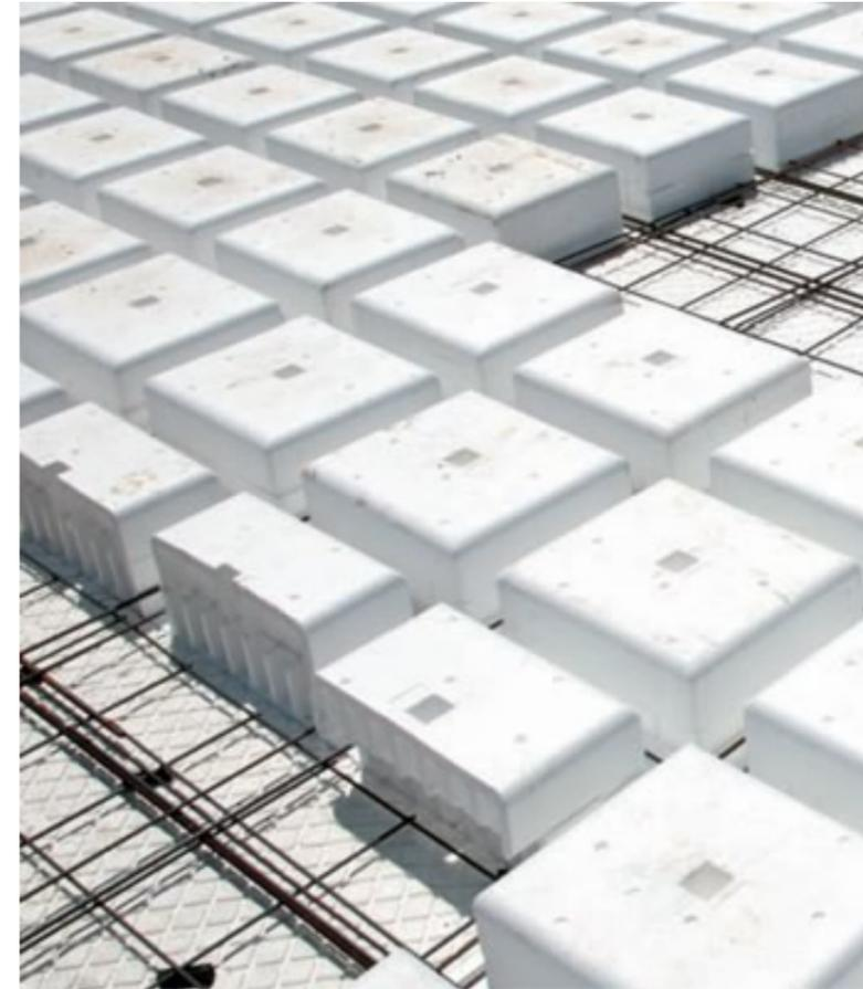
Bloques de porexpan en forjado reticular.
