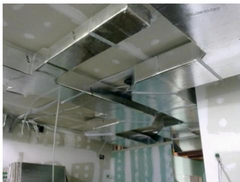
Conductos previo el montaje del falso techo.
