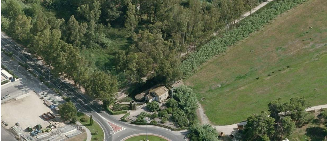
1- Estación de bombeo que drena la Marjal de la Safor
