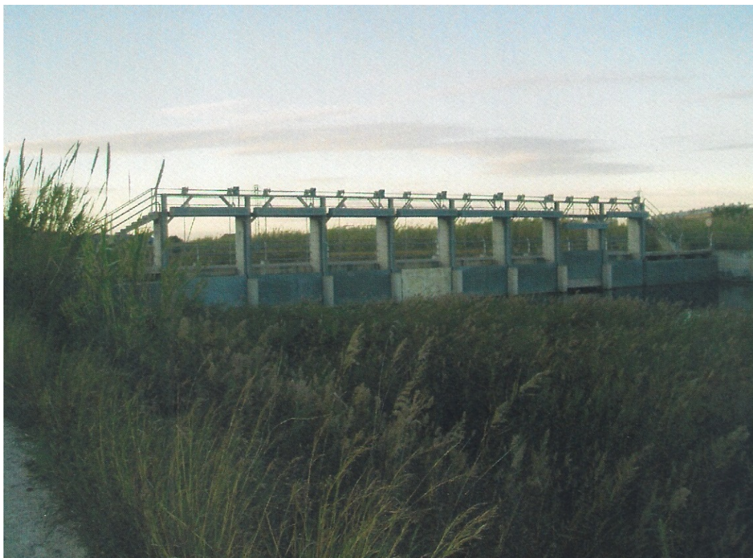
11- Cmpuertas en el Río Jaraco
