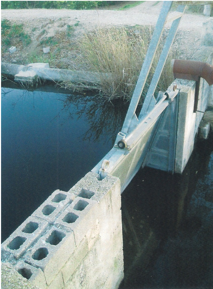
7- Detalle de la compuerta
