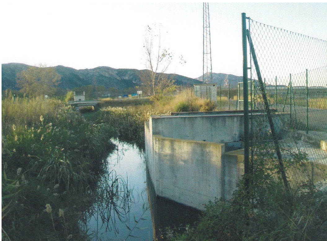
9- Canal perimetral junto al desagüe al Río Jaraco
