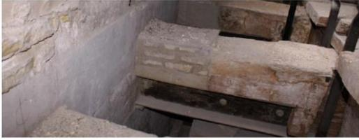
*Ilustración 65: Refuerzo metálico en vigas UPN-180.
