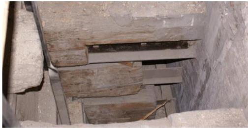
*Ilustración 66: Refuerzos metálicos en ménsulas T-100.
