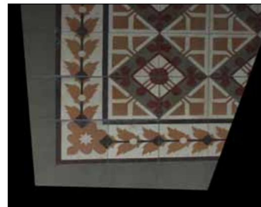
Figura 005.Paviment: Fotografia rectificada amb PTLens
