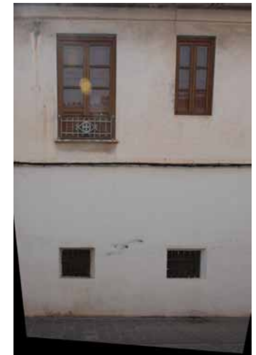
Figura 007.Façana: fotografia rectificada amb PTLens i Asrix
