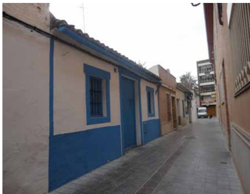
Figura 003. Cases annexes a l'edifici, carrer Macastre. Pròpia autora.
