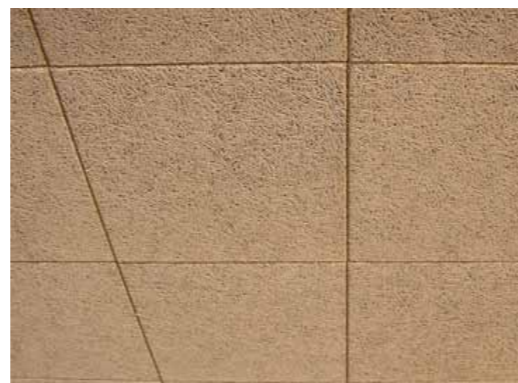
Figura 096. Sostre de llanes de fusta.
