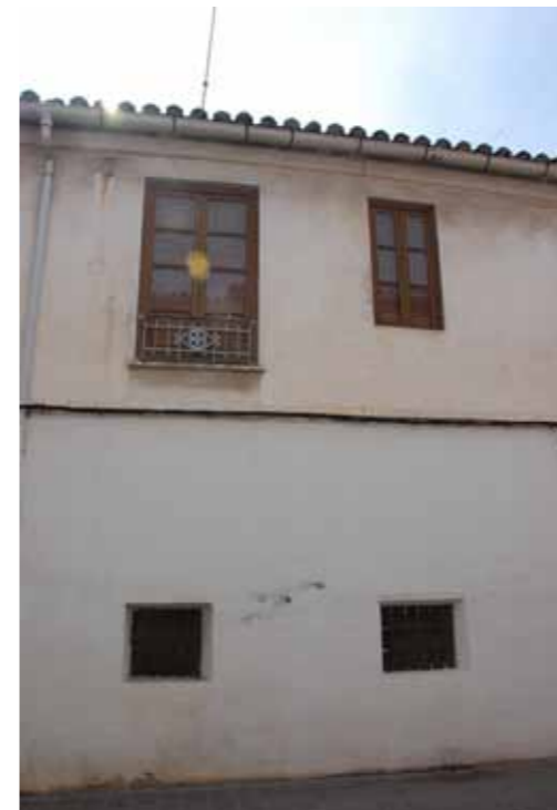
Figura 006.Façana: fotografia inicial. Pròpia autora.
