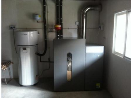
Figura 55. Fotografía de una caldera de biomasa instalada en una vivienda.
