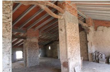
*Figura 19. Fotografías de la cubierta reformada de la planta segunda*
