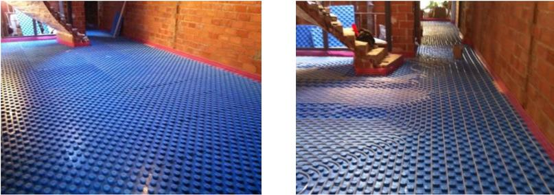
*Figura 47. Fotografía de la instalación de suelo radiante en una vivienda unifamiliar.*
