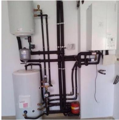
Figura 53. Fotografía de una bomba de calor instalada en una vivienda. (Se utiliza sólo una máquina de climatización por tener menos superficie útil que en la vivienda de estudio)
