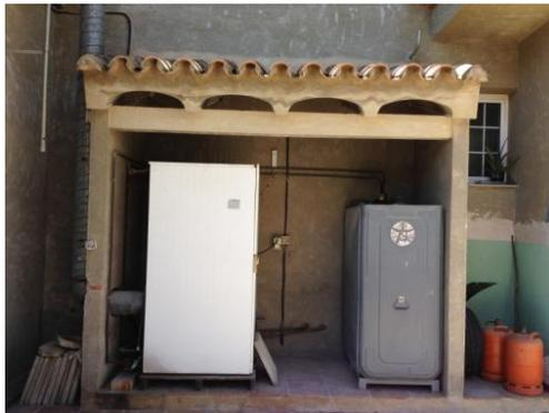
Figura 51. Fotografía de una instalación de caldera de gasóleo C con depósito para el carburante.
