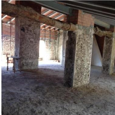
Figura 16. Fotografía de los muros de carga de la planta segunda, en esta planta no están revestidos y se distinguen los materiales.
