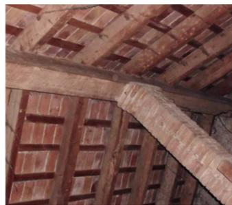
Figura 20. Cubierta alquería Visquet. Fuente: autor propio
