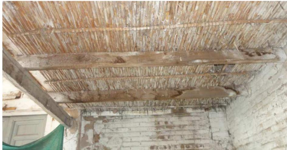
Figura 50. Forjado con cañizo Alquería Visquet. Fuente: autor propio
