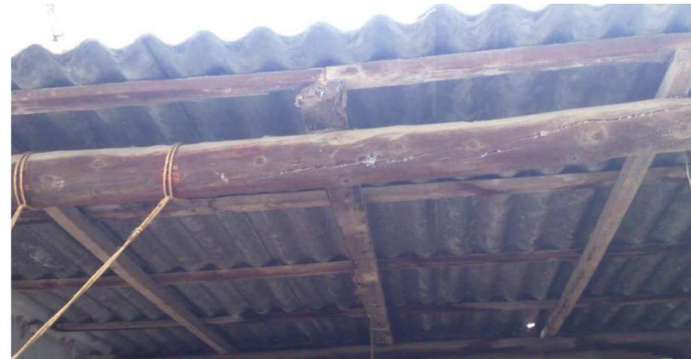
Figura 56. Cubierta acabado con placas de fibrocemento alquería Visquet. Fuente: autor propio
