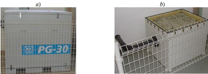
Figura 4.8. Detalles del montaje: a) Grupo soplante; b) Silenciador.
