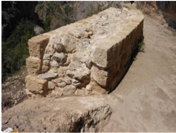
Fig. 16. Rehabilitación del muro del specus.
