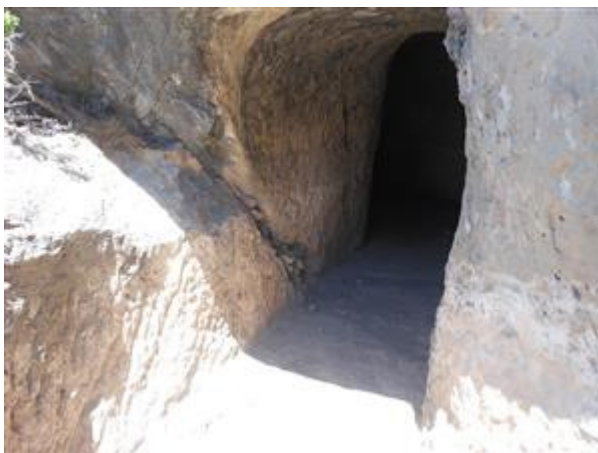
Figura 50. Diaclasa en la roca. Fuente: elaboración propia, 2015
