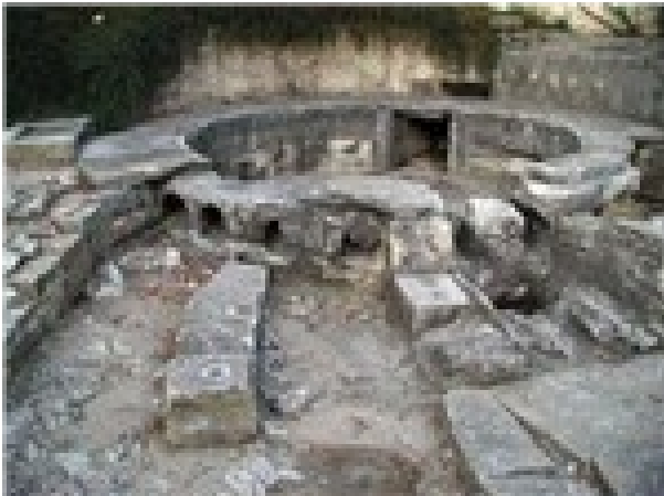
Figura 23. Cámara de distribución del castellum aquae, con orificios calibrados para distribuir el agua a los barrios. Fuente: Moreno, 2007
