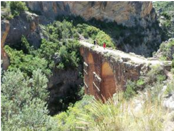
Figura 42. Vista del puente acueducto en la Cueva del Gato.
