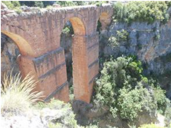
Figura 43. Vista de los dos pilares del puente acueducto. Fuente: elaboración propia, 2015
