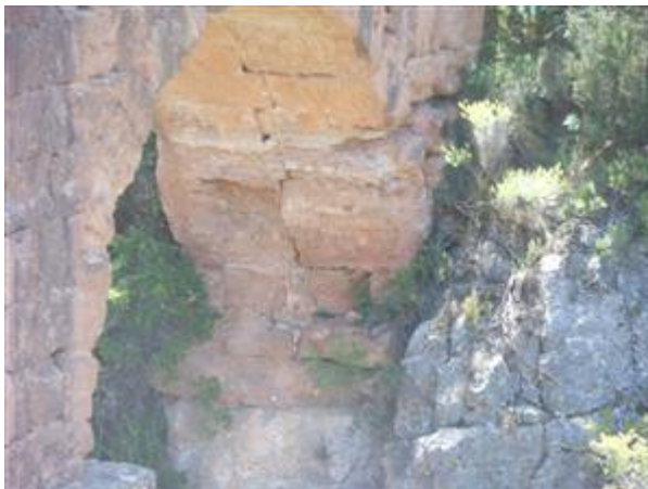
Figura 45. Vista del apoyo del arco sobre roca.
