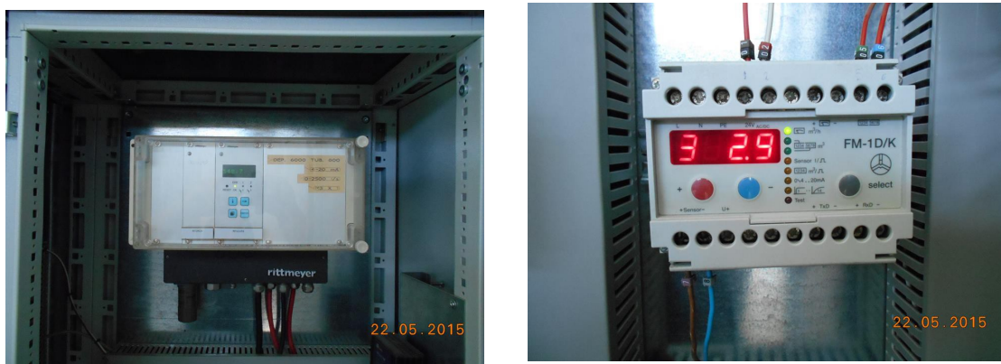
Fig. 11. Dos tipos de electrónicas; izquierda, caudalímetro por ultrasonidos. Derecha, caudal por pulsos.
