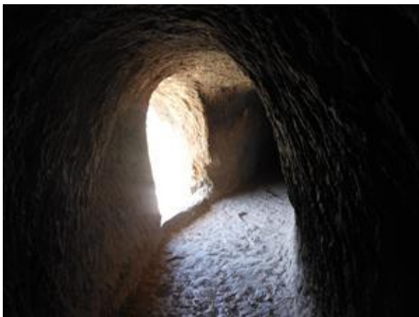
Figura 48. Ventana de aireación de un túnel. Fuente: elaboración propia, 2015
