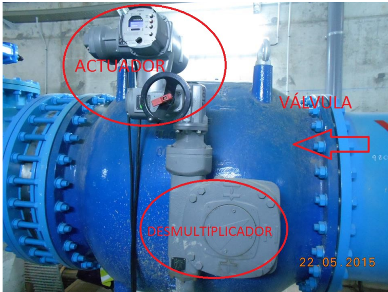
Figura 38. Partes de una válvula de regulación anular automatizada. Fuente: elaboración propia, 2015
