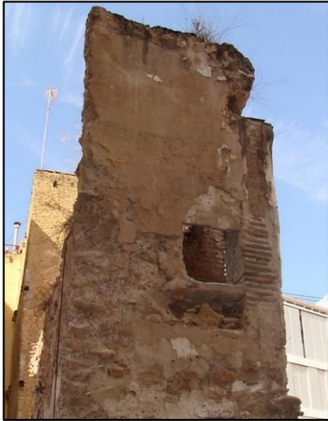
**Figura 58:** Vista lateral del lienzo. Se observa como el vano de la escalera se horadó hasta aproximadamente la mitad del grosor del muro. (Foto: Autor. 2014).
