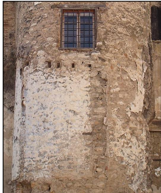
**Figura 43:** Detalle de la descohesión superficial de la torre. (Foto: Autor. 2013).
