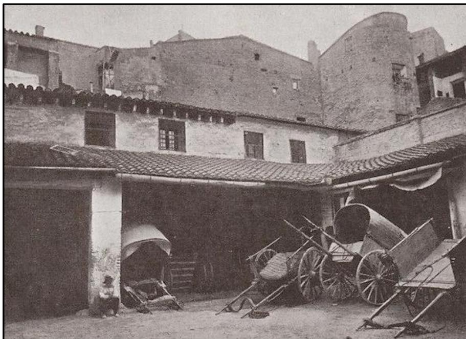
**Figura 26:** Patio de la posada. La techumbre, a un agua, de las caballerizas se sostiene directamente en la torre y en el coronamiento de la muralla (Foto: Vicente Ventura y Vidal. 1930).
