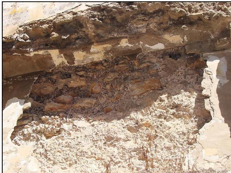
**Figura 60:** Detalle del socavamiento de la cara intramuros. Se observa las piedras de mediano y gran tamaño del hormigón. (Foto: Autor.2014).
