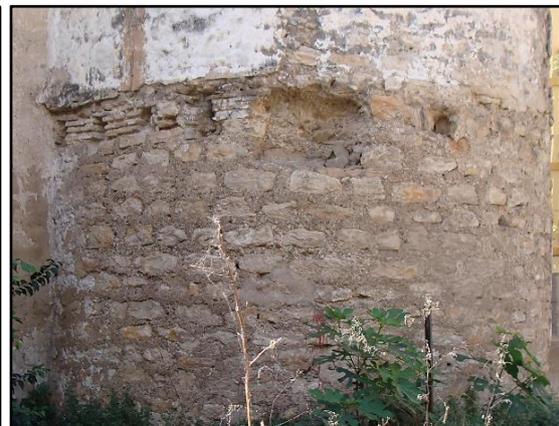
**Figura 57:** Vista de las huellas de la edificación que se adosó a la torre. (Foto: Autor. 2014).
