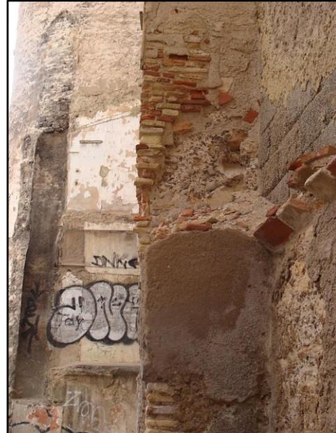
**Figura 55:** Vista de los centímetros excavados en el lienzo y restos del tapial de hormigón del tramo derecho de la muralla. (Foto: Autor. 2014).
