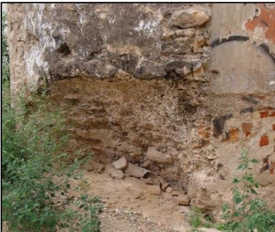
**Figura 63:** Detalle de la pérdida de material en la torre. (Foto: Autor. 2014).
