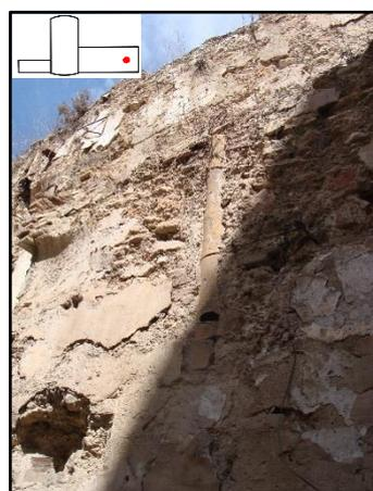
**Figura 31:** Bajante cerámica empotrada en la cara intramuros (Foto: Autor. 2014).
