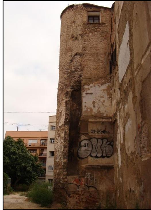
**Figura 62:** Vista general del perfil derecho de la torre. Se observan la impronta de la chimenea, los depósitos de hollín y la rotura de la cubierta. (Foto: Autor. 2013).
