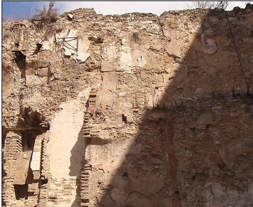
**Figura 65:** Cara intramuros. Vista de diferentes alteraciones antrópicas como los elementos metálicos, los restos de revestimientos de azulejería y las bajantes cerámicas originales. (Foto: Autor. 2014).
