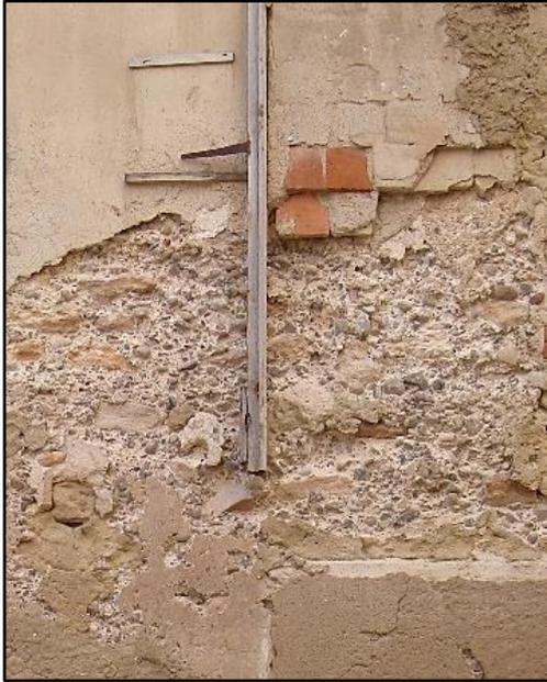
**Figura 54:** Detalle del núcleo de hormigón de la muralla en el tramo derecho. (Foto: Autor. 2014)
