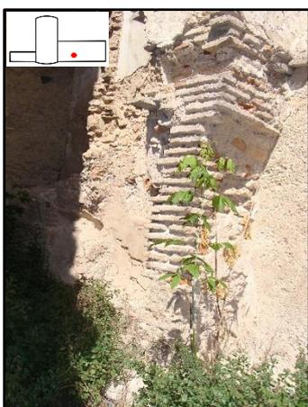
**Figura 29:** Pilar de ladrillo en la cara intramuros. (Foto: Autor. 2014).
