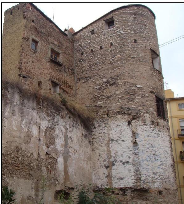
**Figura 33:** Vista general de la torre donde se observan el cuerpo original y el recrecido, así como los diferentes niveles de forjado. (Foto: Autor. 2014).
