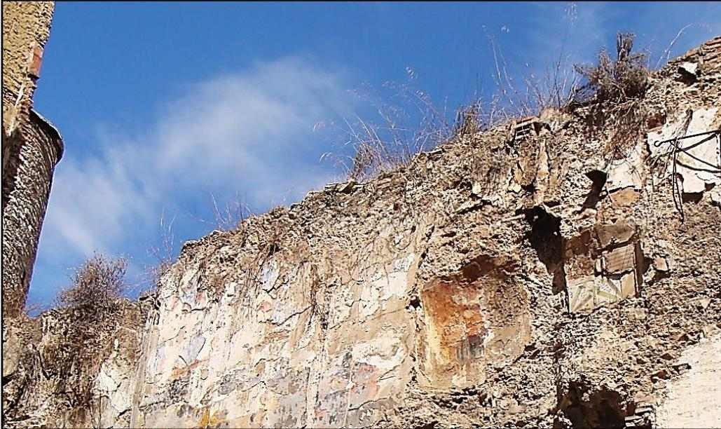
**Figura 52:** Cara intramuros. Vista general de la vegetación en el coronamiento y en el paramento del lienzo. (Foto: Autor. 2014).
