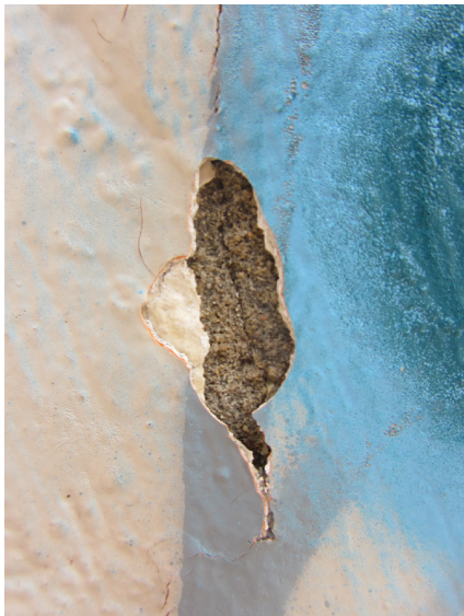
Figura 33. Detalle faltante de película pictórica, preparación y muro.
