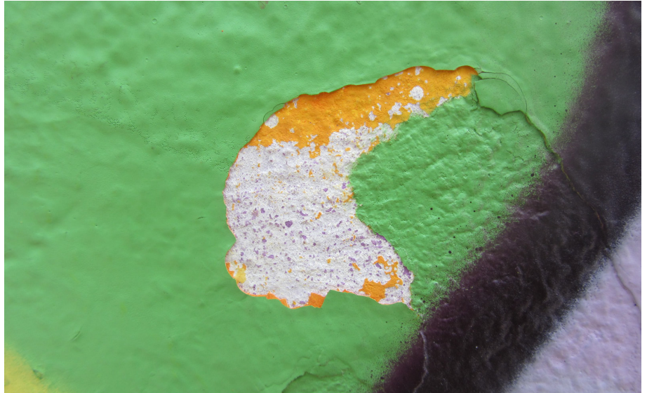
Figura 32. Detalle faltante de película pictórica y preparación.
