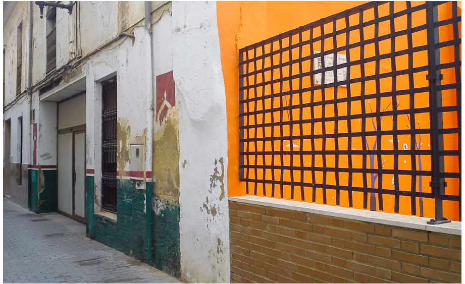
Figura 22. Edificio de la Calle Rei en Jaume que sustenta la obra.
