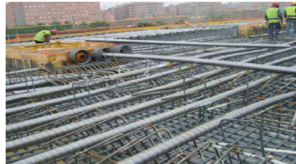
Manteniendo la validez de los conceptos en losas de hormigón armado, la idea del pretensado o postesado es la de introducir un estado de tensión, previo a la carga de la estructura, de manera tal que anule, o disminuya, las tensiones de tracción en el hormigón.
