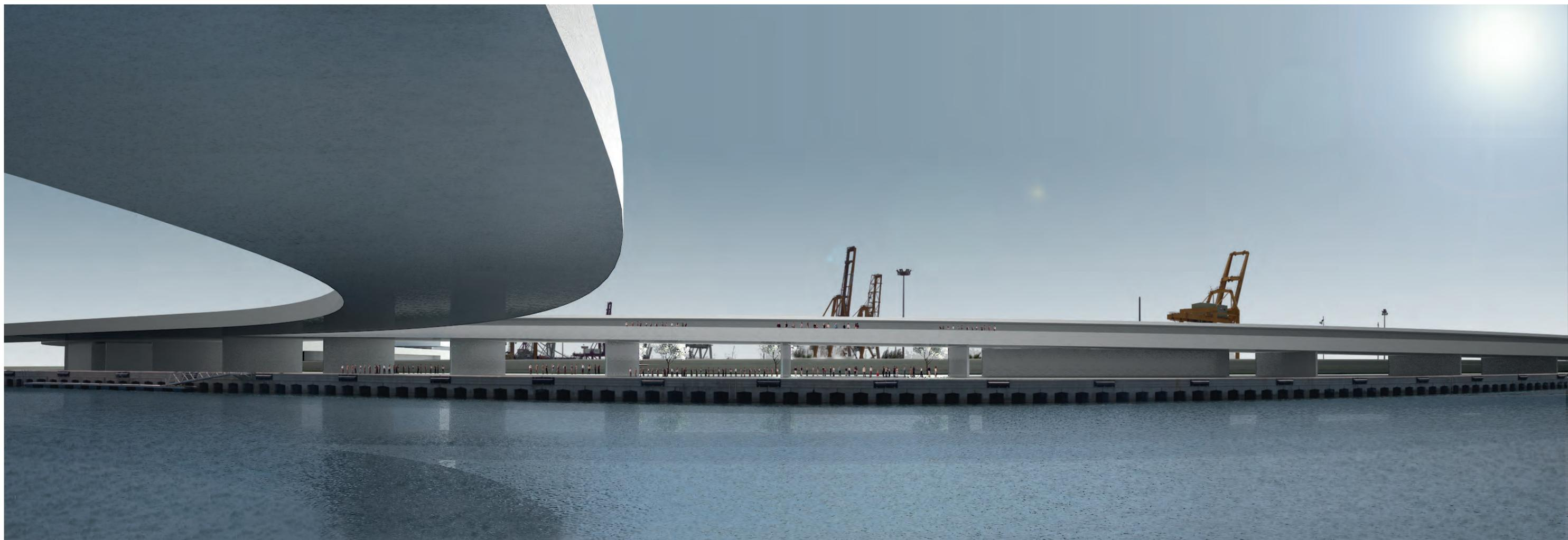
A partir de este punto el recorrido comienza a elevarse hasta alcanzar una cota de 11 metros a lo largo de 750 metros de longitud gracias a una estructura de muros de hormigón de espesor variable y separados cada 30 metros. A lo largo de este ascenso aparecerán diferentes espacios arquitectónicos que cobraran vida gracias a las diferentes funciones y actividades ubicadas en ellos.
