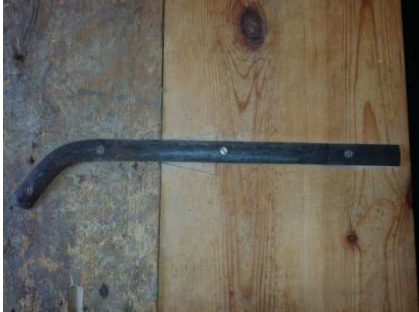
Imagen 29: Herrajes de refuerzo en cubierta
