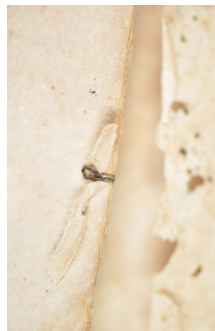
Figura 23. Documento 1. Estado de conservación del sistema de montaje. Foto: Evelien Van den Heuvel.
