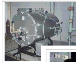
Ilustración 20.- Caldera pirotubular
