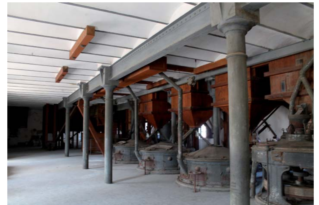
sala de máquinas. descascarillado
