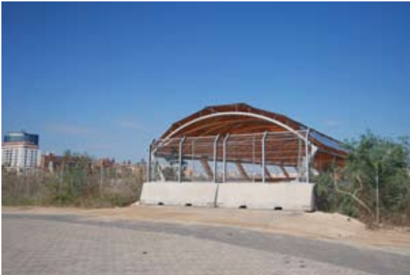
Inconexión urbana. Puente peatonal vetado al peatón, sólo abierto durante los once días de duración del efimero evento de la Fórmula Uno
