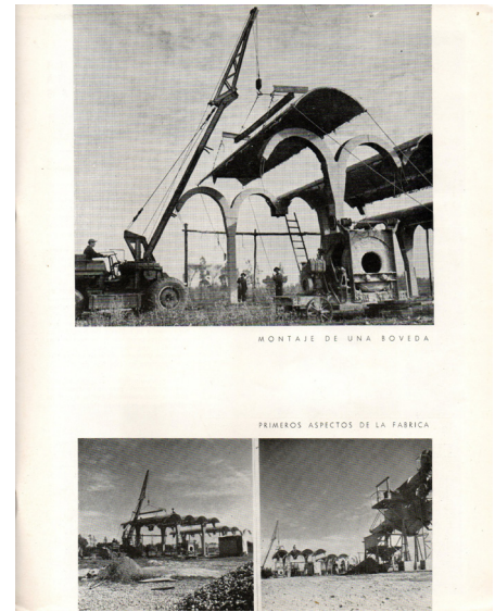
Fig.30- PROA 88-abril 1955-fábrica de bloques-A. Ortega
