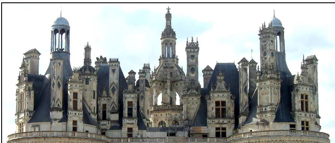
Figura 3.1.2.6. ¿Solo el remate de un edificio o la maqueta de una ciudad monumental? Chimeneas, buhardillas y torres del castillo de Chambord (fachada principal).
