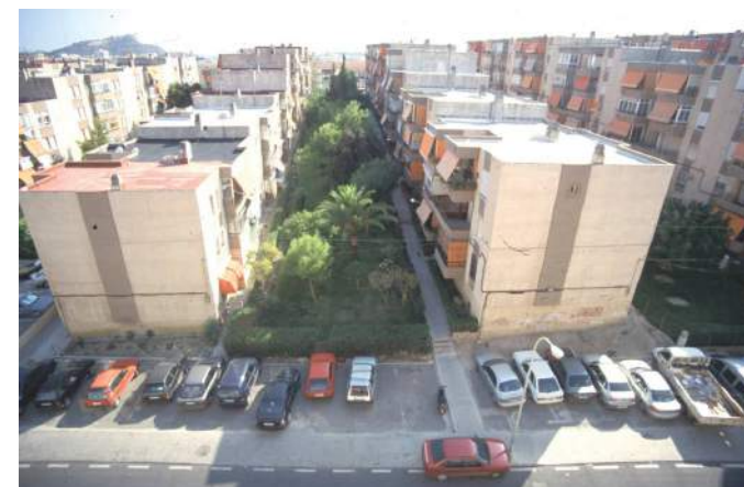
Fig. 23: Barrio Juan XXIII en Alicante_ Fuente: Martí, 2012.
