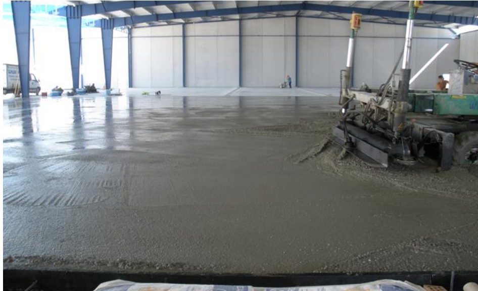
Figura 6.3.2b Vertido y extensión de la capa de hormigón
