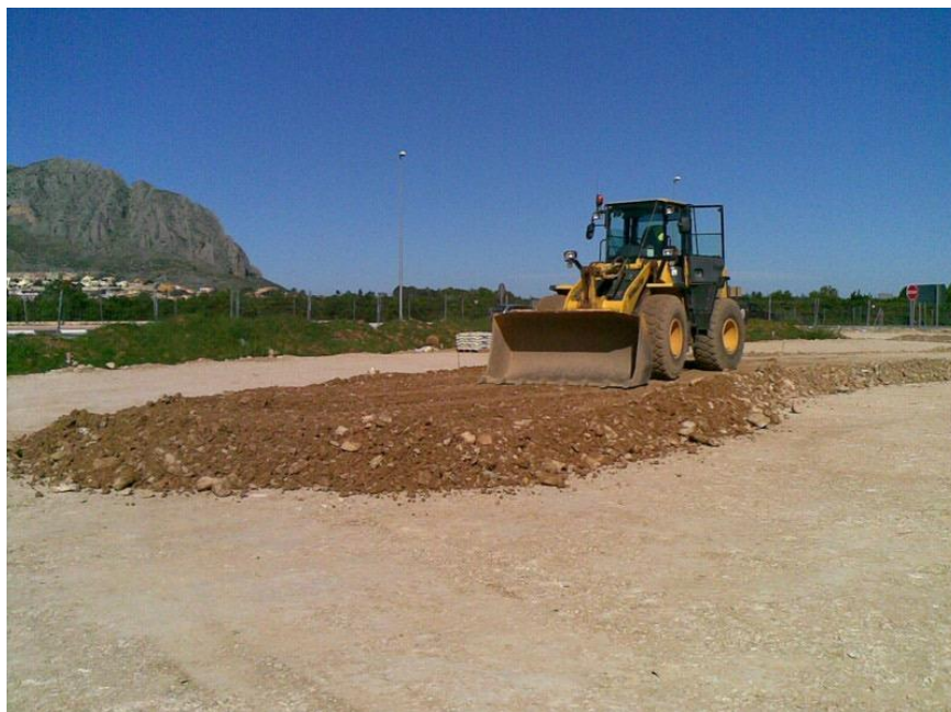
Figura 6.3.2a. Extensión y compactación de la capa de zahorra.
