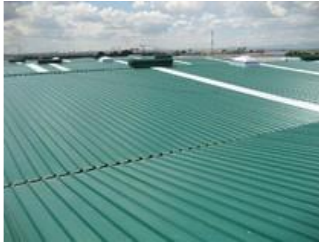
Figura 6.3.1.3b. Cubierta inclinada tipo sandwich
