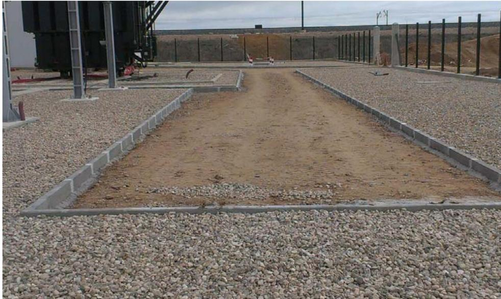
Imagen 77: bordillo instalado y explanada acabada en el parque exterior de la SE\_111.
