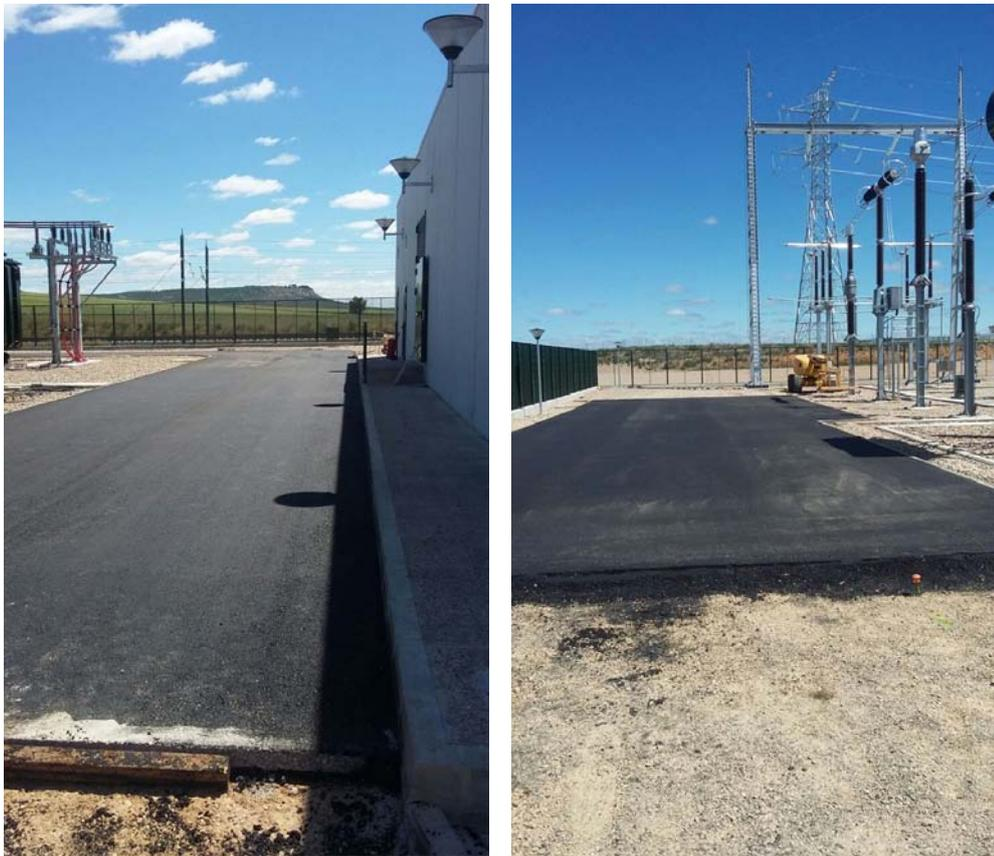
Imagen 88: detalle de la ejecución de la capa de aglomerado de los viales en la SE de Dueñas.
