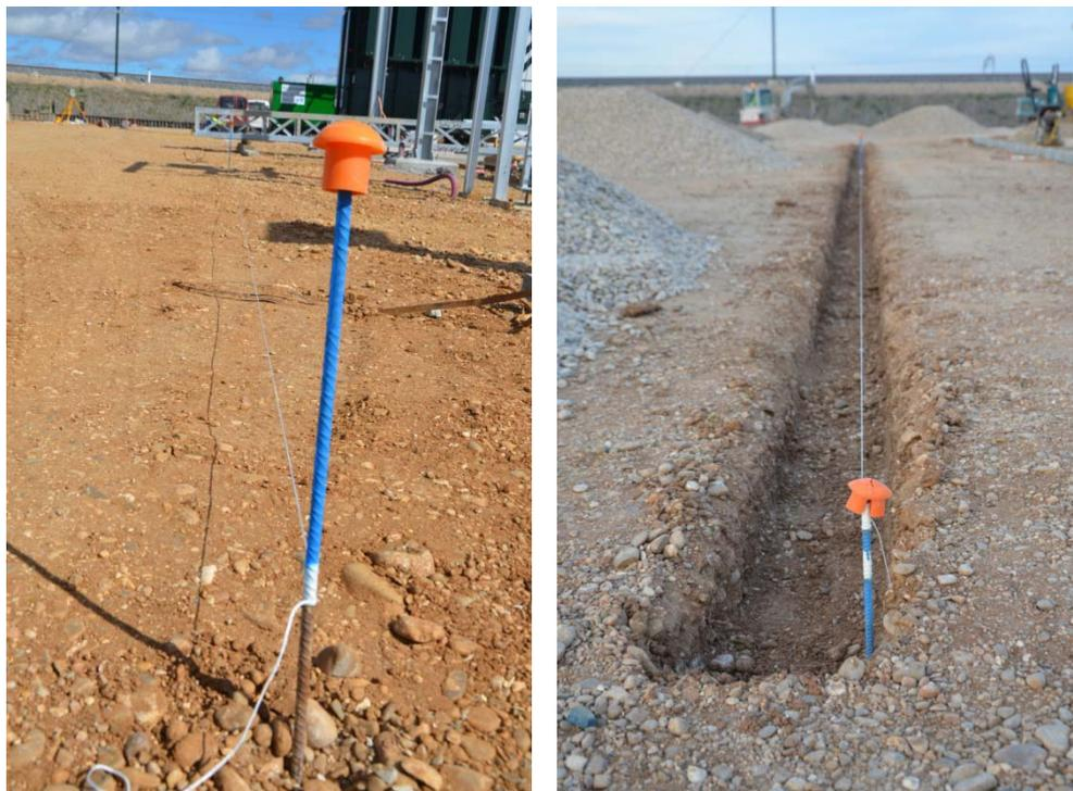
Imagen 74: replanteo inicial del bordillo y zanja ejecutada.
