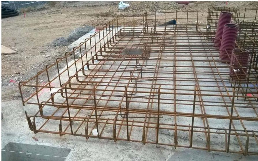
*Imagen 21: armadura del vaso de aceite en los autotransformadores de ATIs y ATFs.*
