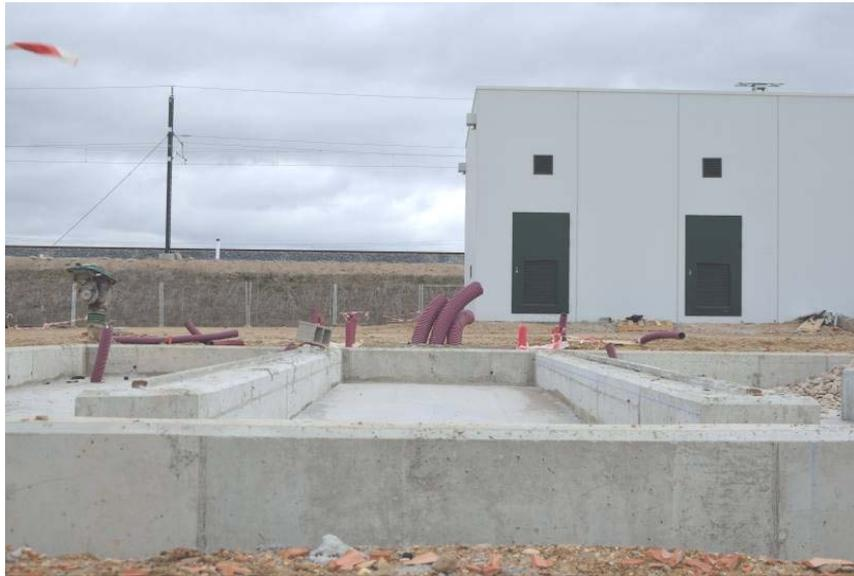
*Imagen 48: vaso de aceite terminado a falta del relleno con gravas.*
