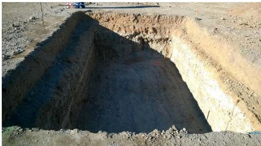
*Imagen 14: excavación para el foso de cables con berma en talud. ATI 104.2\_Valladolid.*
