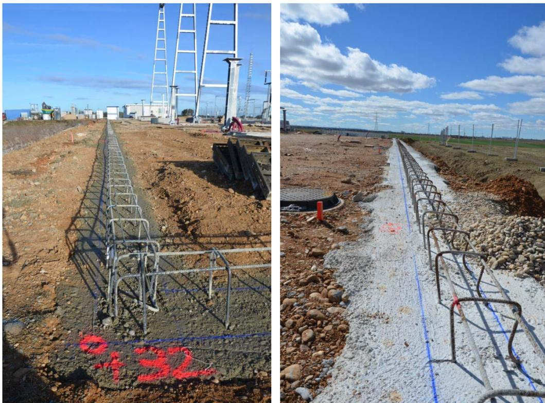
Imagen 67: detalles del replanteo de la cota de coronación sobre el acabado de la cimentación.
