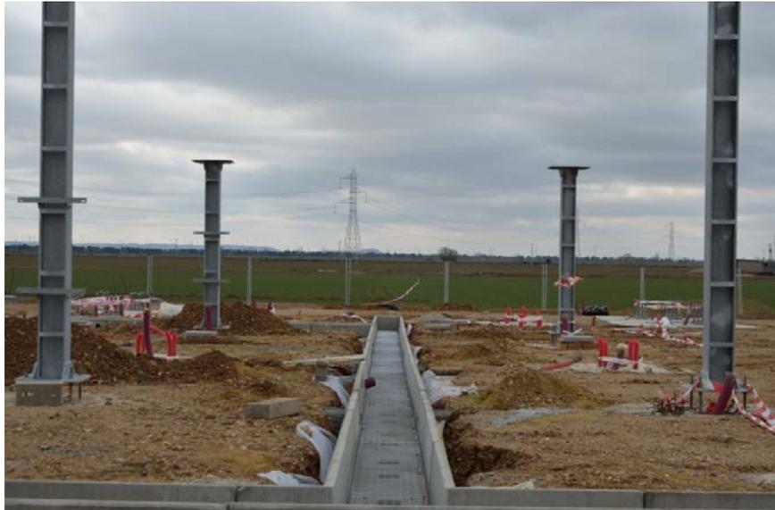
Imagen 60: canaleta en el parque exterior de la SE\_111 con rejilla instalada.
