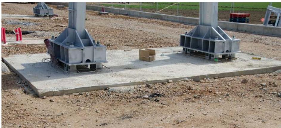
Imagen 45: detalle de los anclajes de los pórticos de entrada de las subestaciones.
