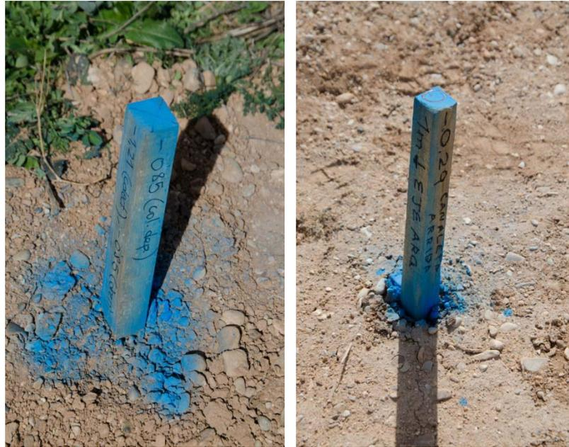
Imagen 61: detalle del marcaje de cotas en la red de saneamiento.
