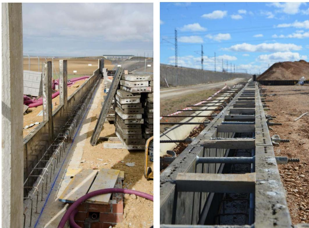
Imagen 68: detalles del encofrado del muro y el marcaje de alineaciones sobre zapata.
