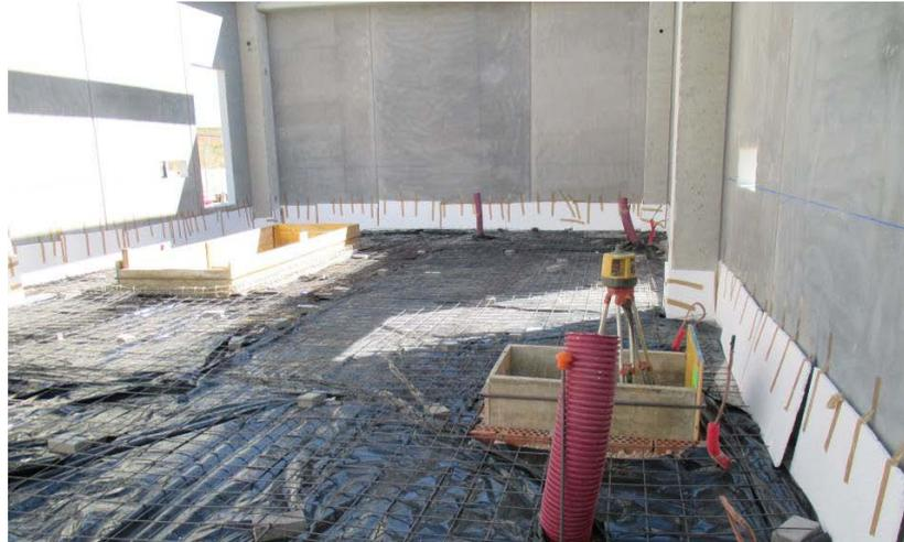
Imagen 35: estado previo al hormigonado de la losa interior del edificio.
