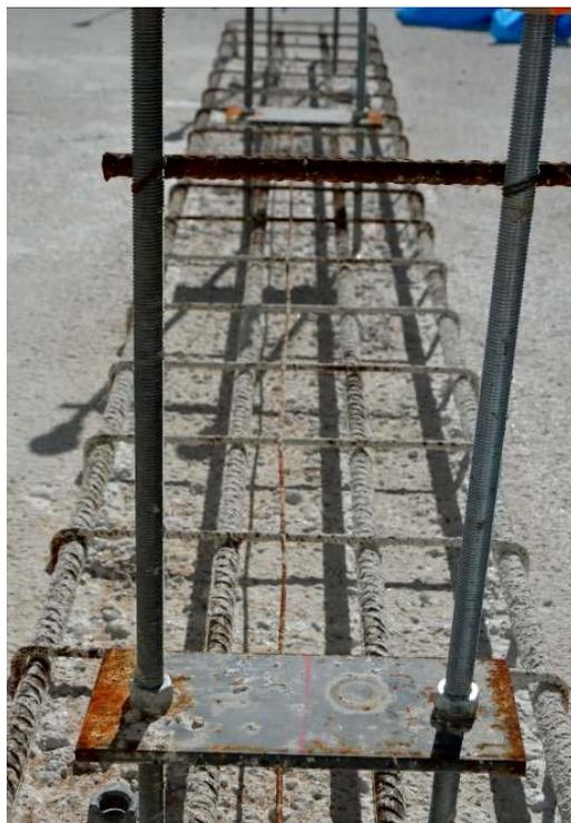
Imagen 23: detalle del marcaje de los ejes de los raíles sobre las placas de apoyo
