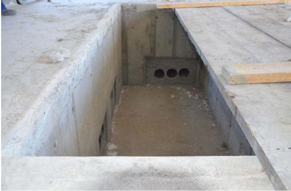
*Imagen 19: acabado final del foso de cables con las salidas para las canalizaciones eléctricas.*
