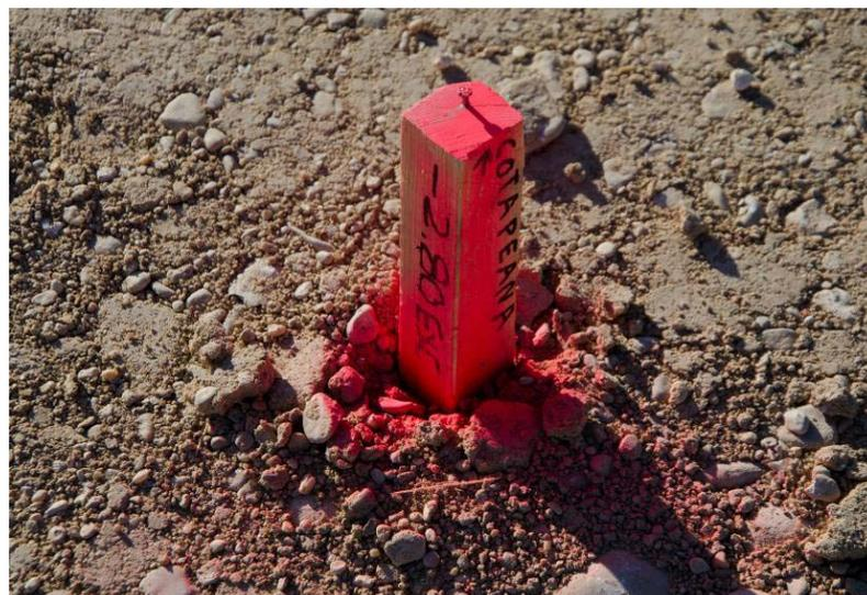
*Imagen 37: estaca a cota de peana con el eje de las aparamentas marcado con clavo de acero.*
