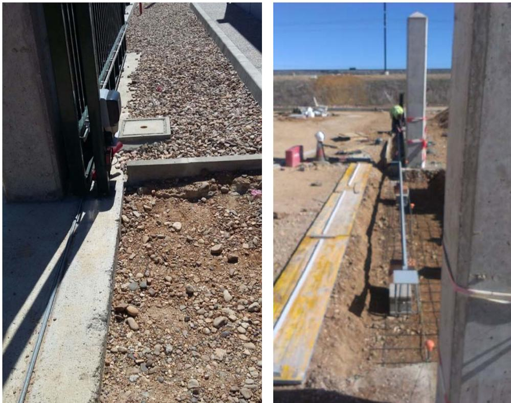
Imagen 84: error de ejecución en el bordillo del ATI de Becerril. Detalle de la cimentación de la guía en la subestación de Becerril.
