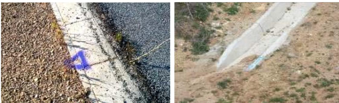
*Imagen 1: bases de proyecto materializadas con clavos de acero sobre canaleta eléctrica y bajante.*
