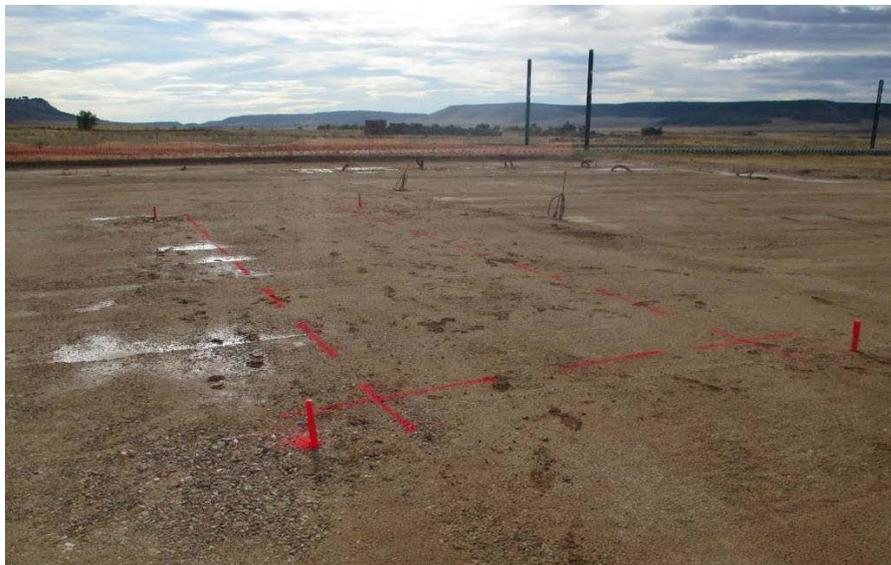
*Imagen 13: replanteo de la excavación del foso de cables en la subestación de Dueñas.*
