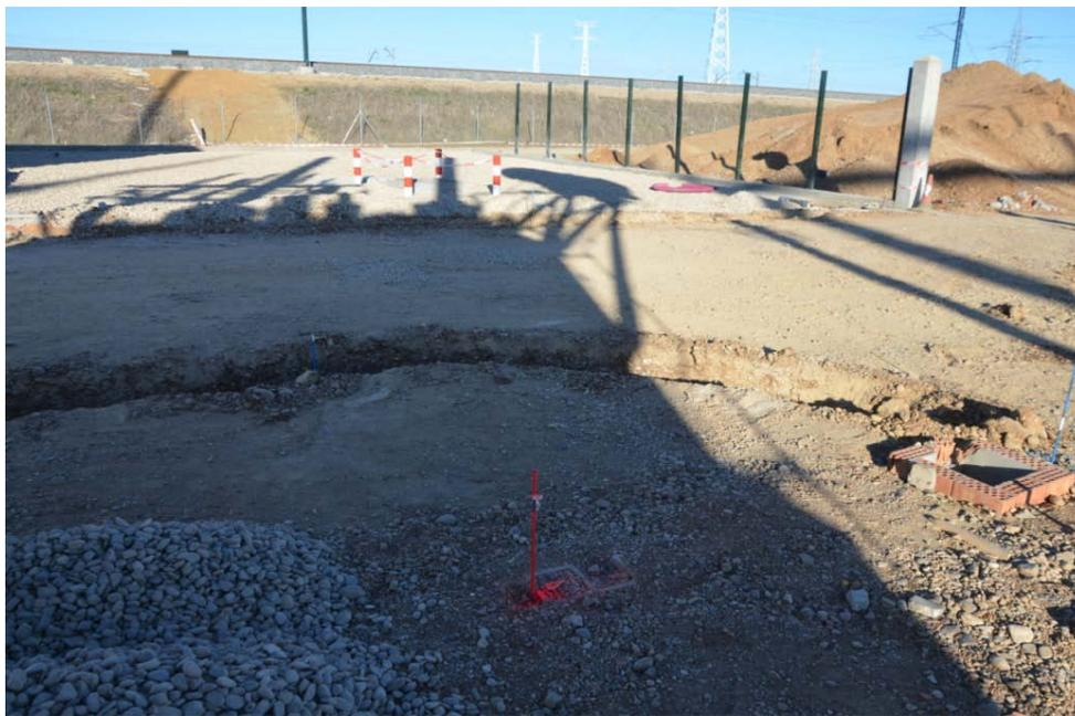
Imagen 75: detalle del replanteo de curvas en bordillos del parque exterior de la SE\_111.
