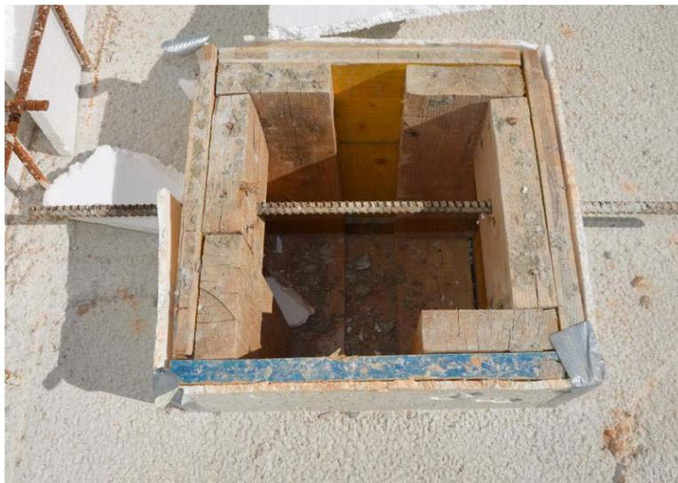
Imagen 29: arqueta para el vertido de aceite de los autotransformadores.
