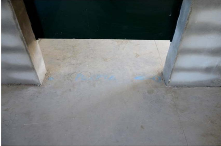
*Imagen 85: Marcaje de las alineaciones de los muros interiores y las puertas.*
