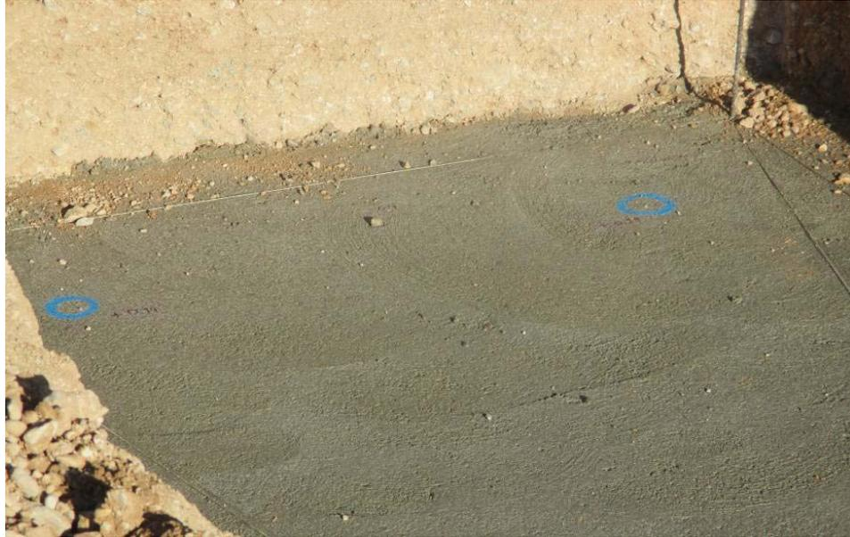
Imagen 15: replanteo de los límites del foso de cables sobre hormigón de limpieza.
