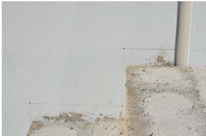
*Imagen 78: detalle del replanteo de los escalones.*
