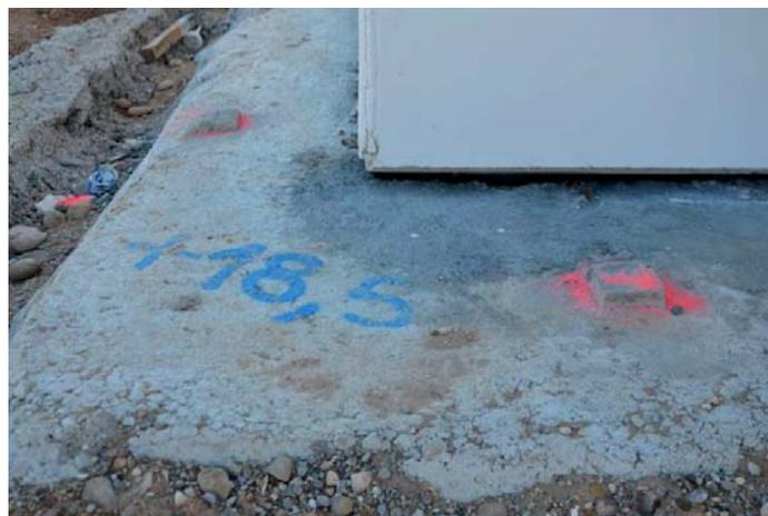
Imagen 33: línea de cerramiento y cotas relativas a la losa.
