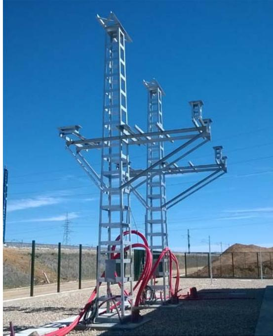
Imagen 41: feeders montados en la SE\_111.
