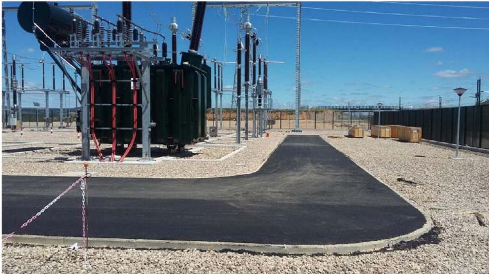
Imagen 87: vial acabado en la subestación de Dueñas.
