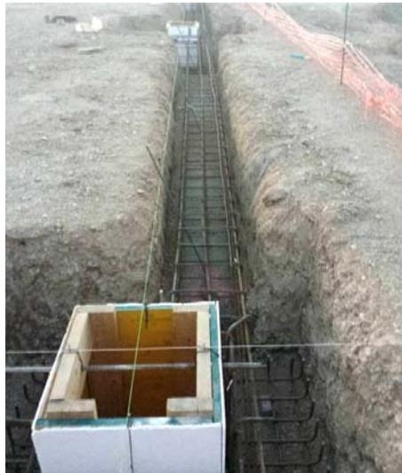
Imagen 12: marcaje sobre HL y alineado de armadura y cálices de los pilares.
