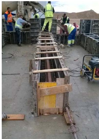
*Imagen 46: encofrado de las vigas del transformador en la SE\_104.*
