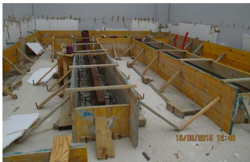
Imagen 27: encofrado de las vigas de apoyo del autotransformador.
