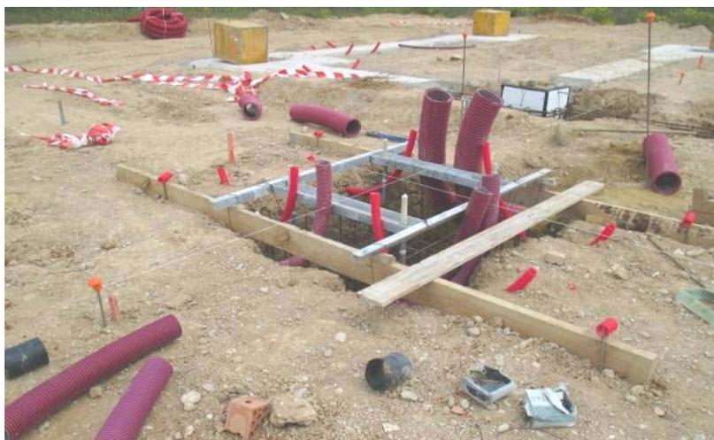
Imagen 39: plantilla para la instalación de los pernos de los pórticos.
