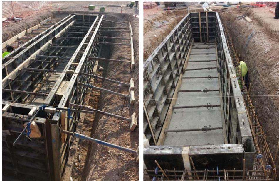
*Imagen 18: detalles del montaje de las chapas de encofrado en la subestación de Dueñas.*
