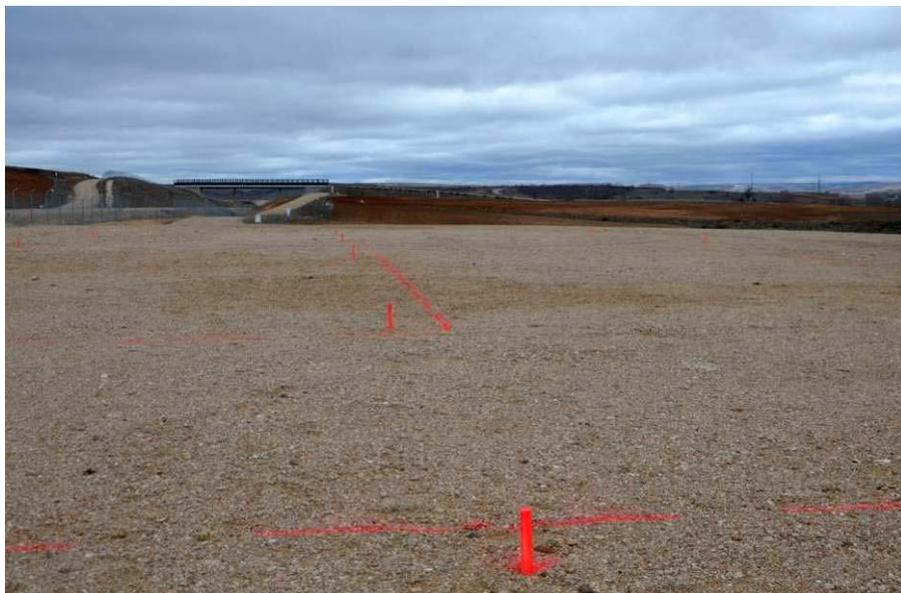
Imagen 5: marcaje del cajado para la ejecución de la red de tierras.
