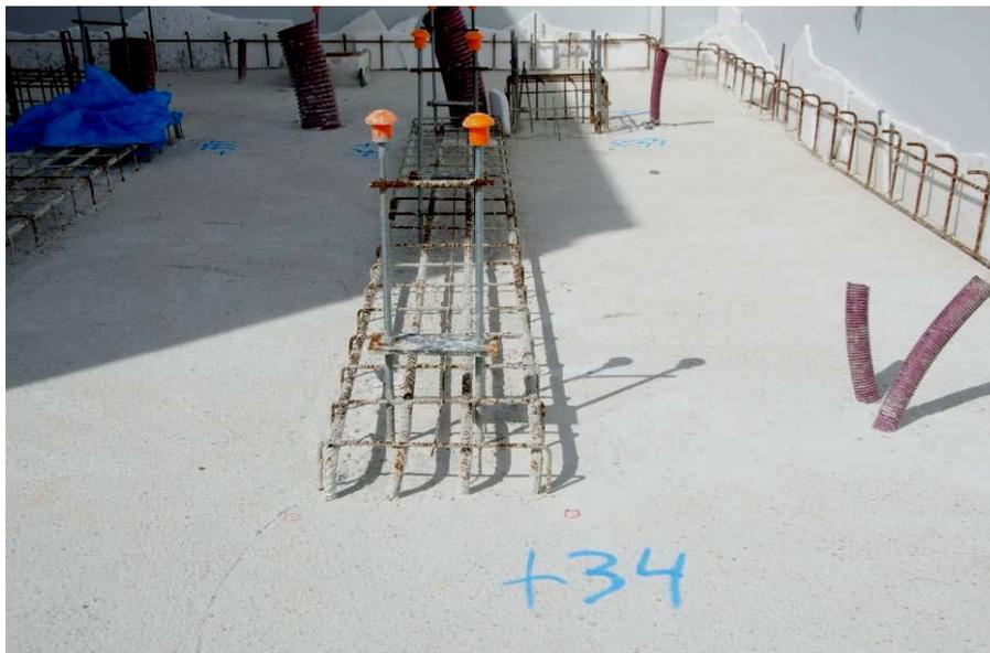
Imagen 22: detalle del replanteo de las vigas de apoyo del transformador.
