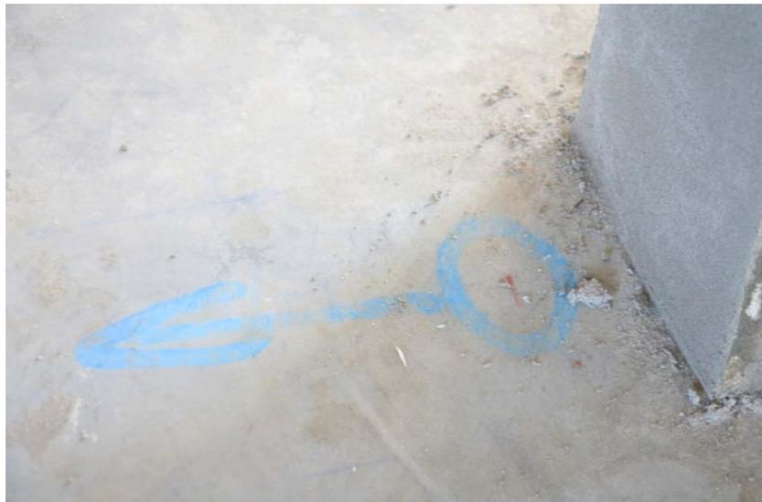
*Imagen 86: detalle del replanteo de los huecos de las puertas.*
