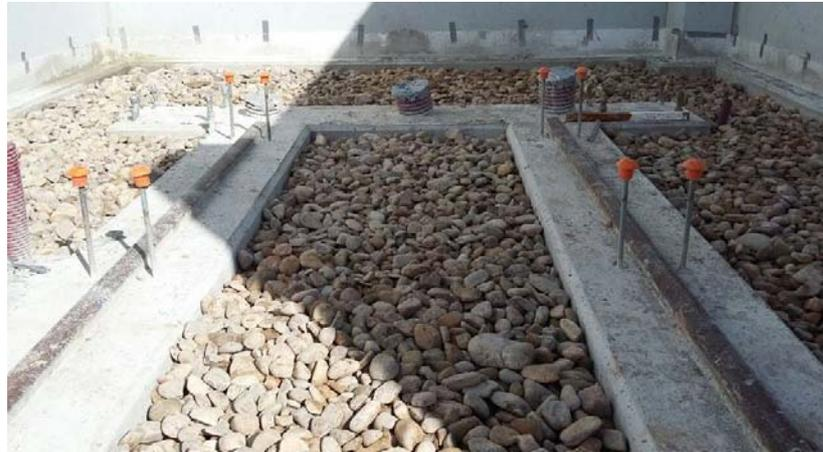
Imagen 32: detalle del acabado final de los vasos de los autotransformadores
