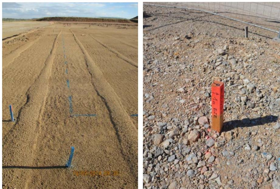
Imagen 66: detalles del replanteo para la zanja de cimentación del muro de cerramiento.
