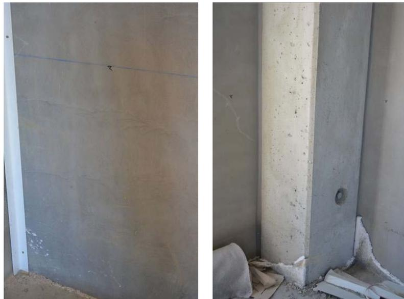
Imagen 34: marcaje de la cota de la losa +1 m en los paneles prefabricados.
