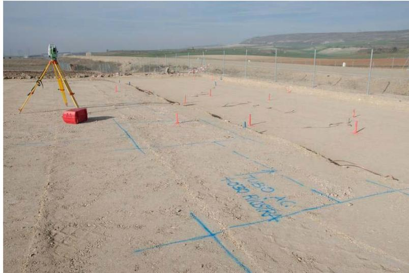
Imagen 9: marcaje del pasamuros para evacuar el vaso de aceite en un ATI.
