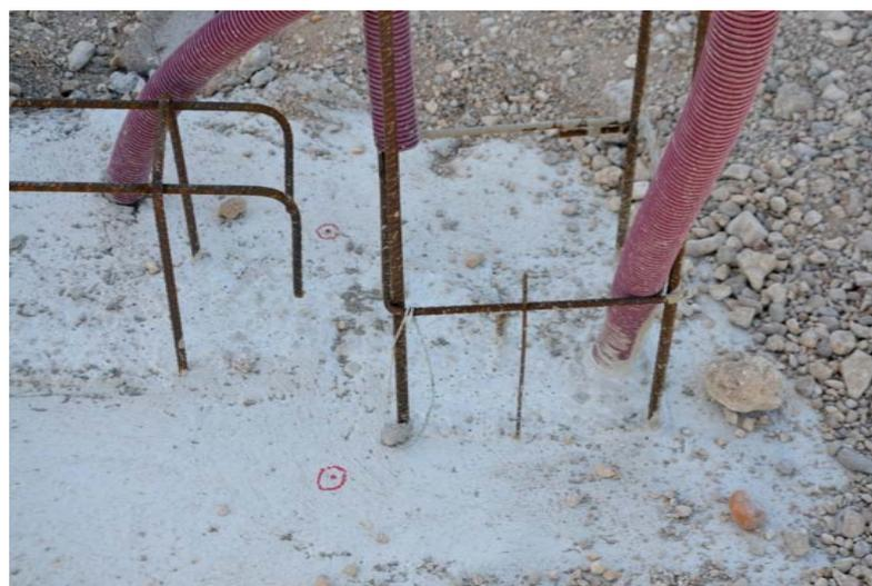
Imagen 83: detalle del replanteo de las caras del pilar sobre la cimentación.
