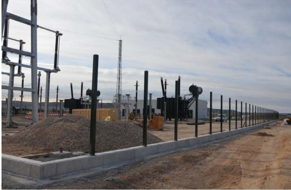
Imagen 69: montaje del vallado sobre cerramiento perimetral de la SE de Dueñas.
