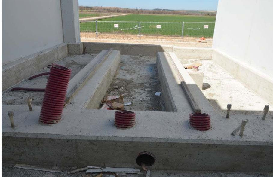
Imagen 28: vista posterior del vaso para el autotransformador tras el 2º hormigonado.
