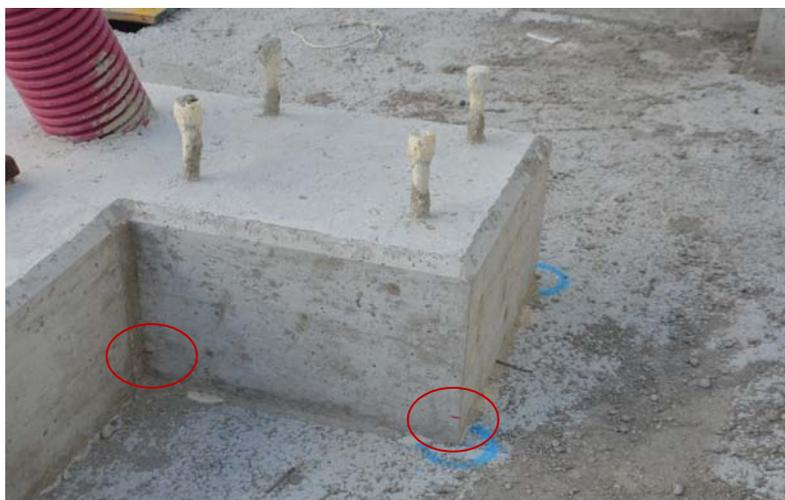
Imagen 30: detalle del marcaje de cotas para la capa de pendientes.
