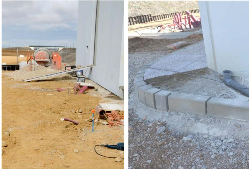
Imagen 72: replanteo del bordillo con varillas de acero y cinta aislante. Acabado en curva.
