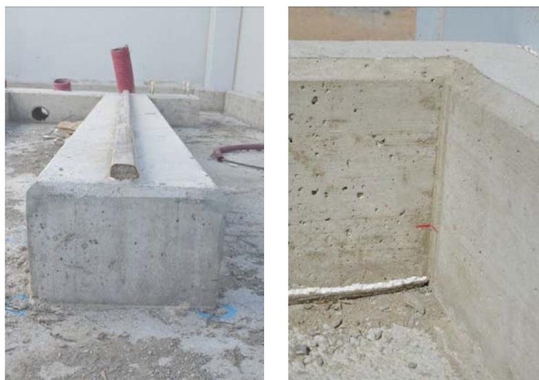
Imagen 31: detalles del marcaje de cotas para la capa de pendientes.
