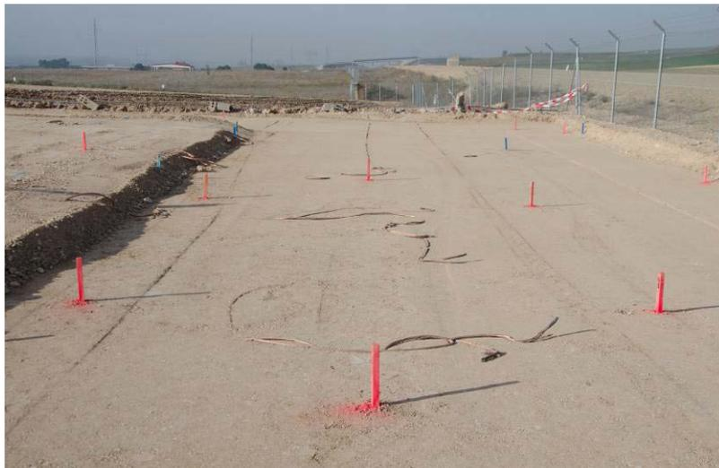
Imagen 38: replanteo de los ejes de los pórticos en ATI 105.2.
