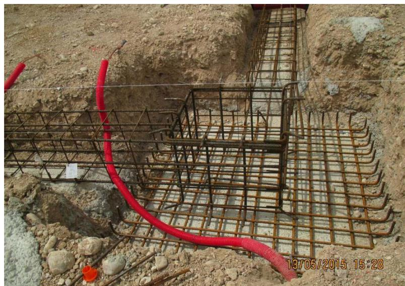
Imagen 10: pasamuros para cables de la red de tierras a través de la armadura.
