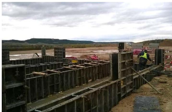
*Imagen 47: detalle del encofrado de la cimentación para el apoyo de uno de los transformadores en la subestación de Dueñas.*
