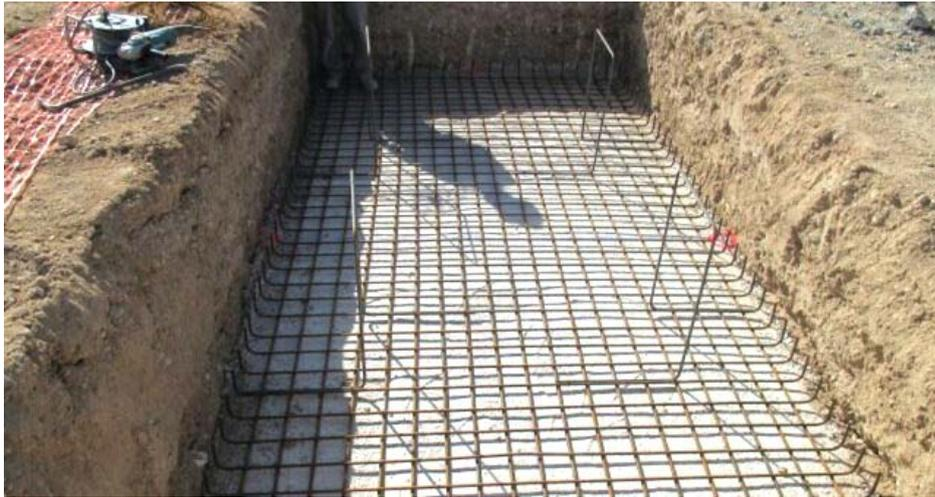
Imagen 43: ejes sobre el HL y montaje de la parrilla inferior en cimentaciones Z3.
