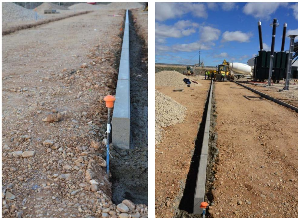
Imagen 76: proceso de hormigonado de los bordillos en los viales de la SE\_111.
