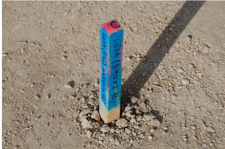
*Imagen 53: detalle del replanteo de la excavación del depósito de aceite y su eje longitudinal en un centro ATI.*
