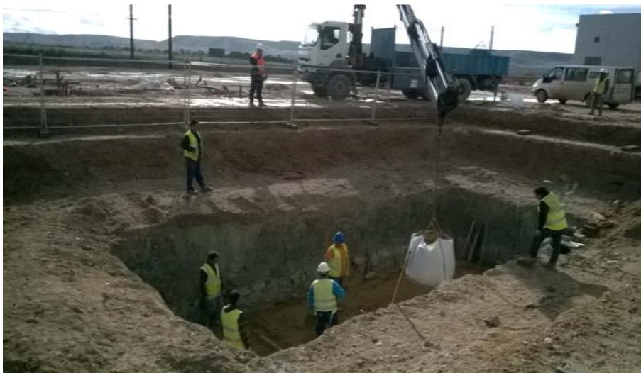
*Imagen 56: ejecución de la cama de arena donde asentará el depósito de aceite de la subestación de Dueñas.*
