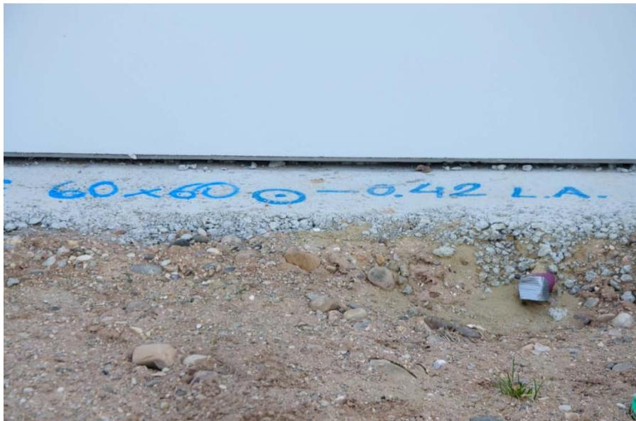
Imagen 65: marcaje de la salida de aceite del autotransformador sobre cimentación del edificio.
