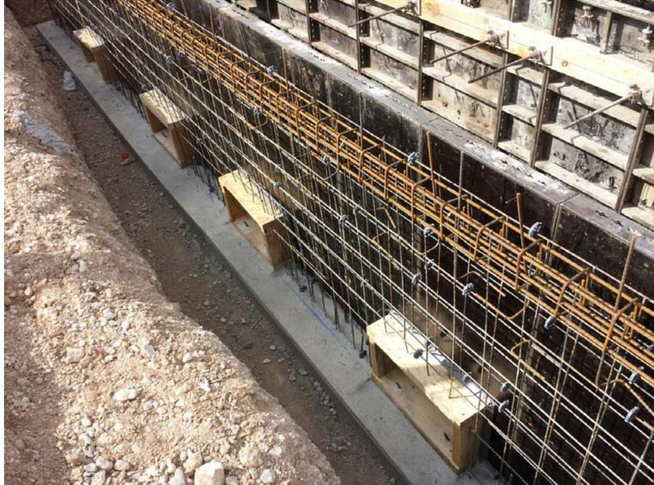
*Imagen 17: cajones para la salida de cables del foso de la subestación de Dueñas.*
