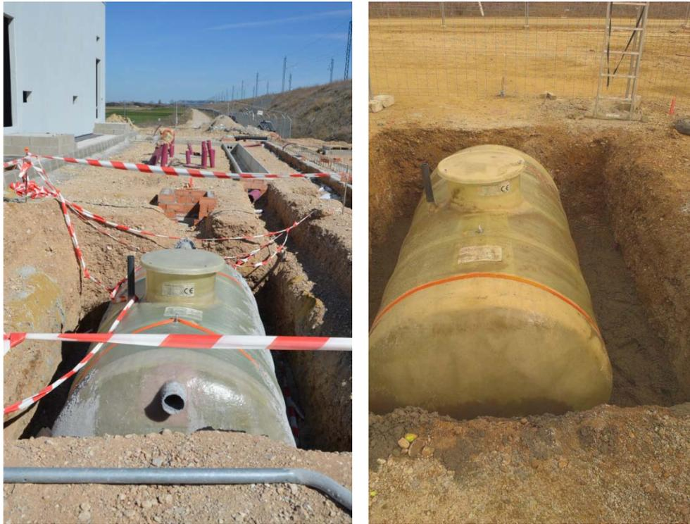
Imagen 54: depósito de aceite en centros de transformación intermedios.
