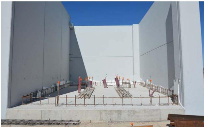
Imagen 25: vista frontal del vaso del autotransformador.
