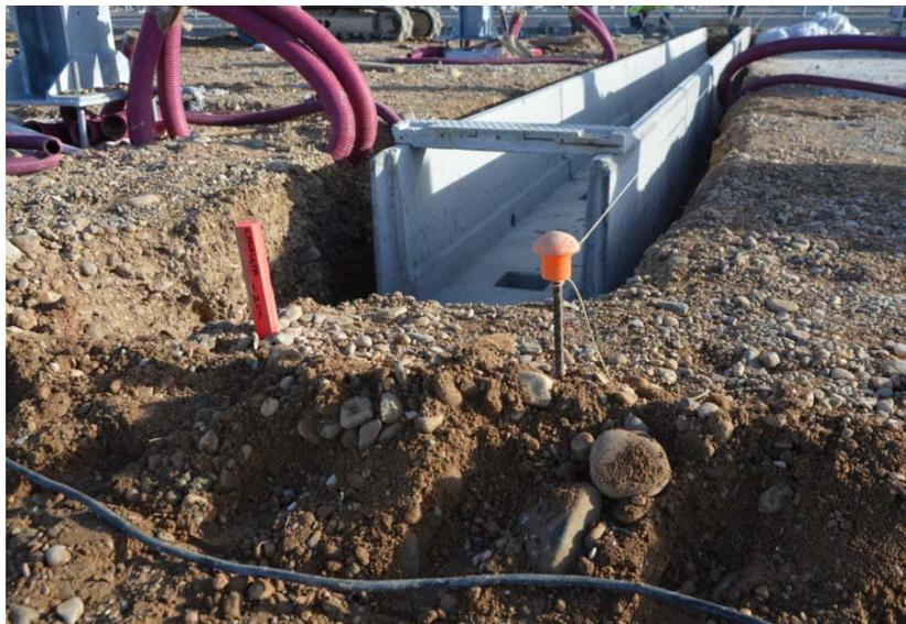
*Imagen 59: detalle del marcaje de cotas en canaleta.*
