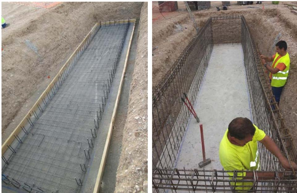
Imagen 16: losa y tareas de atado de la armadura del foso de cables en la subestación de Dueñas.
