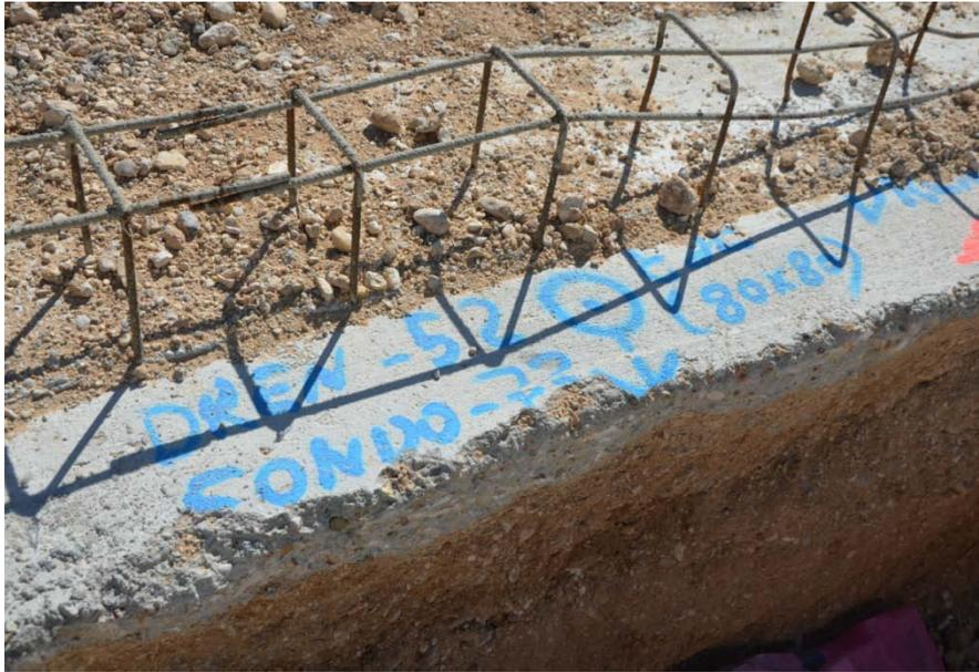
Imagen 63: cotas de la red de saneamiento y drenaje sobre la cimentación del muro de cerramiento.
