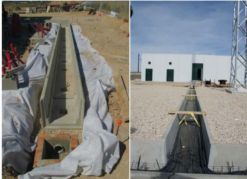
*Imagen 58: canaleta eléctrica junto a pórticos de acometida en ATI y junto a transformadores en la SE\_111.*
