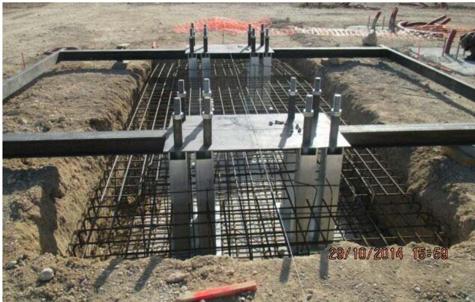
Imagen 44: ejes longitudinales y transversales con varillas de hierro y plantilla de montaje.
