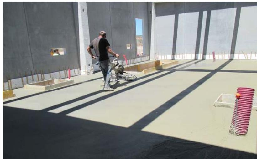
Imagen 36: pulido de la superficie de la losa para el acabado final.
