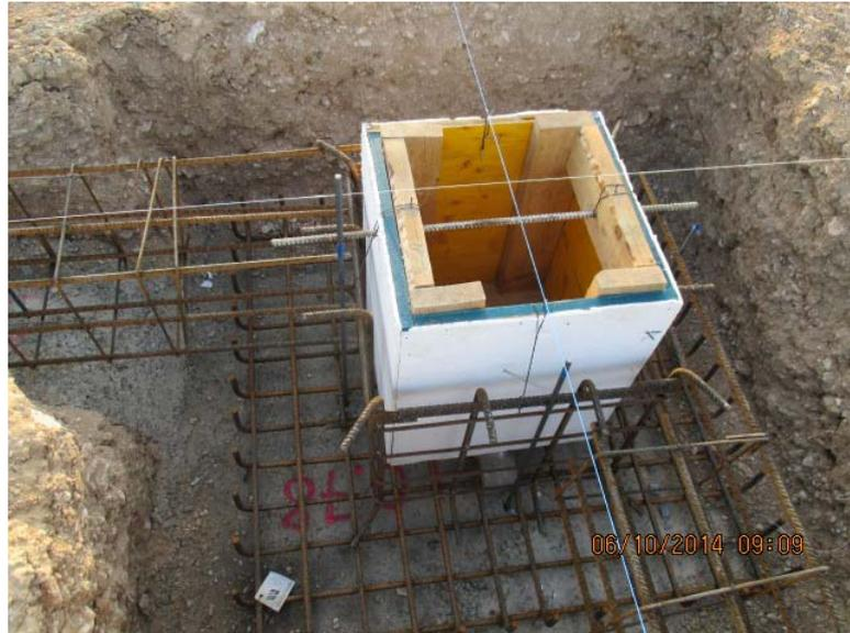
Imagen 11: marcaje sobre HL y alineado de armadura y cálices de los pilares.
