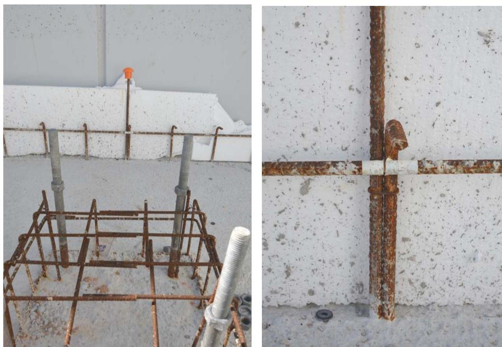
Imagen 24: detalle de la señalización de los ejes del vaso del autotransformador.
