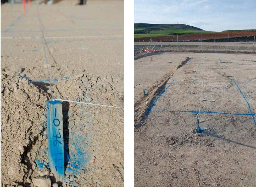
Imagen 8: detalle del replanteo de las alineaciones de los ejes de los pilares y de la riostra.
