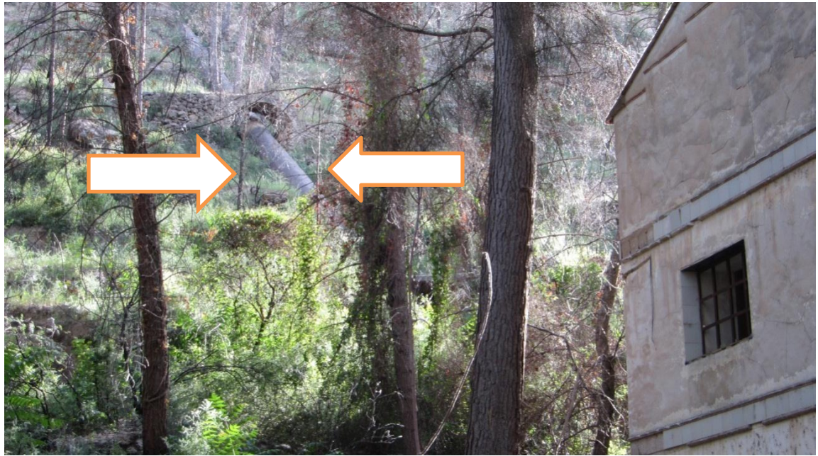
Figura 13: Tubería forzada empleada en su época. Fuente: Propia.
