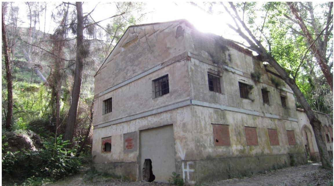
Figura 14: Fachada exterior del antiguo edificio de la central. Fuente: Propia.
