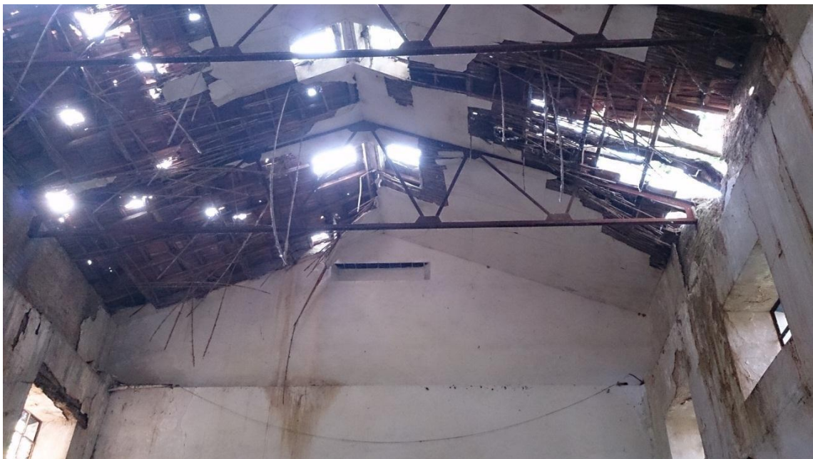
Figura 15: Interior del antiguo edificio de la central. Fuente: Propia.
