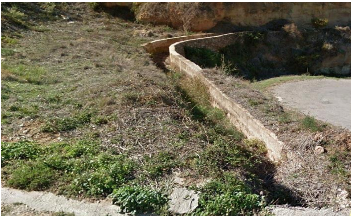
Figura 1: Estado actual de canal. Fuente: Propia.
