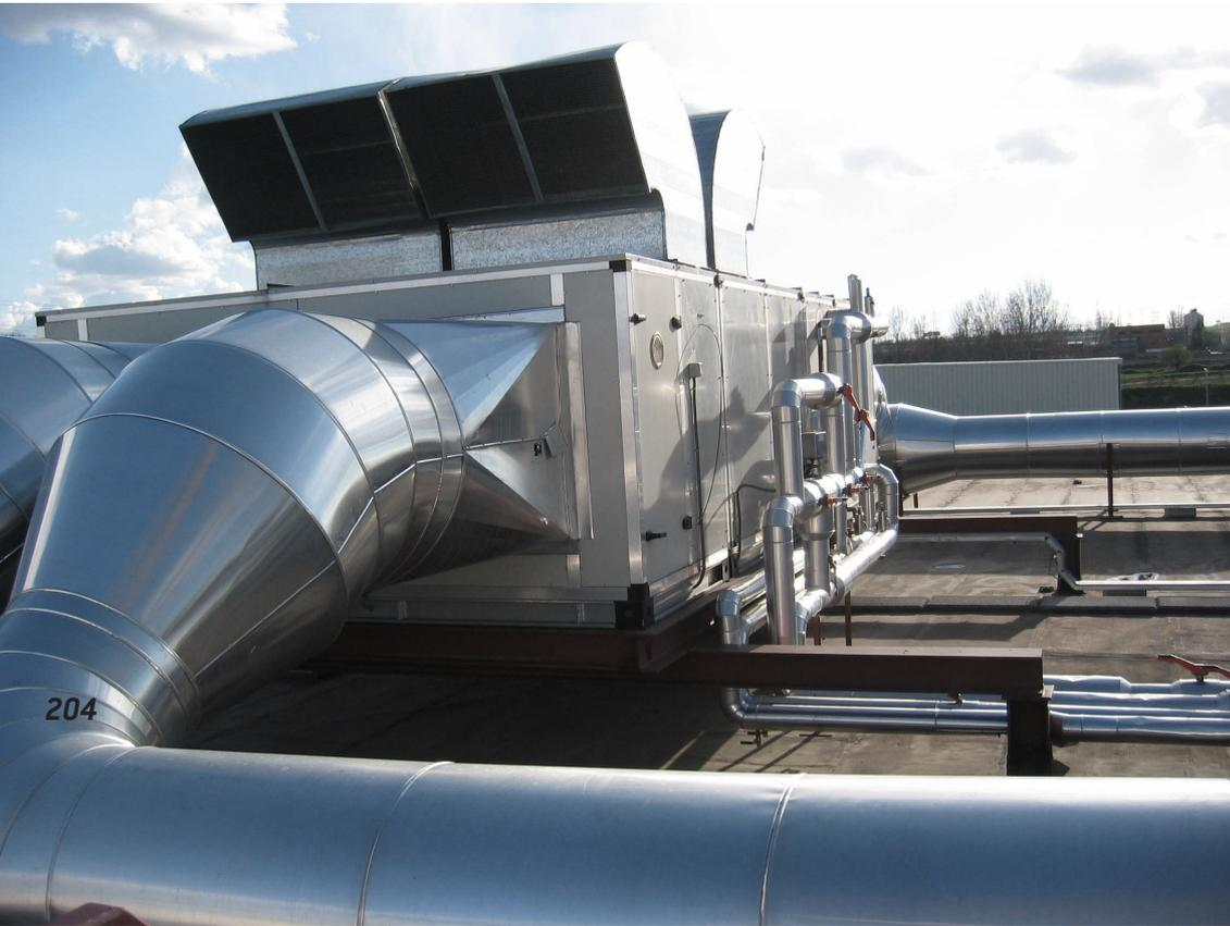
Para la climatización de nuestro edificio utilizaremos el que, según algunos estudios, es uno de los métodos de climatización más eficientes en este momento. Climatización por bomba de calor. El equipo se basa en una bomba que absorbe calor de una fuente para entregarla a otra que está a una temperatura superior.
