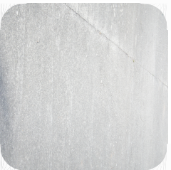
Pavimento bajo cubierta
