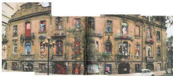
48. La toma del edificio Balmori (1990), Salón des Aztecas.
