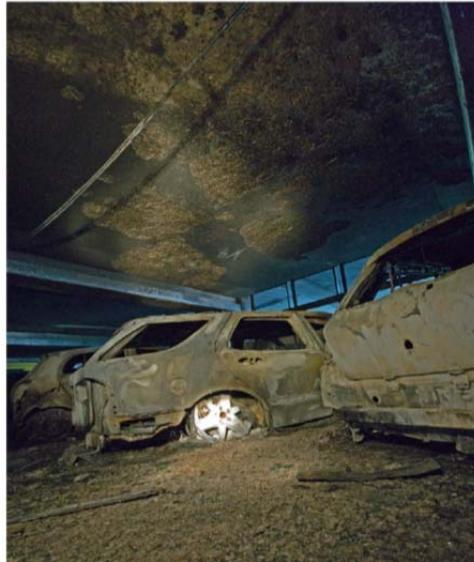
*Figura 3.24. Spalling de superficie después de un incendio en un aparcamiento [33].*
