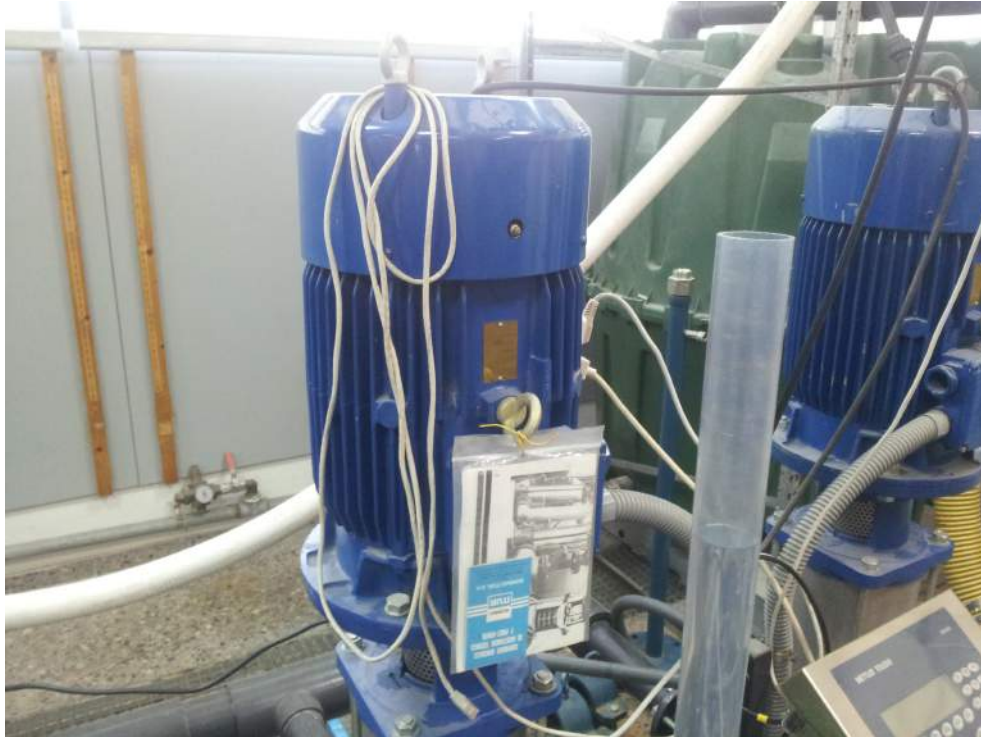
Figura 36. Bomba multicelular.
