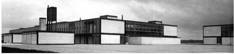
Fig. 42. Escuela de Secundaria Hunstaton, 1950-54
