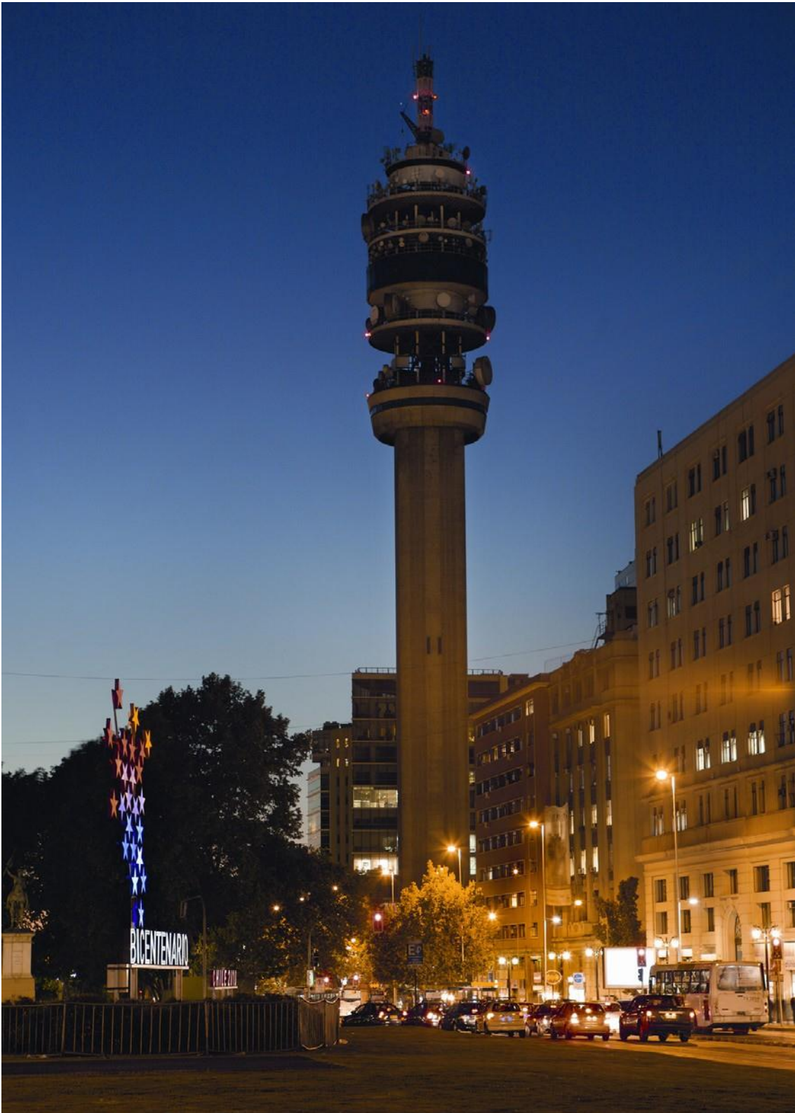
Figura 42. INFRAESTRUCTURA DE TELECOMUNICACIONES CENTRO DE SANTIAGO, 2002.
