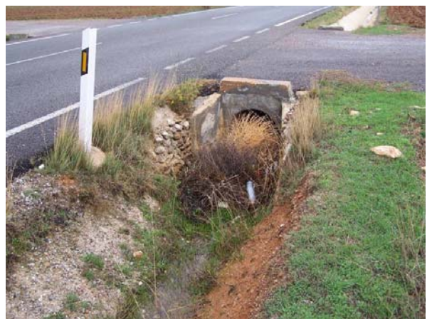
Imágenes 9 y 10: Desagüe de la cuneta . Fecha de captura: Izquierda septiembre 2012, derecha octubre 2012
