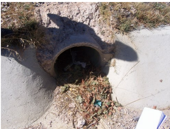
Imágenes 9 y 10: Desagüe de la cuneta . Fecha de captura: Izquierda septiembre 2012, derecha octubre 2012
