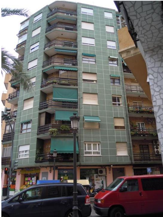
*Ilustración 34. Fotografía fachada revestida con mortero monocapa.*
