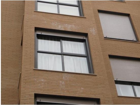
*Ilustración 38 Partes de encuentro de la fachada con la carpintería en edificio de estudio. Abril 2015*
