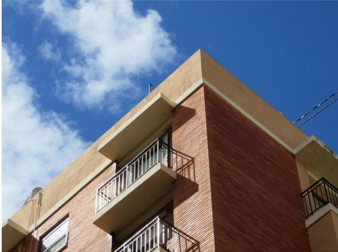
*Ilustración 48 Ejemplo de antepecho en cubierta plana en edificio de estudio.
