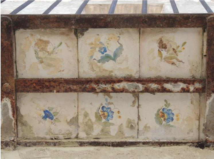
*Balcón o balcones de la fachada se hacían con estructura de hierro anclada a la fachada, y como solado una losa con cerámica colocada invertida (para que se viera desde la calle), como se da en la vivienda que nos ocupa.*
