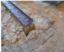
Forjado con la pieza de refuerzo ensamblada.
