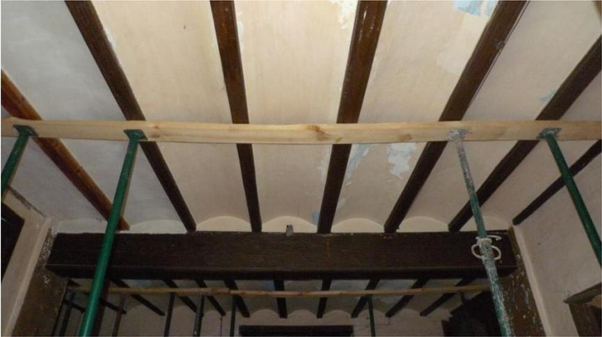
VIGAS Y VIGUETAS DE MADERA DE MÓBILA. FORJADOS UNIDIRECCIONALES APOYADOS. REVOLTONES DE YESO CURVOS.
