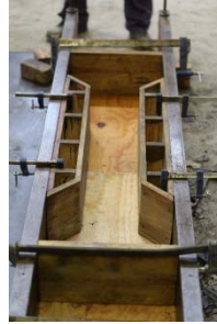
fig. 21 Encofrado montado.
