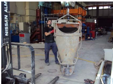
fig. 52 Movimiento con grúa puente
