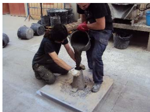
fig. 48 Preparando ensayo de escurrimiento.
