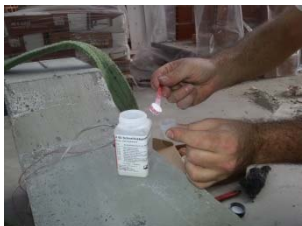
fig. 68 Dosificando el adhesivo
