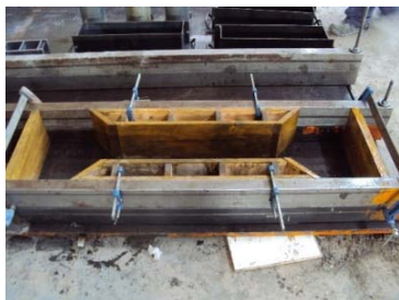
fig. 37 Encofrado preparado.
