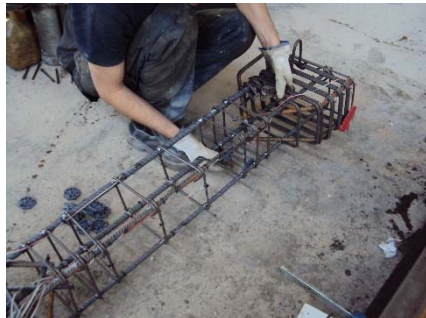
fig. 40 Colocación de los separadores.
