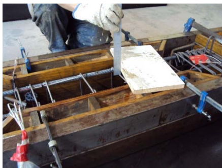
fig. 41 Comprobando el recubrimiento
