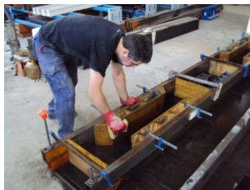
fig. 38 Puesta de desencofrante final.
