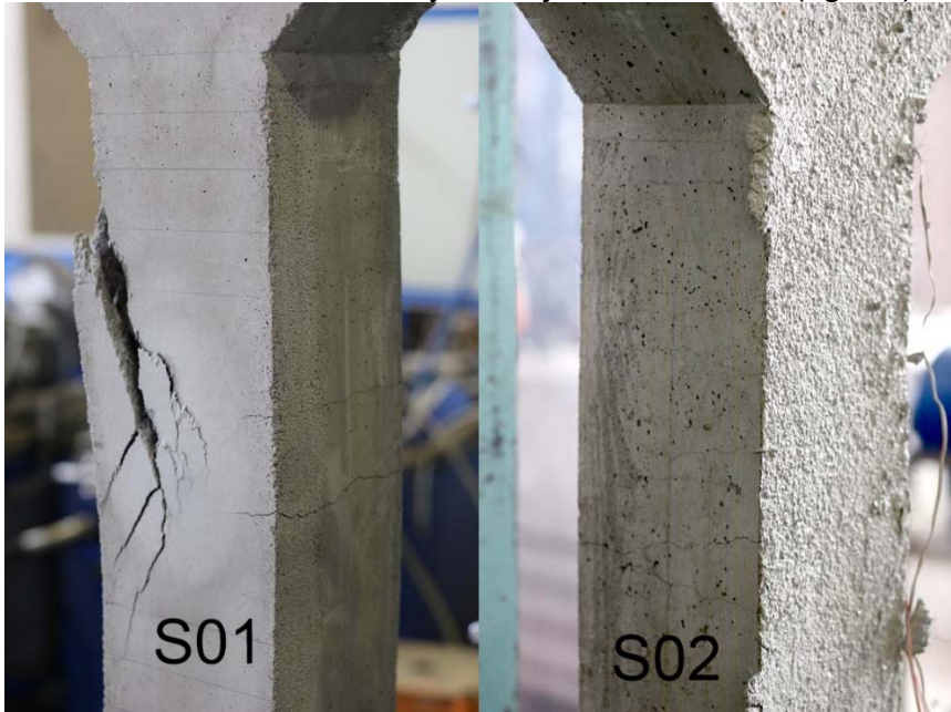
fig. 85 Fisuras en cara traccionada de ambos elementos
