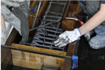
fig. 56 Llenado de las cabezas
