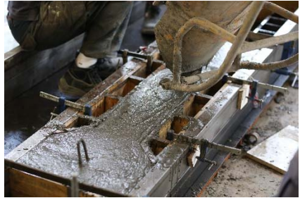
fig. 57 Finalizando el vertido
