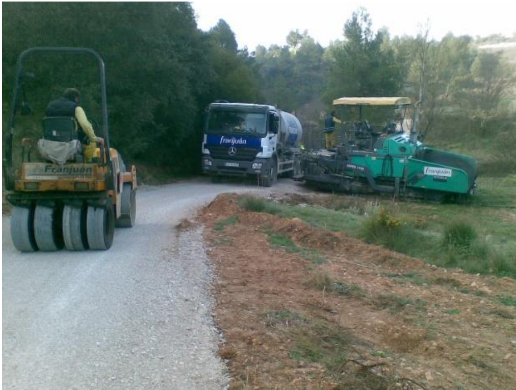
Foto 32. Asfaltado. Fuente: Propia.
