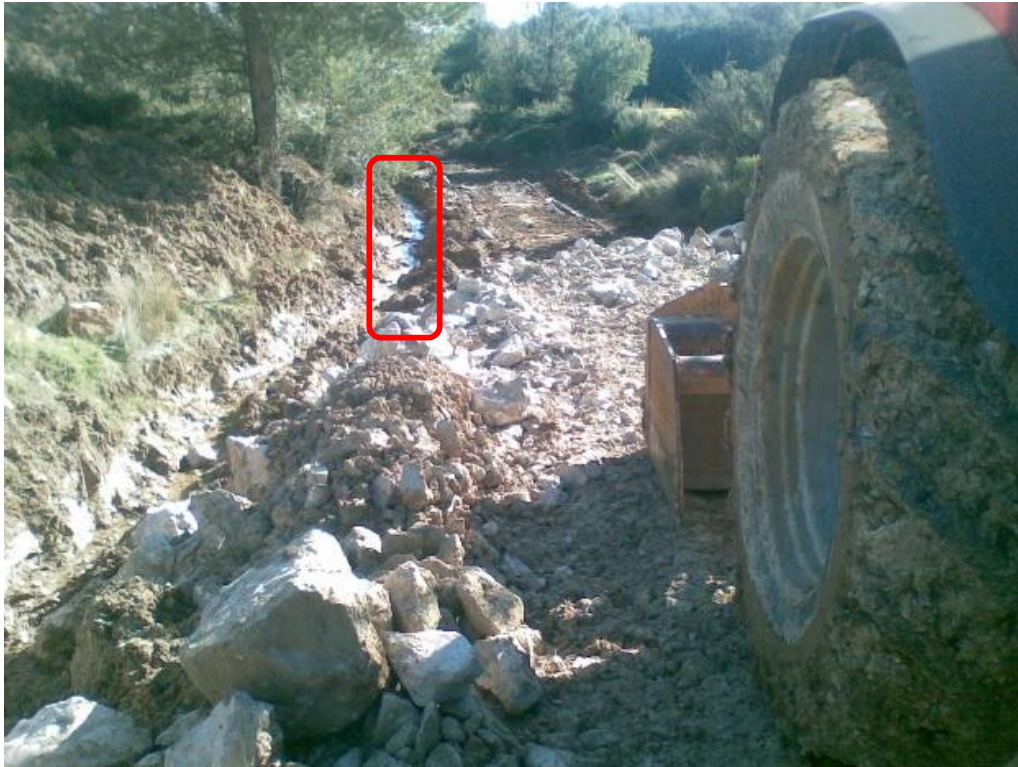
Foto16. Extensión de macadam en la zona de arroyo. Fuente: Propia.
