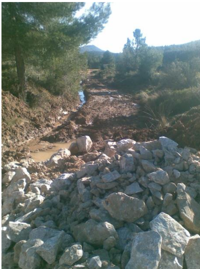
Foto 50. Excavación 1,30m y relleno de macadan.
