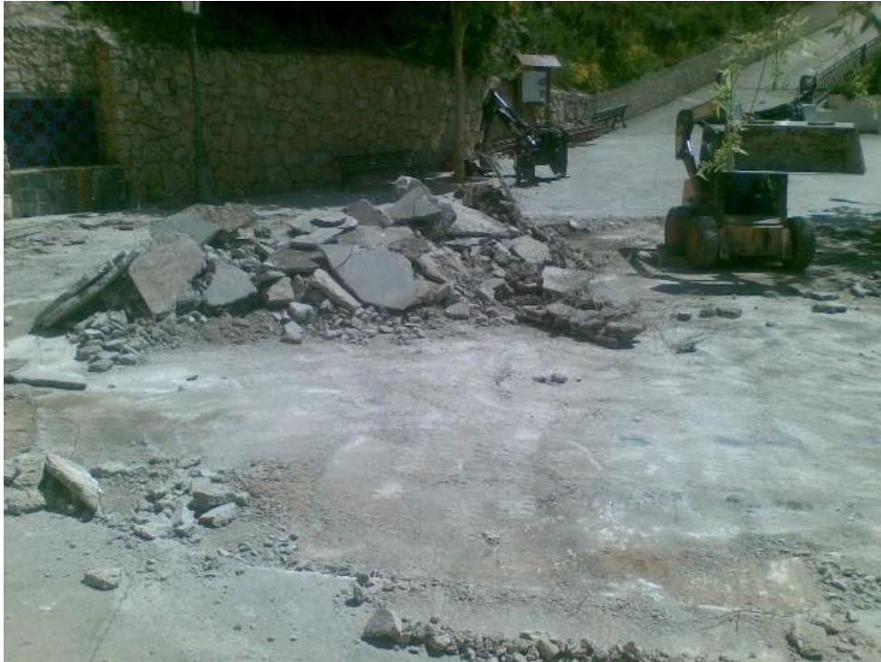
Foto 57. Demolición del firme en acceso aldea de El Oro.
