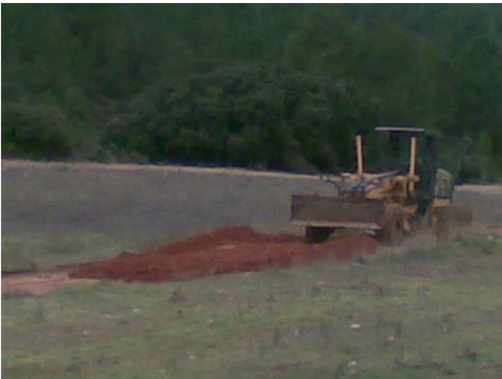
Foto 5. Extensión y rasanteo de motoniveladora. Fuente propia.
