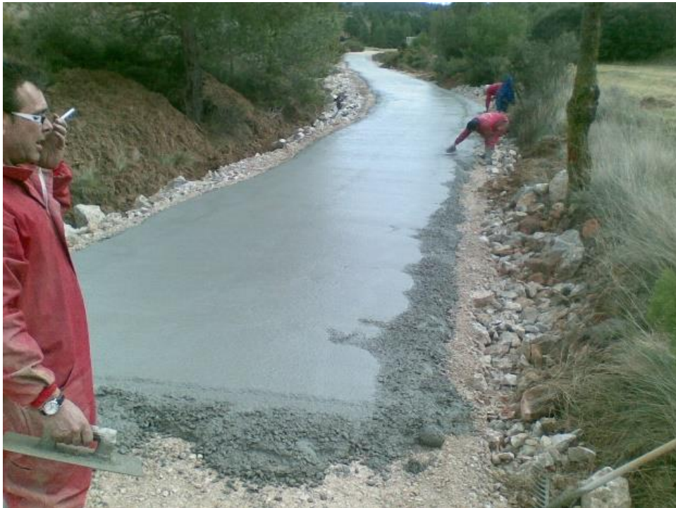
Foto 28. Pavimentación hormigón. Fuente: Propia.
