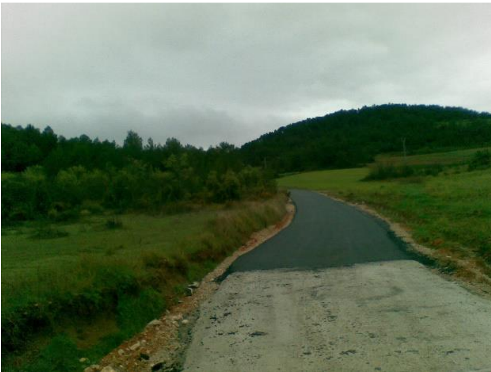
Foto 39. Comprobación si la humedad permite reanudar Asfaltado. Fuente: Propia.
