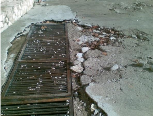
Foto 56. Estado previo firme acceso aldea de El Oro.
