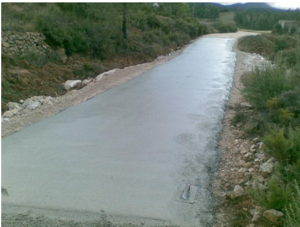
Foto 27. Pavimentación hormigón. Fuente: Propia.
