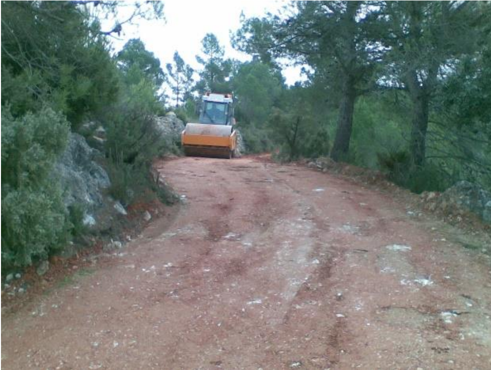
Foto 9: Compactación. Fuente: propia.
