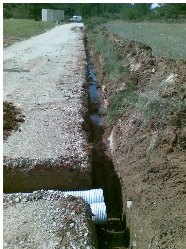
Foto 29. Pavimentación hormigón. Fuente: Propia.
