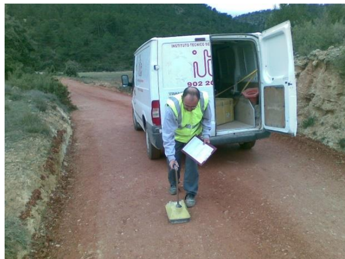
Fotos 45. Ensayos de compactación de Zahorras. Fuente: Propia.
