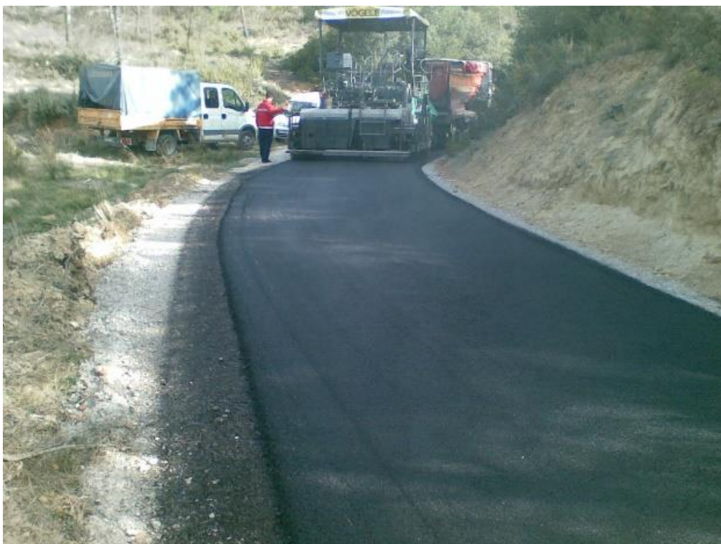
Foto 33. Asfaltado. Fuente: Propia.
