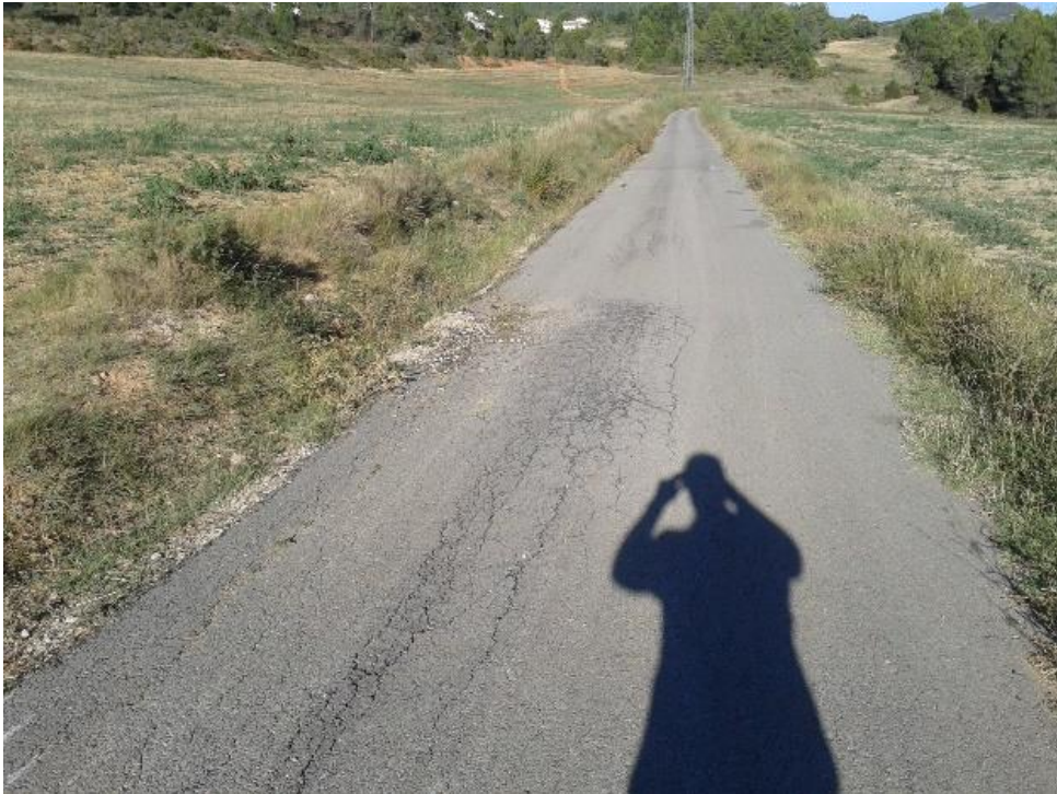
Fotos 63 y 64. Zona pavimento asfáltico agrietado. Fuente: Propia
