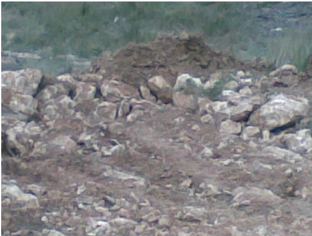
Foto 3. Picado de roca con el martillo de la retroexcavadora para cajar la sección tipo. Fuente propia.
