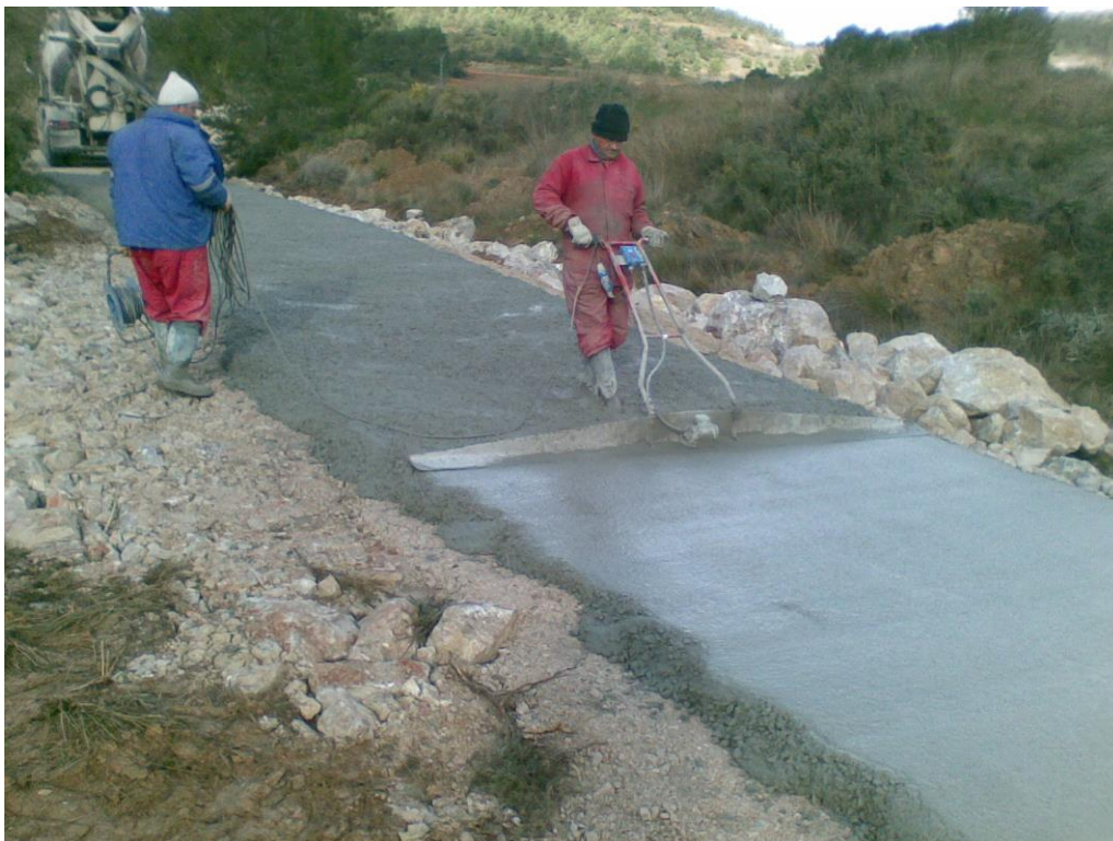
Foto 25. Pavimentación hormigón. Extendido y rasanteo con bandeja vibradora. Fuente: Propia.
