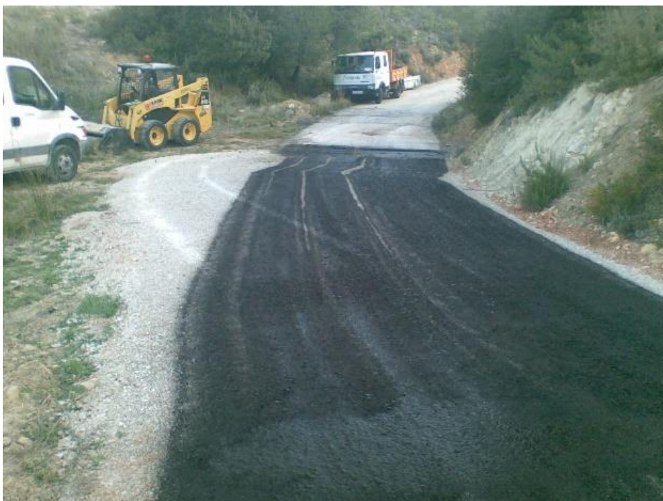
Foto 31. Aplicando imprimación. Fuente: Propia.
