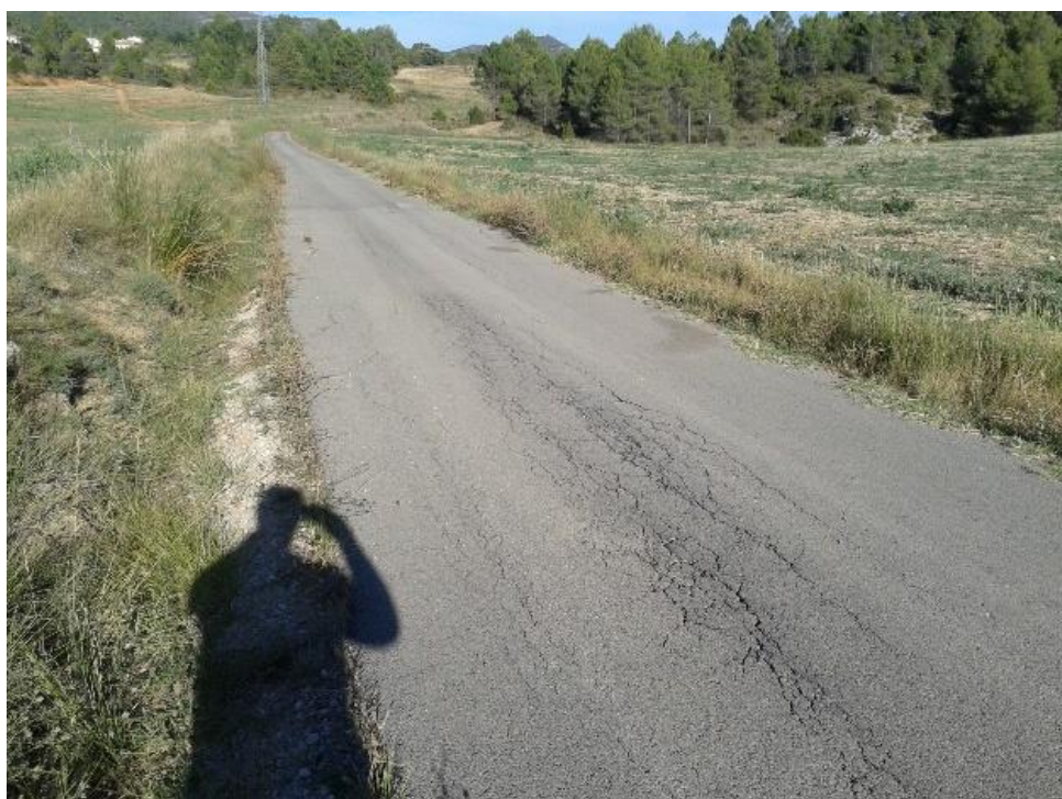
Fotos 63 y 64. Zona pavimento asfáltico agrietado. Fuente: Propia
