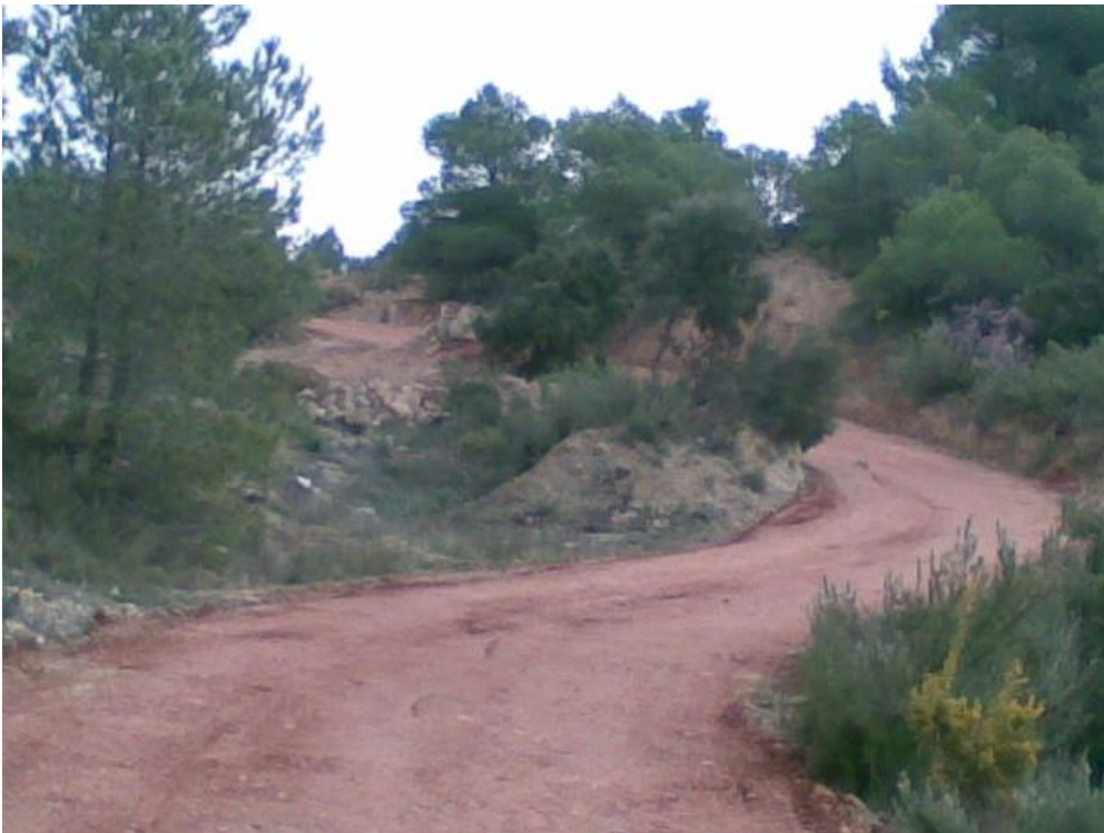
Foto 12. Zona Bosque. Concluída compactación Zahorra. Fuente: Propia
