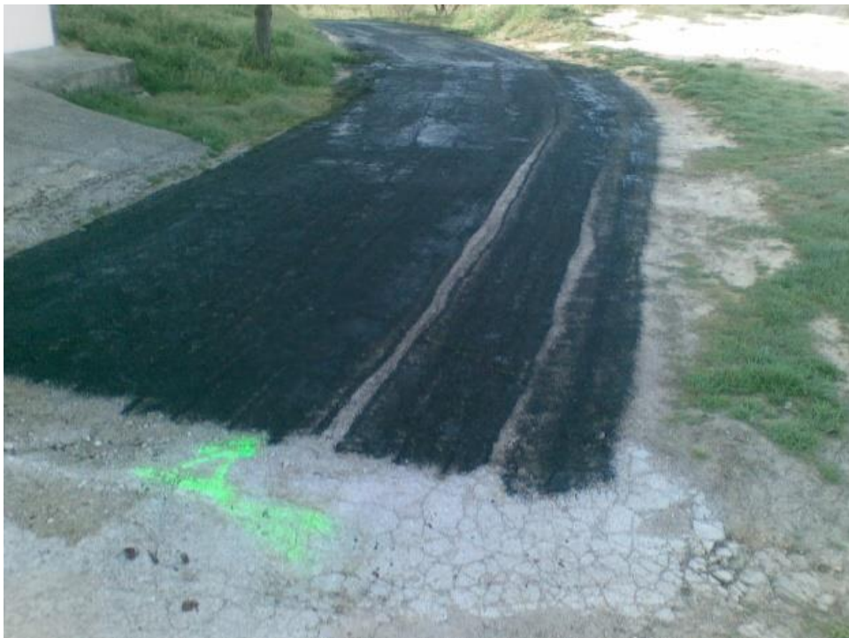
Foto 30. Aplicando imprimación. Fuente: Propia.
