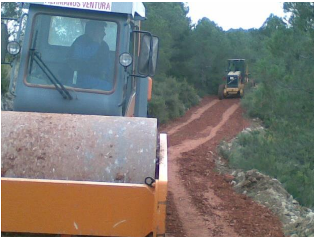
Foto8. Extensión, nivelación y compactación. Fuente: propia.
