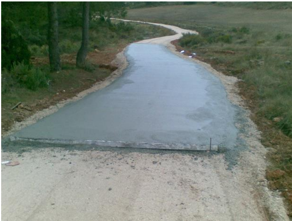
Foto 26. Pavimentación hormigón. Acabado. Fuente: Propia.
