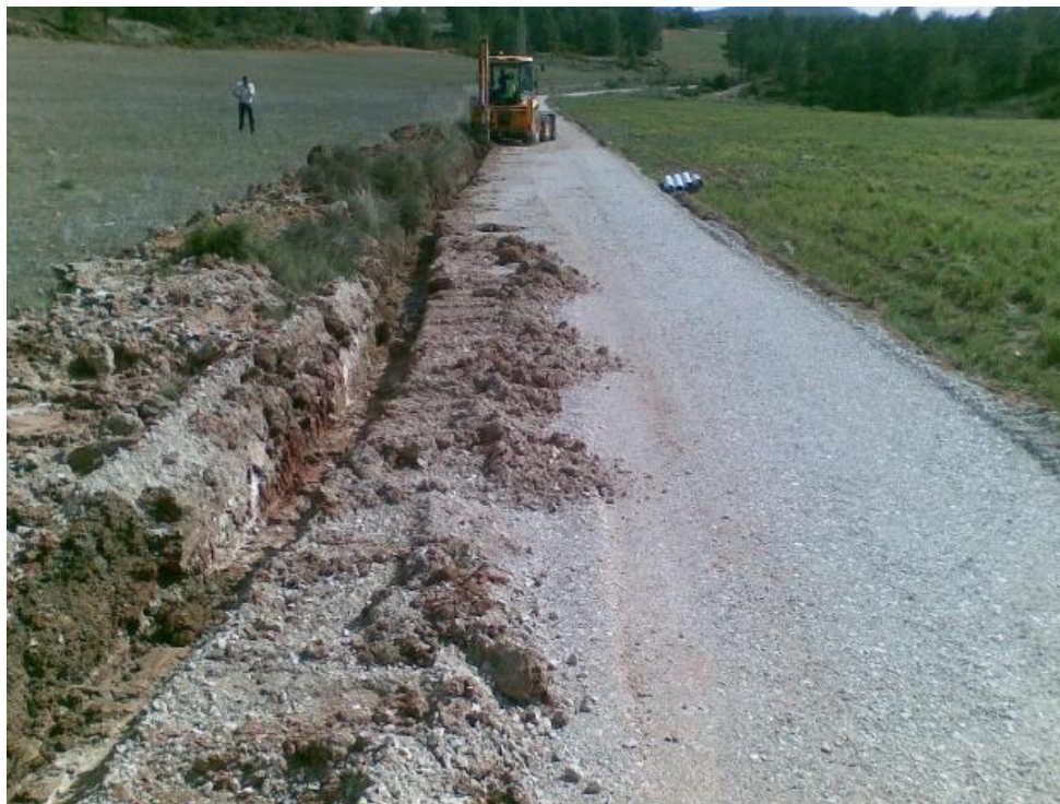
Foto 49. Ejecución de zanja colectora de 20ml. Fuente: Propia
