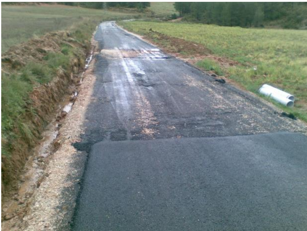
Foto 36. Interrupción por lluvias del Asfaltado. Fuente: Propia.
