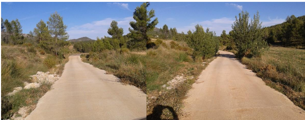
Fotos 61 y 62. Zona pavimento de hormigón en buen estado. Fuente: Propia
