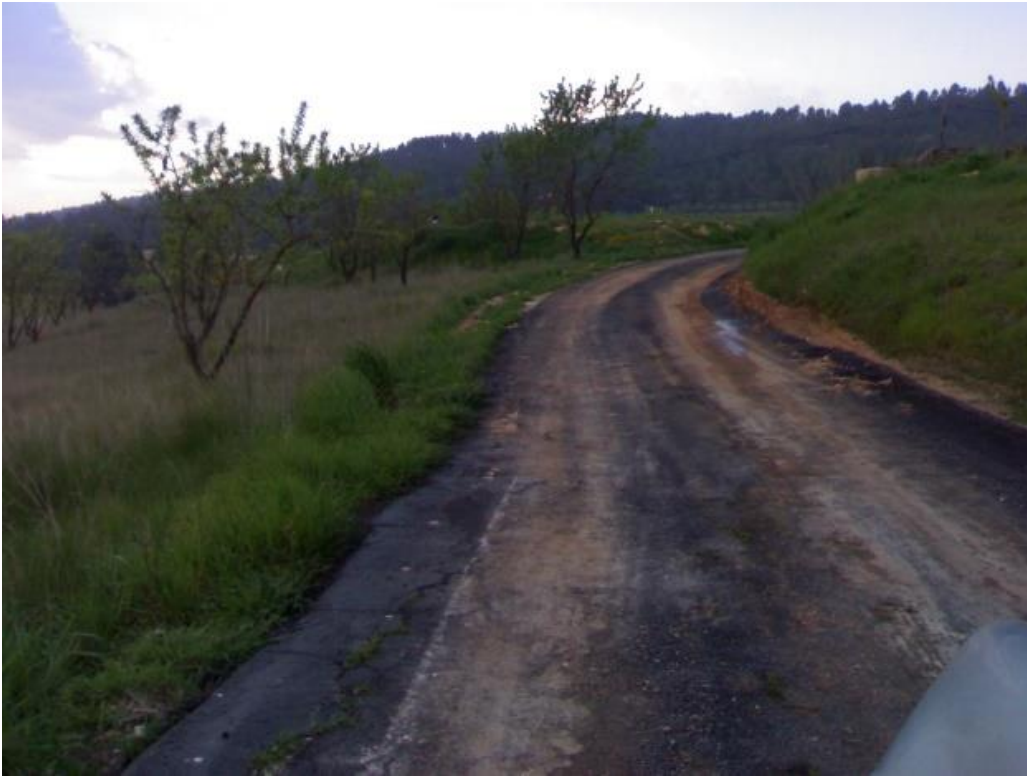
Foto 42. Continúa mojado. Fuente: Propia.
