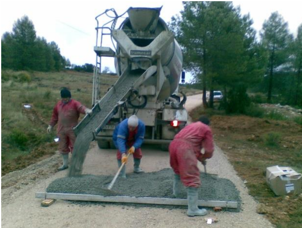
Foto 24. Pavimentación hormigón. Vertido y extendido. Fuente: Propia.
