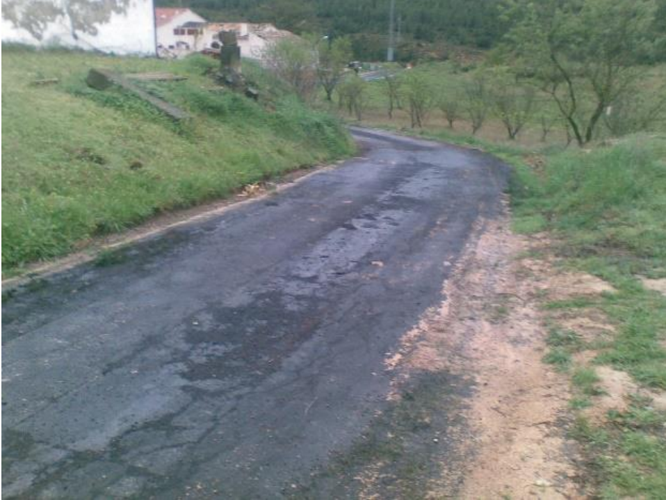
Foto 38. Comprobación si la humedad permite reanudar Asfaltado. Fuente: Propia.
