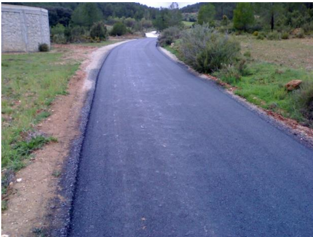
Foto 37. Interrupción por lluvias del Asfaltado. Fuente: Propia.
