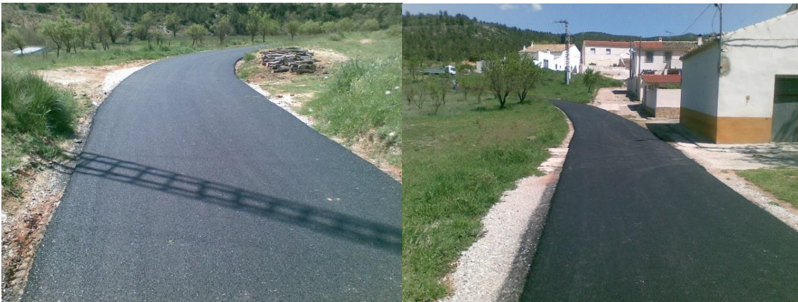
Fotos 43 y 44. Finalización Asfaltado. Fuente: Propia.
