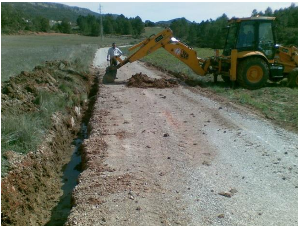
Foto 53. Colocación tubos de drenaje. Fuente: Propia.
