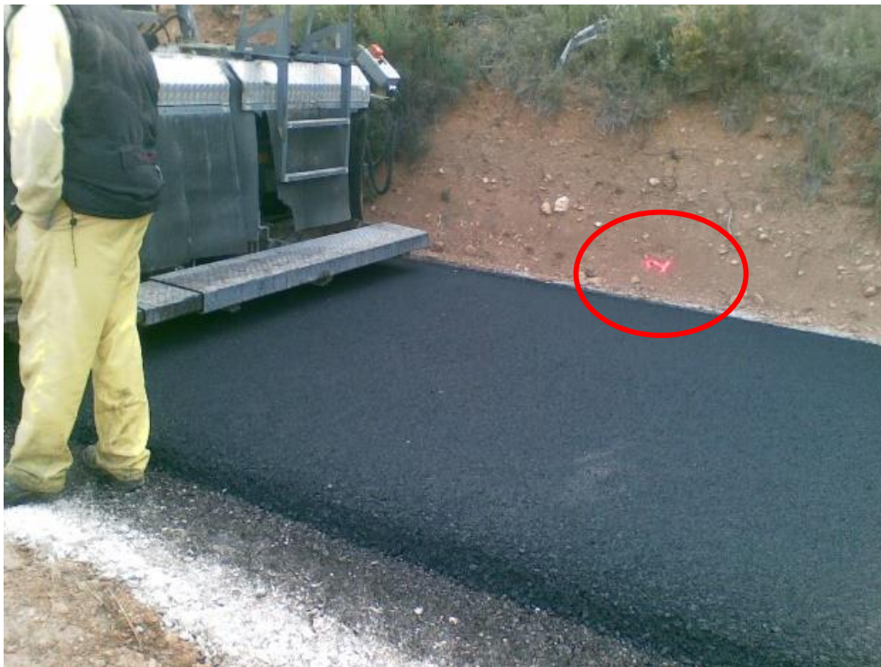
Foto 34. Asfaltado. Detalle control de ejecución Fuente: Propia.
