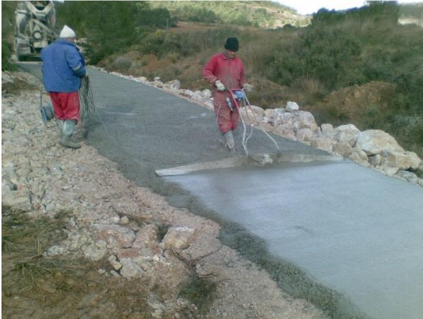
Foto 52. Hormigón en masa armado con fibras de polipropileno. Fuente: Propia.
