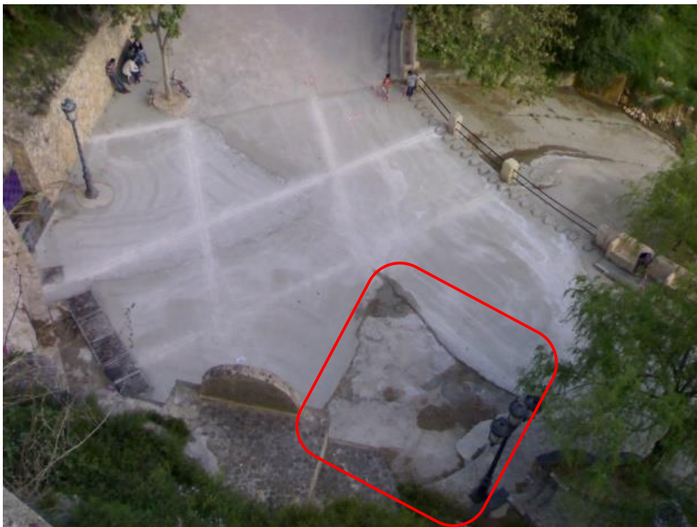
Foto 58. Pavimento hormigón inacabado pero, con juntas dilatación.
