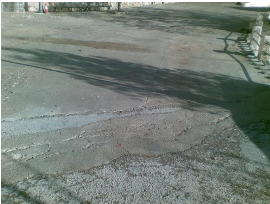
Foto 55. Estado previo firme acceso aldea de El Oro.
