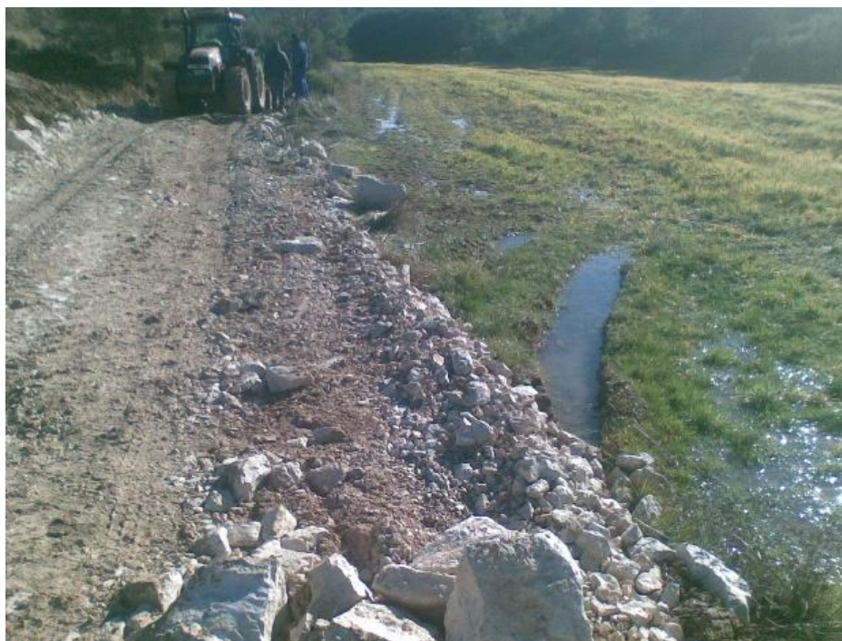
Foto 51. Excavación 1,30m y relleno de macádan.
