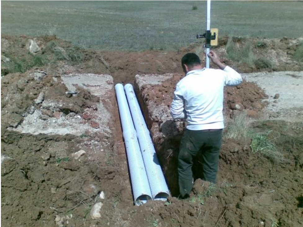
Foto 54. Colocación tubos de drenaje con pendiente adecuada.
