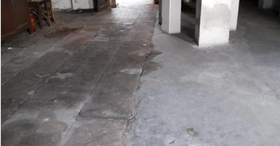
Figura 57. Fotografía pavimento hormigón y piedra natural. Fuente propia.
